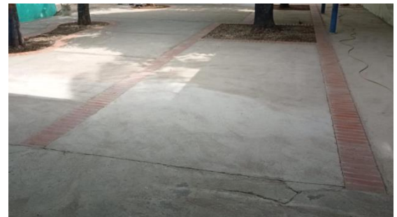
Corte con pulidora para dilataciones y aplicación de epóxico
