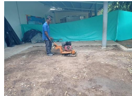
Relleno seleccionado incluye suministro y compactación
