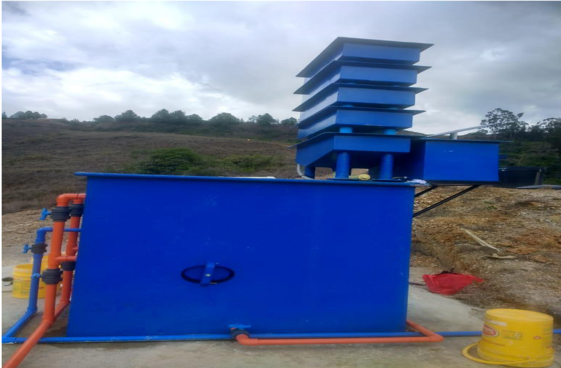
Ilustración 26: Referencia de Planta de tratamiento agua potable tipo MODUPACK E.
