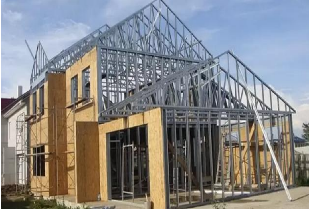
Ilustración 17: Ejemplo de referencia de estructura metálica tipo Sistemas estructurales de resistencia sísmica con perfiles de lámina formada en frío para Edificaciones de dos pisos.: Fuente: https://www.forbesargentina.com/negocios/steel-framing-como-construir-mas-rapido-forma-sustentable-menor-costo-n57768
