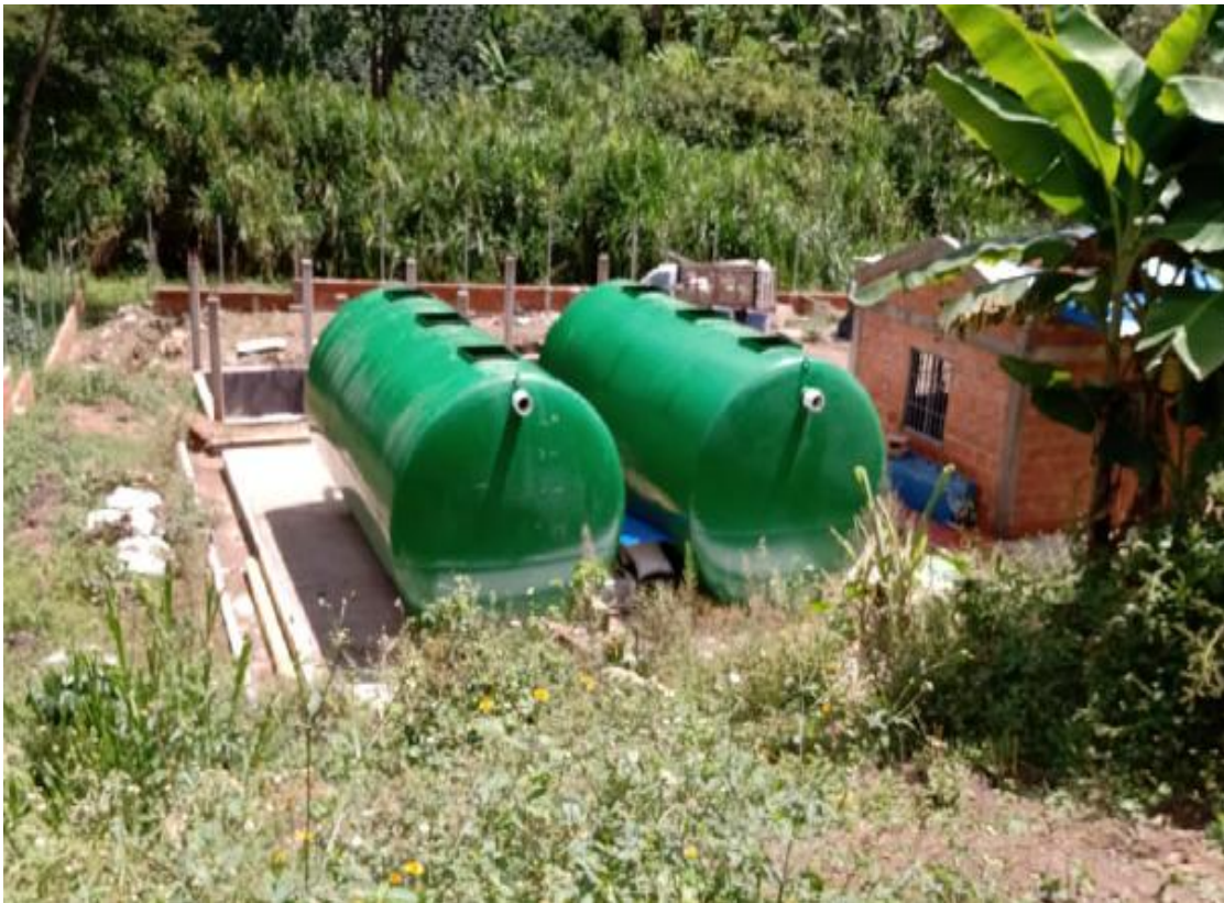
Ilustración 25: Esquema de sistema PTAR tipo ACUARAP 0.5 lt/s.
