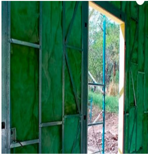
Ilustración 3: Aislamiento termoacústico tipo frescasa 3 1/2" sistema EIFS.
