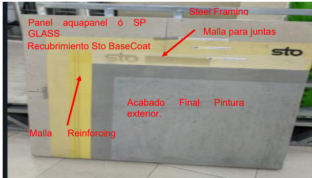
Ilustración 2: Detalle de revestimiento envolvente exterior de Muros tipo Sistemas estructurales de resistencia sísmica con perfiles de lámina formada en frío . (DEFS), Fuente vitrina Multiobras – Paloquemao (Bogotá D.C)
