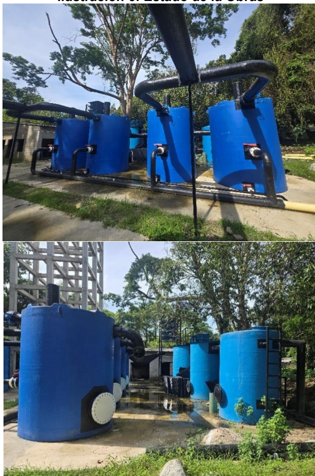
Ilustración 6: Estado de la Obras
