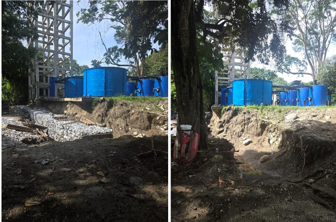
Ilustración 7: Fase I. Estado de las Obras
