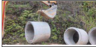
instalacion de tuberia en concreto baticola 2 alcantarilla
