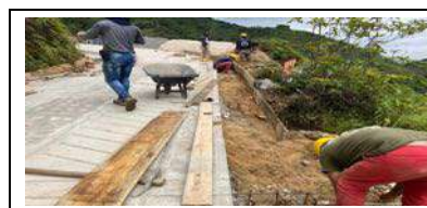
encofrado de cuneta baticola
