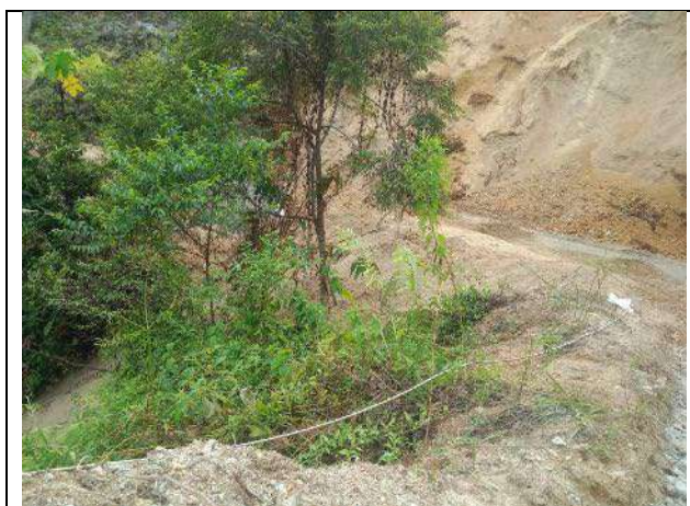
Manguera proveniente de la captación
