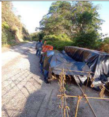
Almacenamiento de hierro figurado
