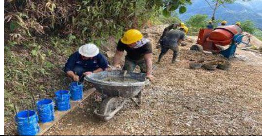
TOMA D EMUESTRA DE CONCRETO TRAMO SAN PEDRO
