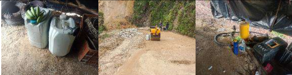
Almacenamiento de combustible sin identificación, sin garantizar la compatibilidad de sustancias
