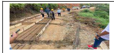
instalacion de acero y formatetas sector cajones
