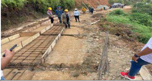
INSTALACION ACERO PLACA HUELLAS TRAMO SAN PEDRO
