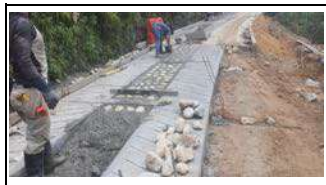
construcion placa huellas en sector baticola
