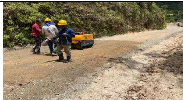
HUMECTANDO SUBBASE TRAMO BETANIA
