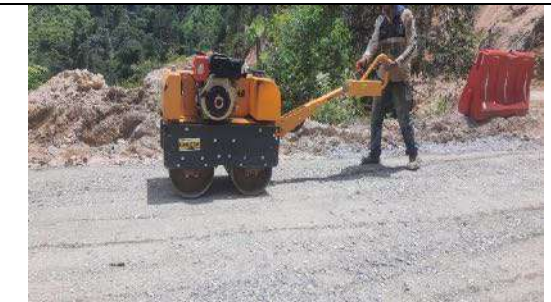
EXTENDIDA DE SUBBASE TRAMO BETANIA
