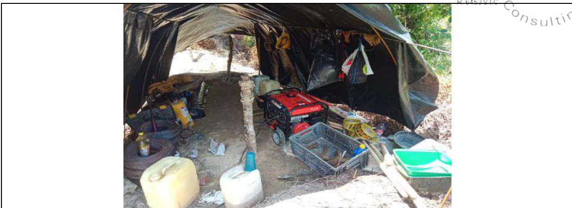
Suelo sin protección, sustancias químicas sobre suelo sin dique de contención etc
