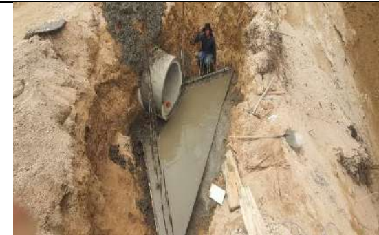
CONSTRUCCIN DE DESCOLE ALCANTARILLA BETANIA
