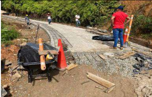
CONSTRUCCION PLCA HUELLAS TRAMO SAN PEDRO
