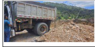
suministro sub base tramo 1 Baticola
