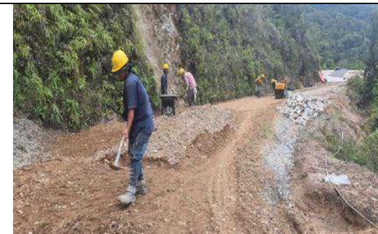
EXTENDIDA DE SUBBASE TRAMO BETANIA
