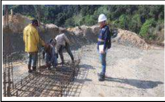
amarre y armado de parrillas en acero para placa entre aletas y aletas sector 1 tramo 1 baticola
