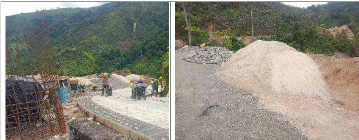
Manejo de materiales de construcción .
