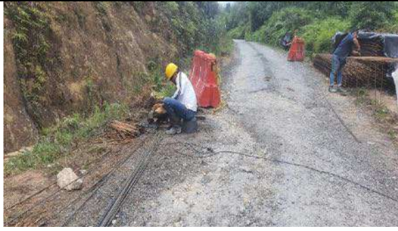
Personal sin las protecciones auditivas y el mal uso de Iso EPP
