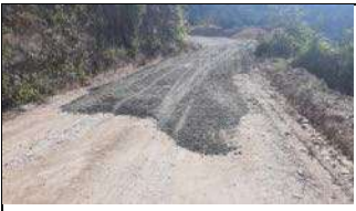
instalacion de sub base tramo 1 Baticola
