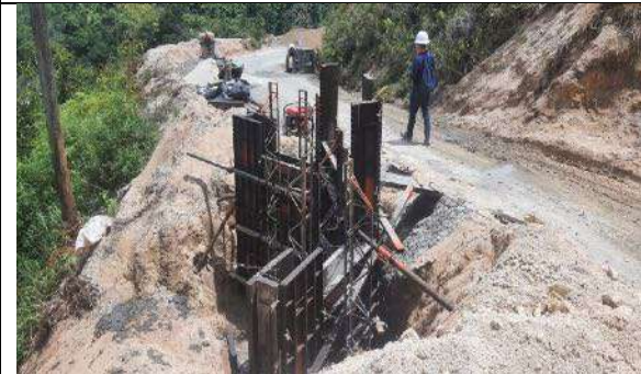
CONSTRUCCION DE ALETAS ALCANTARILLA BETATANIA
