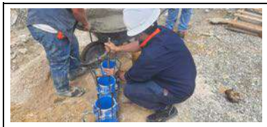
toma de muestra de concreto
