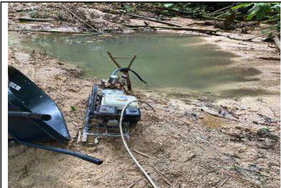
Motobomba, para captación de agua
