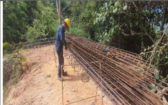
CORTE Y FIGURADO DE ACERO SAN PEDRO
