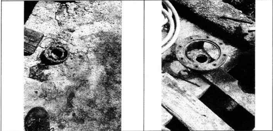
CAMBIO DE RODAMIENTO DE BOMBA LINEA No.2 CASETA EL JARDIN
