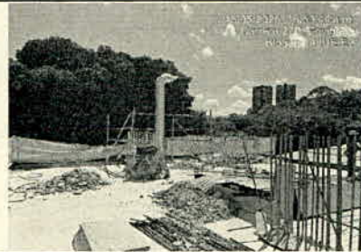
DESCRIPCIÓN: Demolición del concreto simple de protección del acero de refuerzo en columnas piso 3
