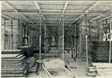
DESCRIPCIÓN: Adecuación de obra falsa para vaciado de losas P4
