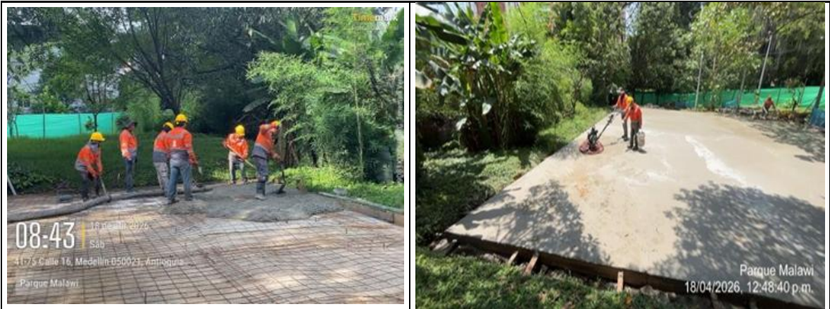
Instalación de malla electrosoldada D-84 - Vaciado y pulido con helicóptero de losa central en concreto premezclado de 21 Mpa.
