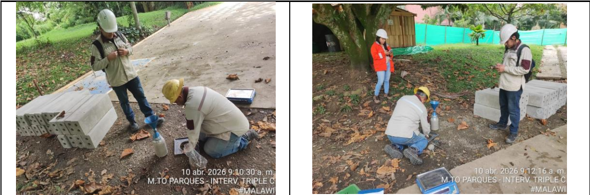
Realización de ensayos de densidad al material de entresuelo puesto y compactado
