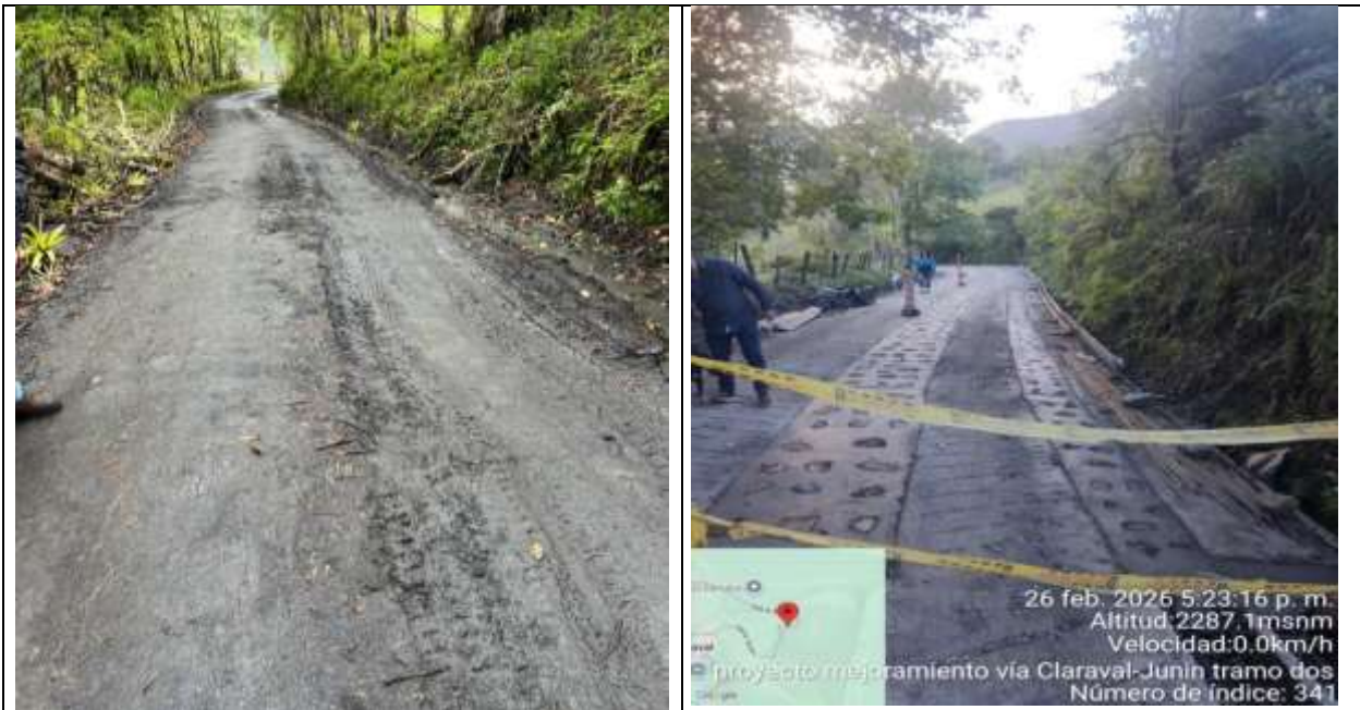
TRAMO 2. JUNÍN – CLARAVAL (PLACA HUELLA EXISTENTE)
