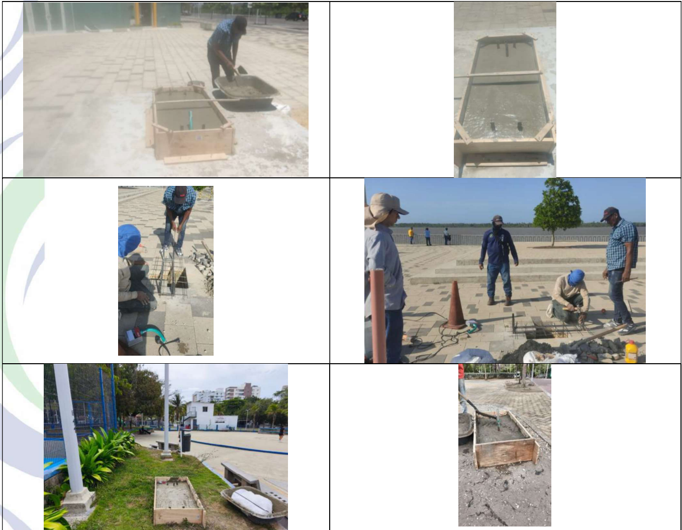
Imagen 2 – Fundición Bases Cemento
