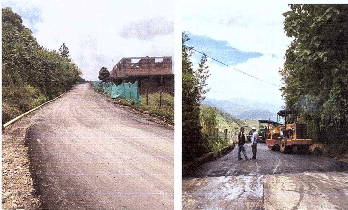
Figura 5: Registro fotográfico, construcción de capa de rodadura con concreto asfáltico.
