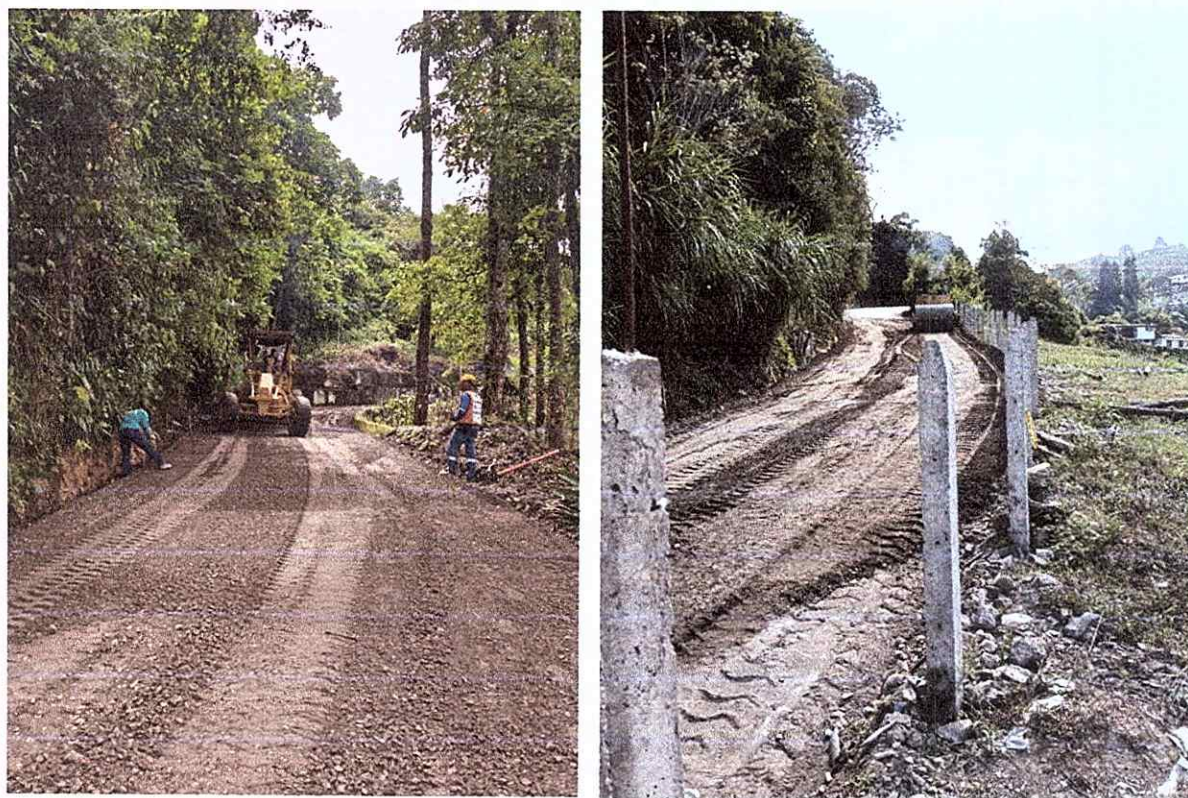
Figura 4: Registro fotográfico, construcción de capas granulares
