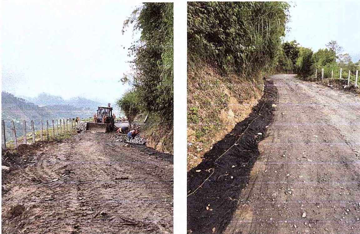
Figura 3: Registro fotográfico, construcción de obras de drenaje.
