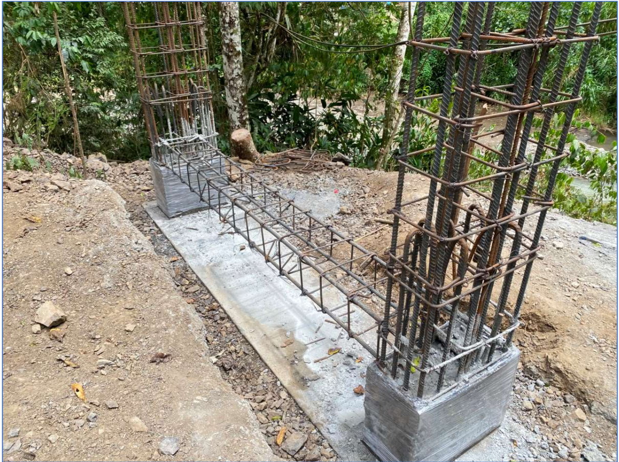
revisión y liberación de aceros para viga corrida de conexión entre columnas de las torres en el lado 1 -2
