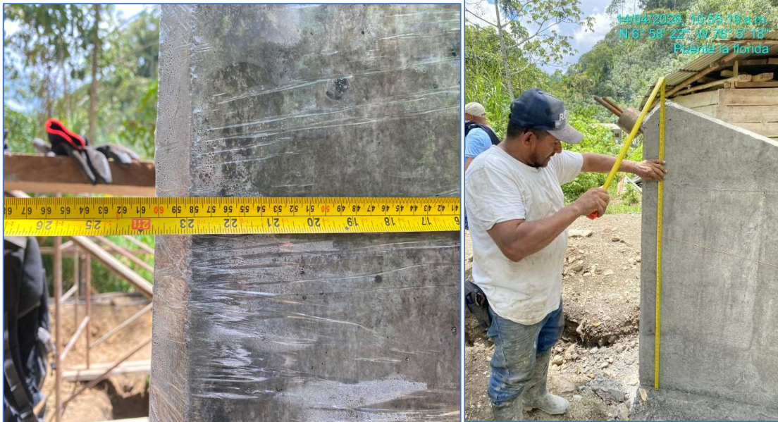
fotografía 3. Construcción de concretos para cimentaciones y estructuras en concretos – liberación de geometrías.
