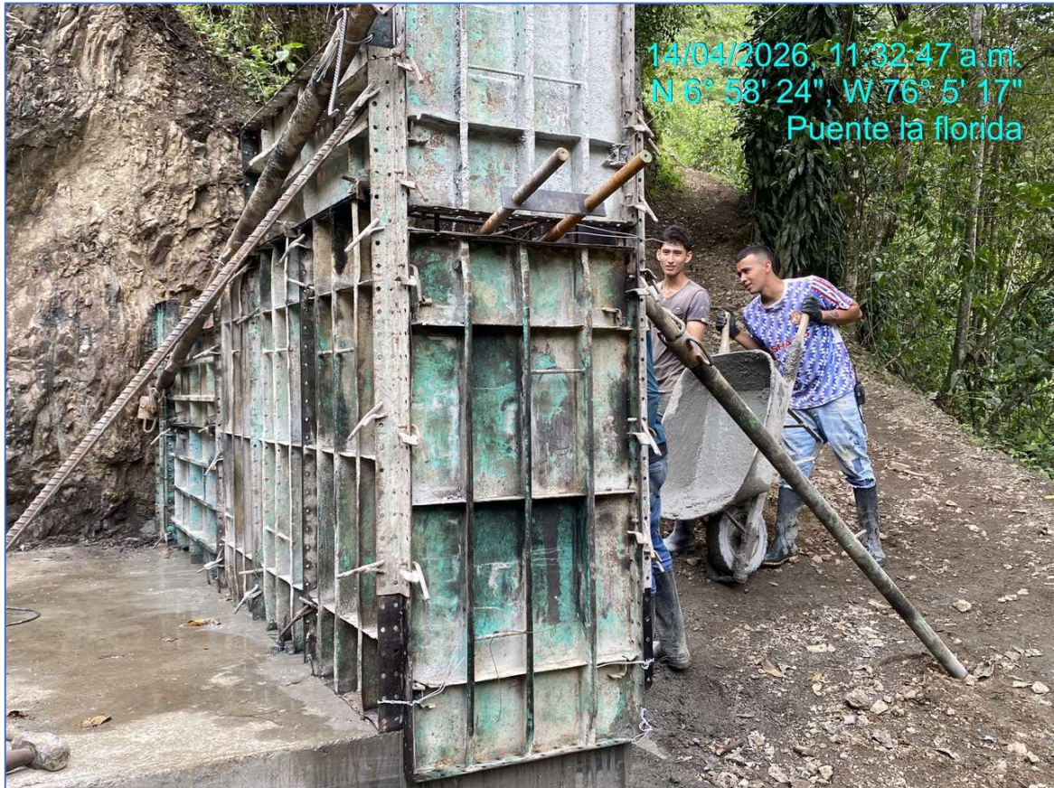
fotografía 4. Concreto para Muro contrafuertes
