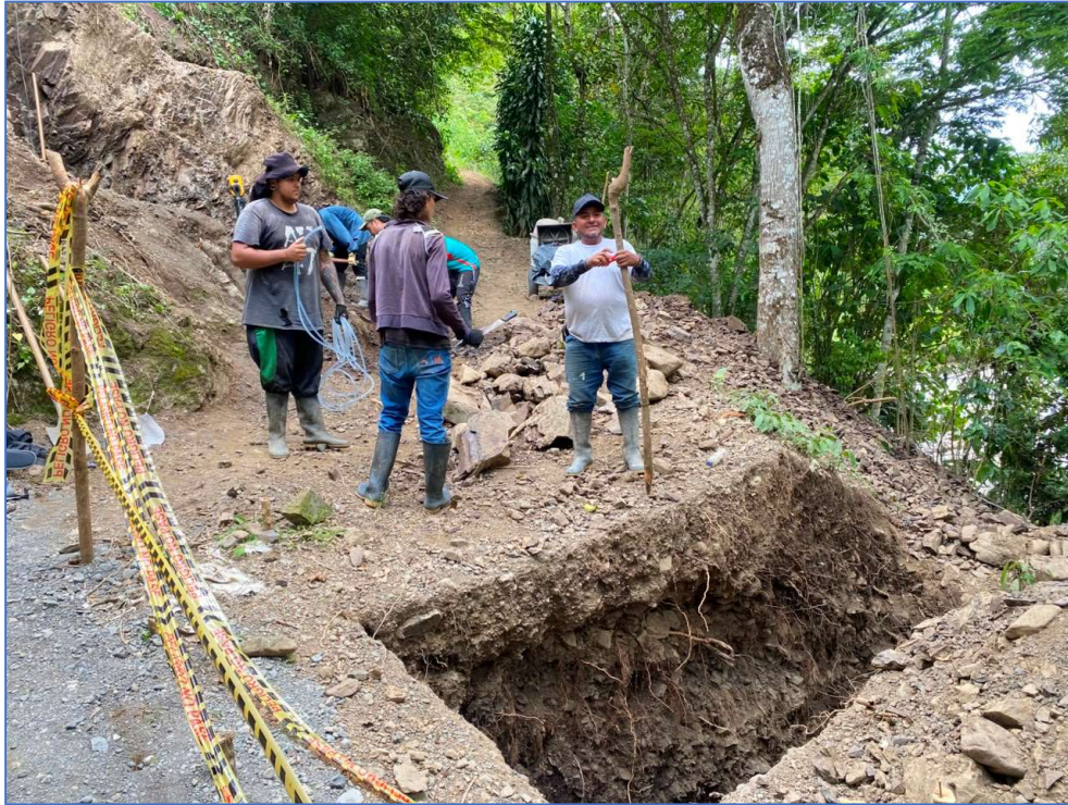
fotografía 2. Excavaciones manuales
