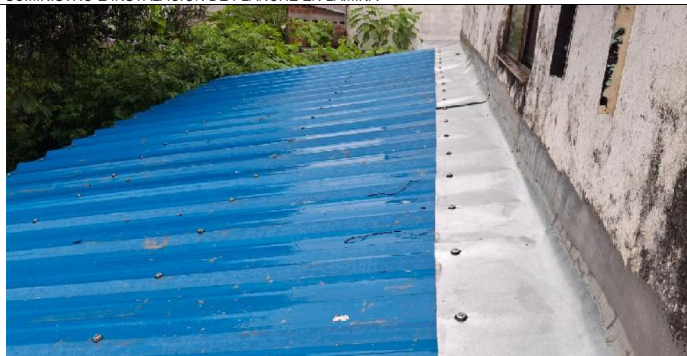
8.4 SUMINISTRO E INSTALACION DE FLANCHE EN LAMINA
