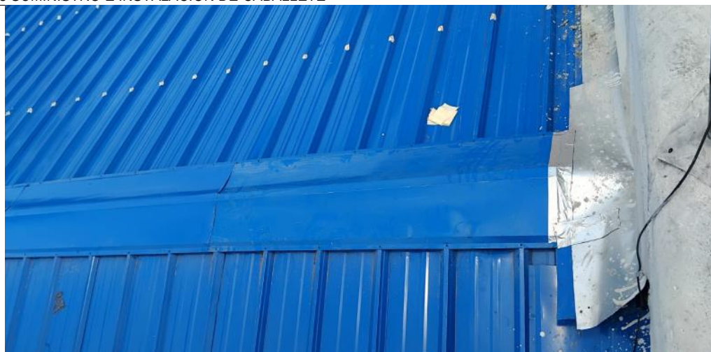
8.4 SUMINISTRO E INSTALACION DE FLANCHE EN LAMINA
