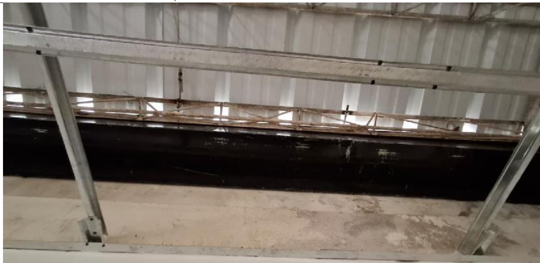
8.3 SUMINISTRO E INSTALACION DE CABALLETE
