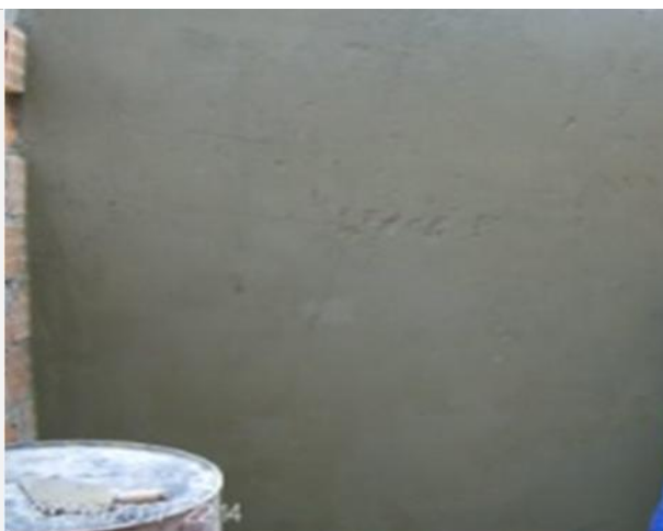
3.3 ESTUCO PLASTICO SOBRE MURO
