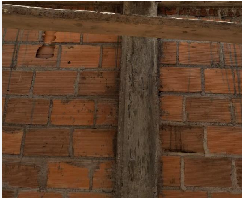
3.2 PAÑETE SOBRE MUROS (INCLUYE IMPERMEABILIZANTE)
