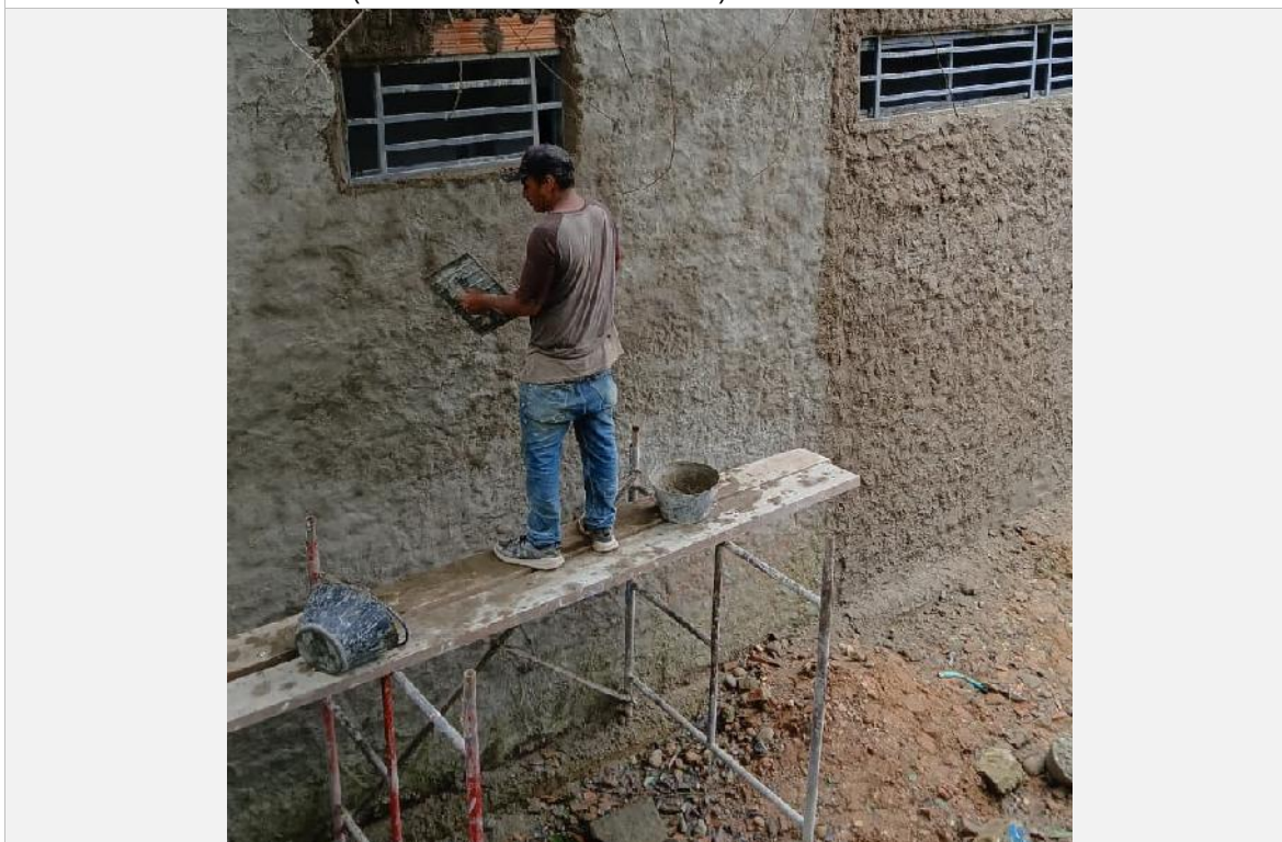
3.3 ESTUCO PLASTICO SOBRE MURO
