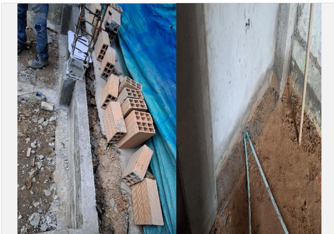
3.2 PAÑETE SOBRE MUROS (INCLUYE IMPERMEABILIZANTE)
