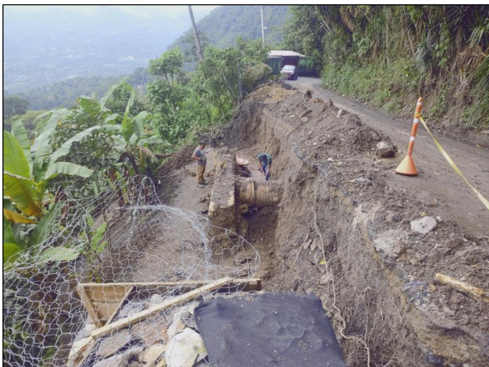
Ilustración: elemento estructural encontrado, incluye muro Aleta y tubo en concreto
