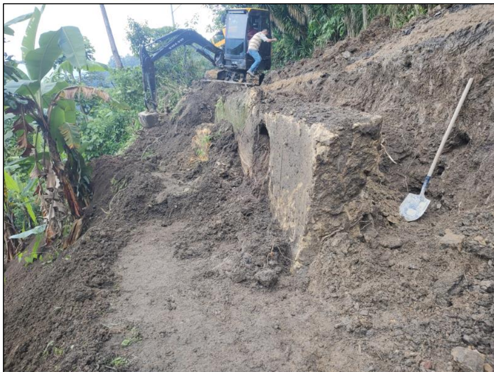
Ilustración: elemento estructural encontrado en la excavación de la caja
