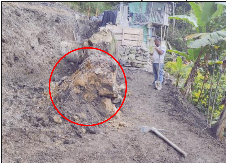
Ilustración: elemento estructural encontrado, incluye muro Aleta y tubo en concreto
