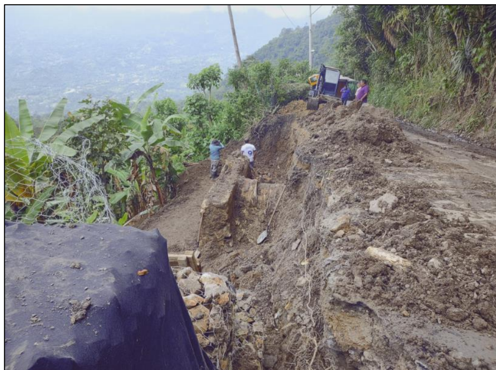
Ilustración: Elemento estructural encontrado al realizar la excavación
