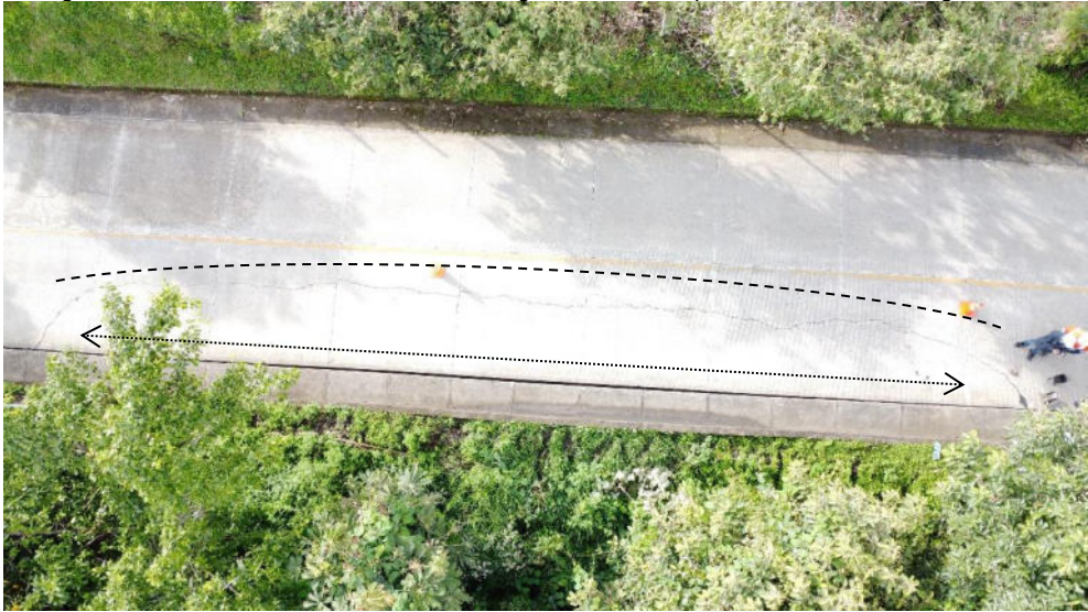
Fotografía 56. DESPUÉS de sellar fisura de Longitud 26.00m. Separación de cuneta Longitud 32.00m
