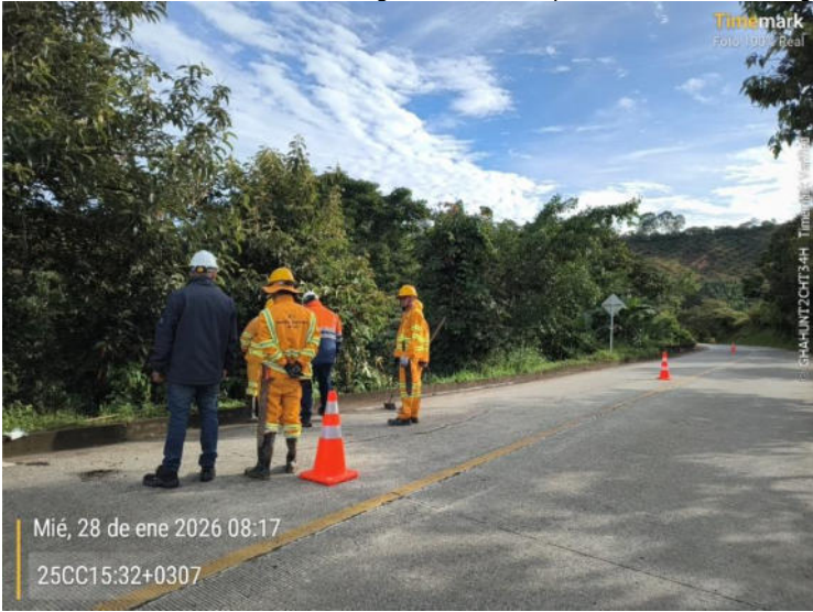
Fotografía 58. DURANTE sello de fisura de Longitud 26.00m. Separación de cuneta Longitud 32.00m
