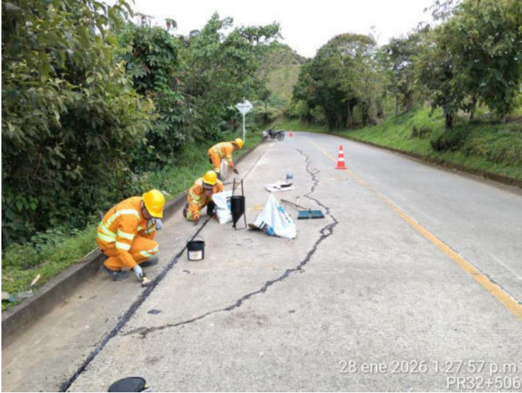
Fotografía 57. DURANTE sello de fisura de Longitud 26.00m. Separación de cuneta Longitud 32.00m
