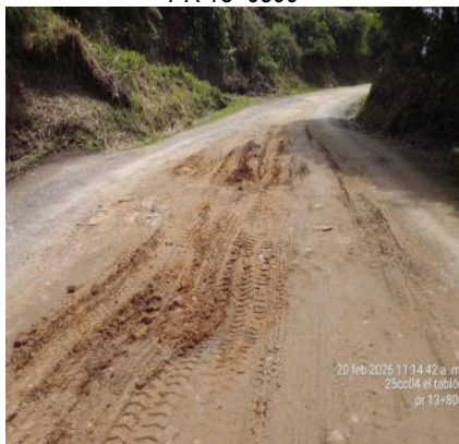
Fotografía 9. Sitio crítico antes PR 13+0800
