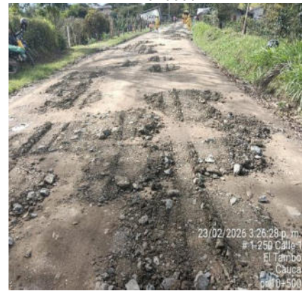
Fotografía 3. Sitio crítico después PR 10+0500
