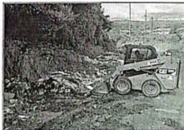
Imagen 13. Evacuación de RCD en el punto crítico
