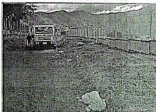
Imagen 11. Evacuación de RCD en el punto crítico
