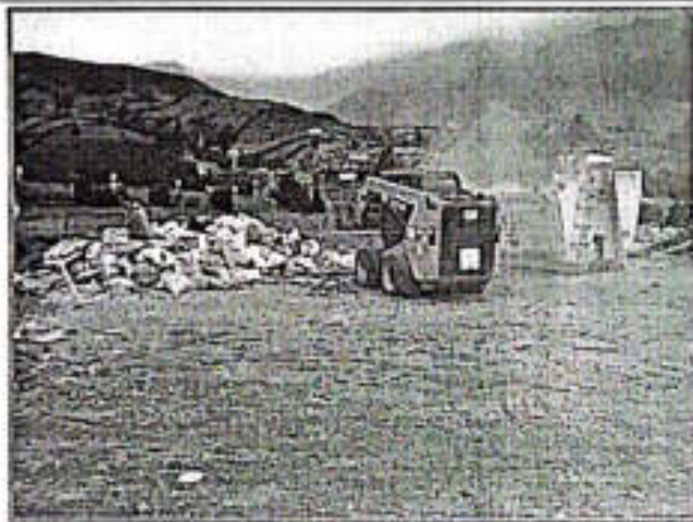
Imagen 1. Levantamiento y evacuación de RCD
