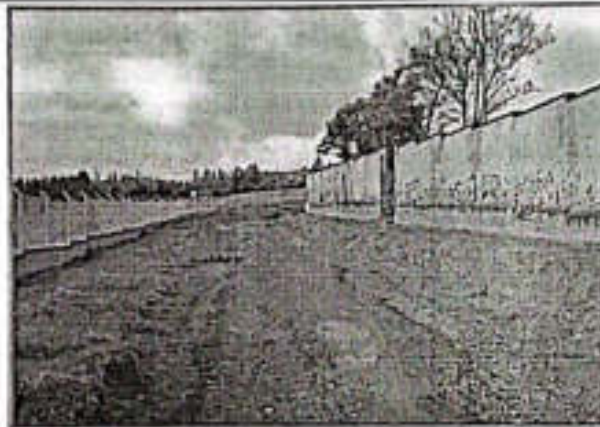
Imagen 12. Evacuación de RCD en el punto crítico
