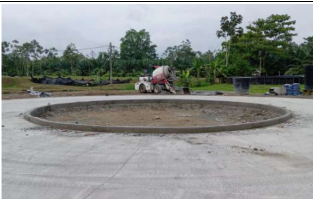
Registro 5. Trabajos de construcción de bordillos zona rotonda
