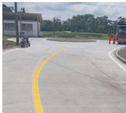
Registro 10. Trabajos de demarcación pintura zona rotonda.
