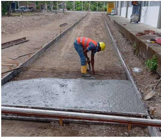
Registro 1. Trabajos de fundición de losa de concreto zona posterior laboratorio Agroindustrial.
