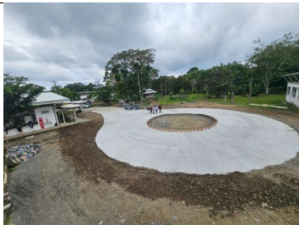
Registro 8. Trabajos de fundición de losa de concreto rotonda
