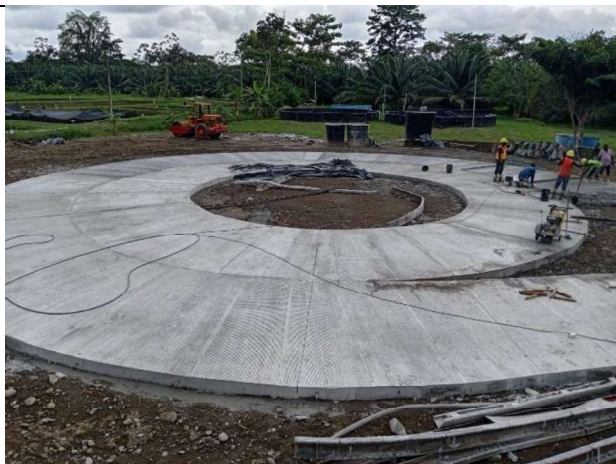
Registro 7. Trabajos de fundición de losa de concreto rotonda
