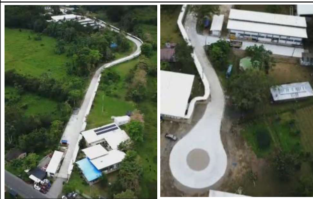
Registro 12. Toma aérea pavimento vía, rotonda y zonas de parqueo.
