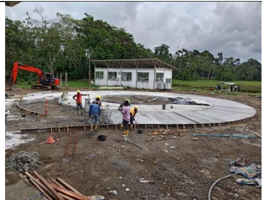
Registro 6. Trabajos relleno zona final vía - rotonda.
