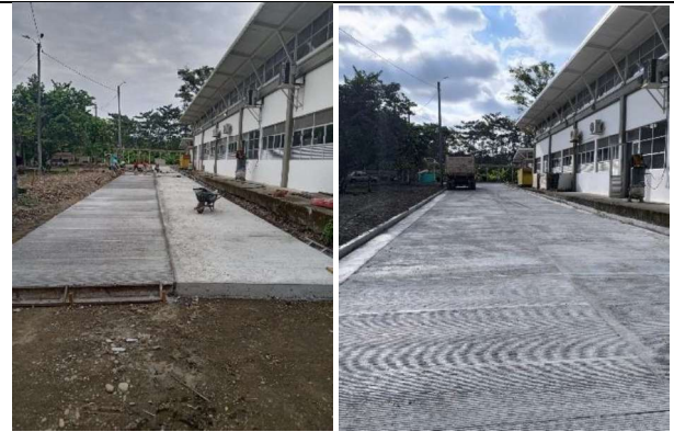
Registro 4. Trabajos zona parte posterior laboratorio de Agroindustria.
