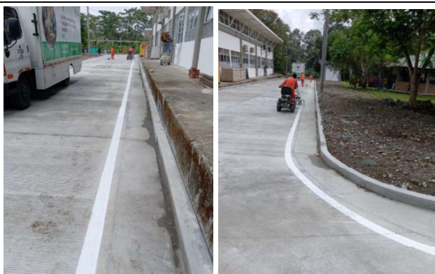
Registro 9. Trabajos de demarcación pintura zona parqueadero agroindustria.
