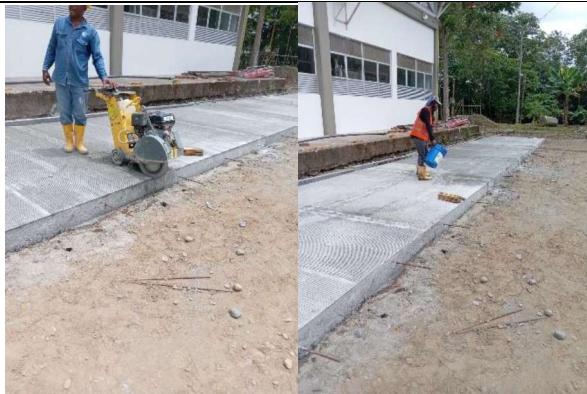
Registro 3. Trabajos de aplicación antisol para curado y corte de juntas entre paños.
