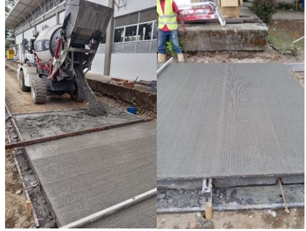
Registro 2. Trabajos de fundición de losa de concreto zona posterior laboratorio Agroindustrial.
