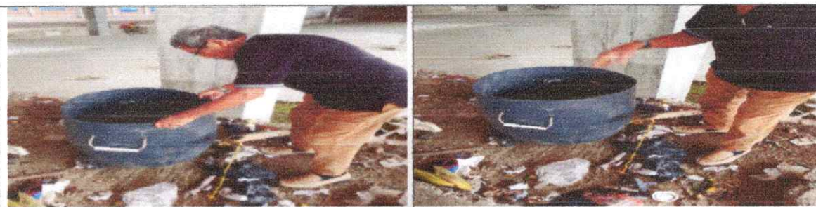
Anexo 2. Labores de adecuación, orden y acopio de residuos en las instalaciones municipales.
