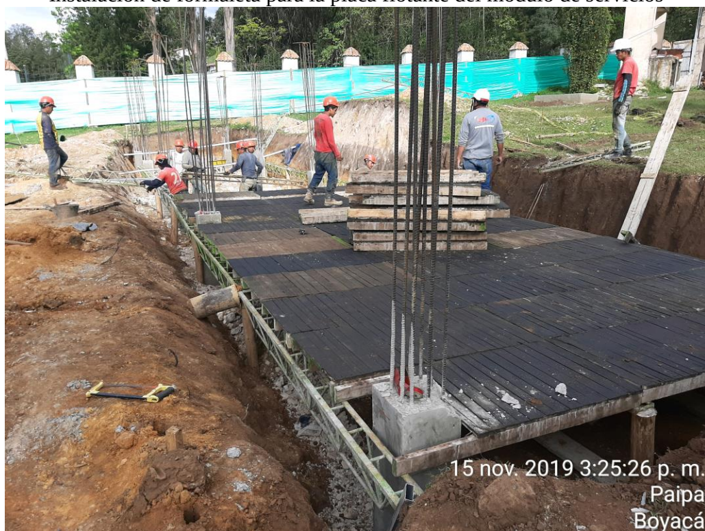
Instalación de formaleta para la placa flotante del modulo de servicios
