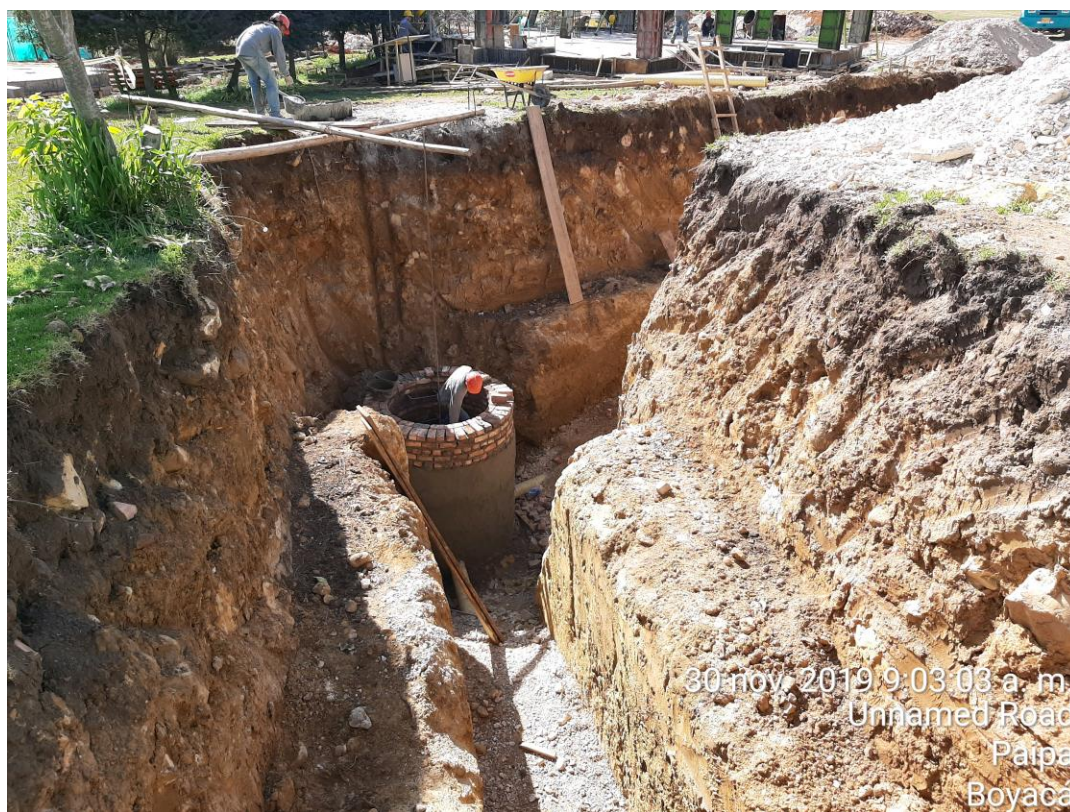
Excavación vía vehicular
