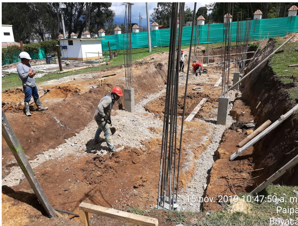
Instalación de formaleta para la placa flotante del modulo de servicios
