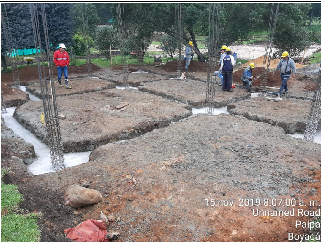
Vaciado de concreta cabaña numero 5
