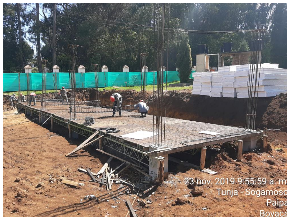
Armado de acero para placas aligeradas cabañas 05-11-12
