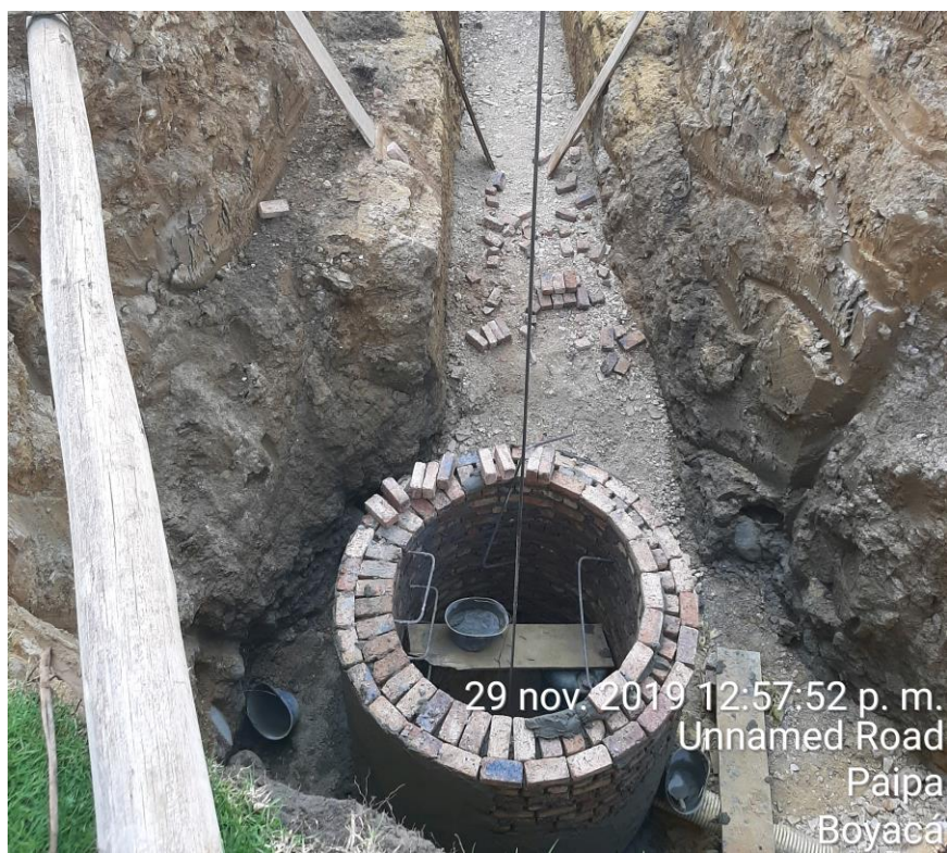
Ejecución pozo de aguas lluvias No 05
