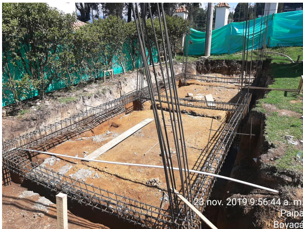
Armado de acero para placa aligerada módulo de servicios
