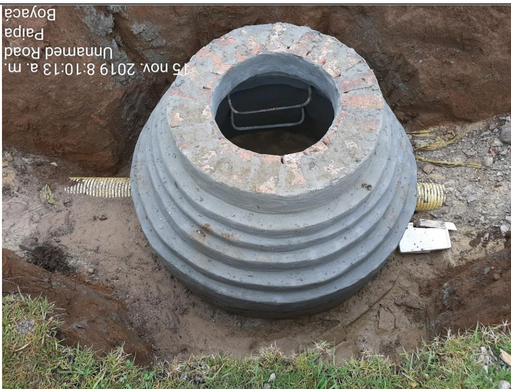
Ejecución pozo de aguas lluvias N0 04
