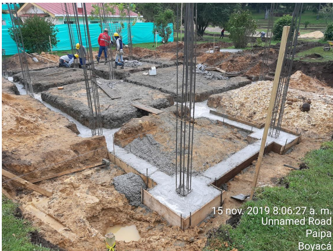
Vaciado de concreta cabaña numero 5
