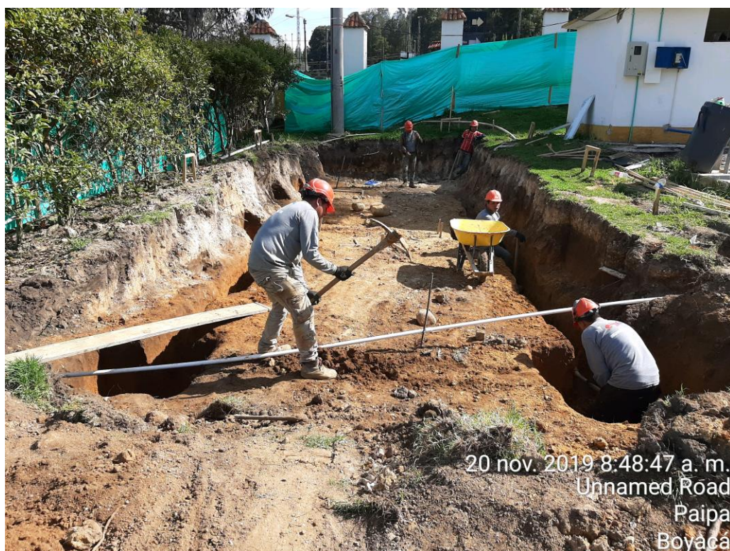
Excavación manual subestación eléctrica
