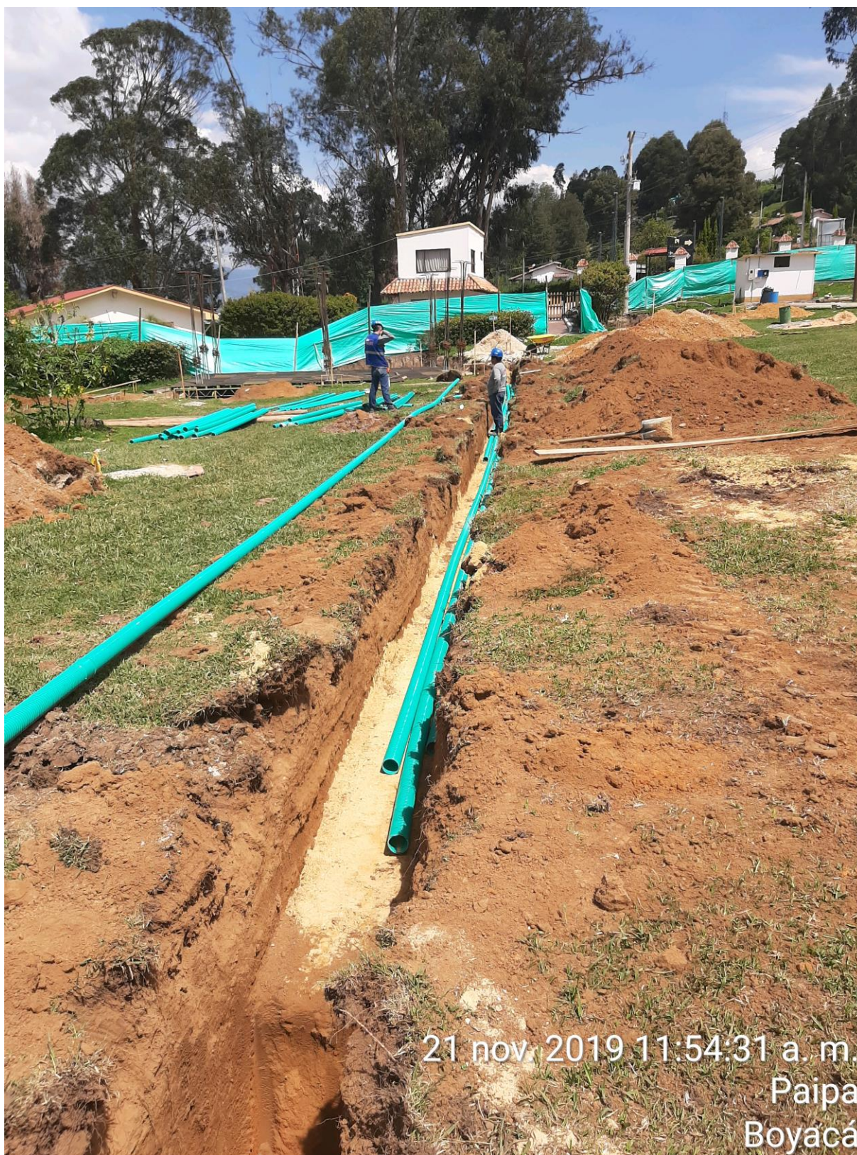
Ejecucion pozo de aguas lluvias No 03
