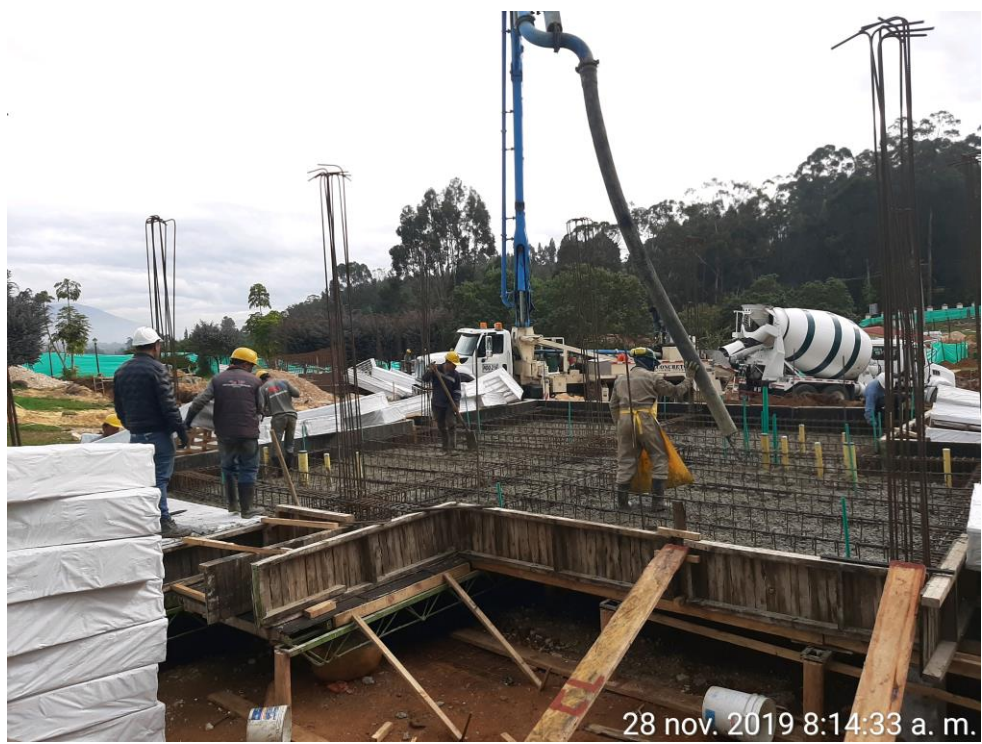
Vaciado de concreto para placas aligeradas cabañas 05-11-12
