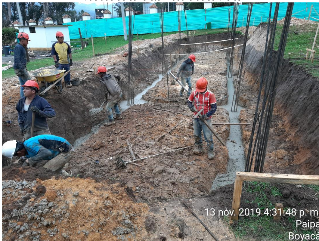
Vaciado de concreto modulo de servicios
