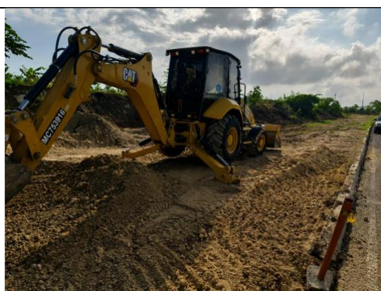
Ilustración No.2 Excavación de terreno a máquina.
