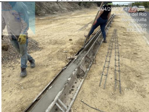
Ilustración No.7 Construcción de vigas de confinamiento para andenes.
