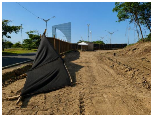
Ilustración No.4 Instalación de cerramiento provisional en polisombra
