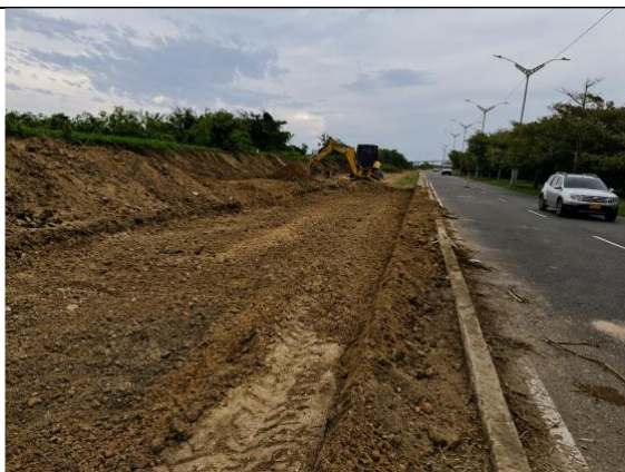
Ilustración No.9 Desmonte y descapote mecánico de material existente.
