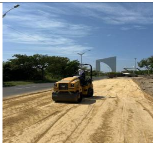
Ilustración No.10 Relleno en material seleccionado compactado
