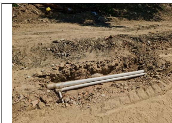
Ilustración No.1 Tubería PVC de 3" para red de agua potable
