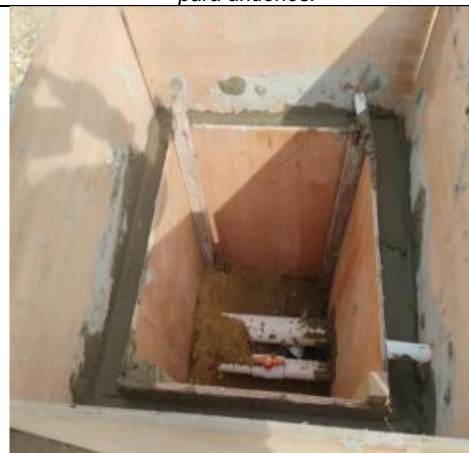
Ilustración No.8 Construcción de registro sanitario de 0.60m x 0.60m
