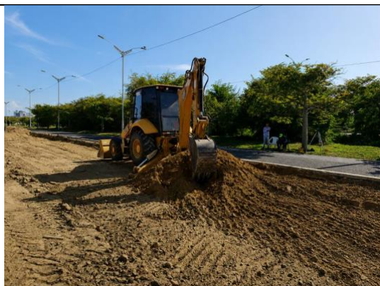
Ilustración No.3 Excavación de terreno a máquina
