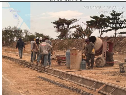
Ilustración No.6 Construcción de vigas de confinamiento para andenes.
