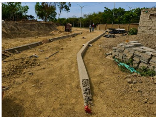
Ilustración No.5 Construcción de vigas de confinamiento para andenes.
