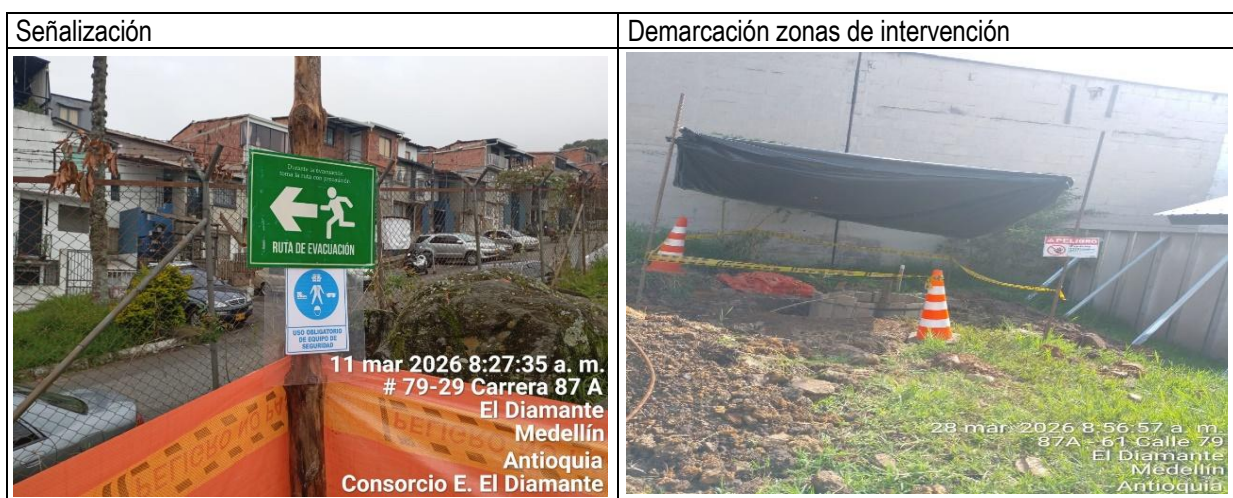
Imágenes. Delimitaciones y señalización en obra
