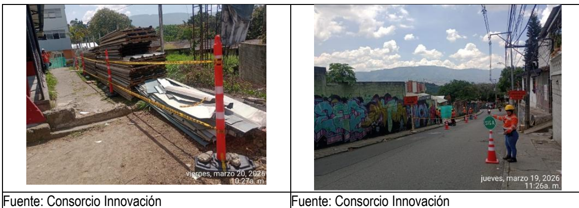
Imágenes. Delimitaciones y señalización en obra
