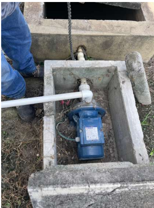
Imagen 31 y 32. Retiro de sistemas de bombeo para mantenimiento general y embobinado de bomba.
