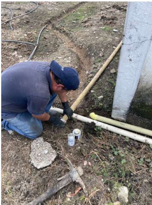
Imagen 61 a 64. Reparación sistema de rebose
