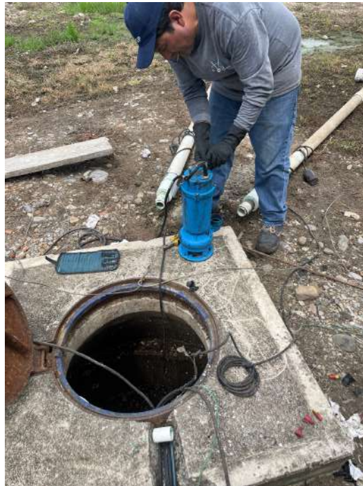
Imagen 33 y 36. Instalación de sistemas de bombeo después de mantenimiento general y embobinado de bomba.
