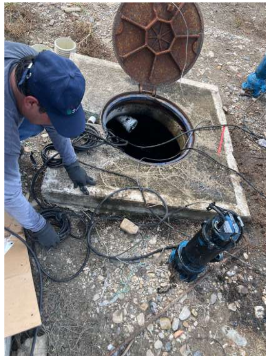
Imagen 31 y 32. Retiro de sistemas de bombeo para mantenimiento general y embobinado de bomba.
