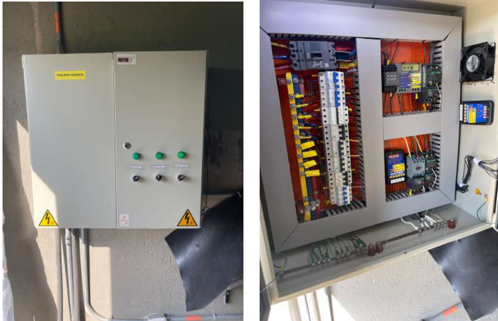
Imagen 28 y 29. Mantenimiento tablero eléctrico.
