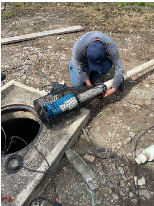
Imagen 33 y 36. Instalación de sistemas de bombeo después de mantenimiento general y embobinado de bomba.
