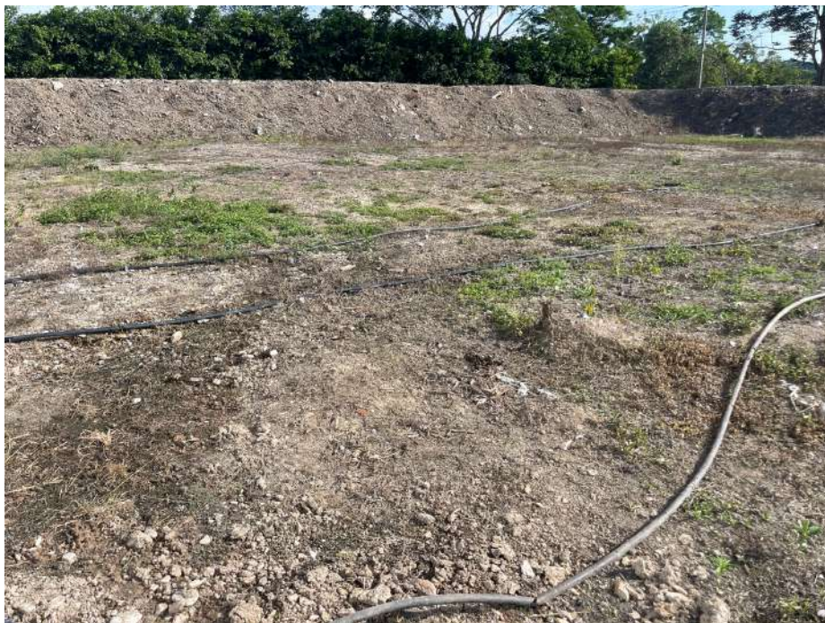
Imagen 57 a 60. Reparación sistema de riego
