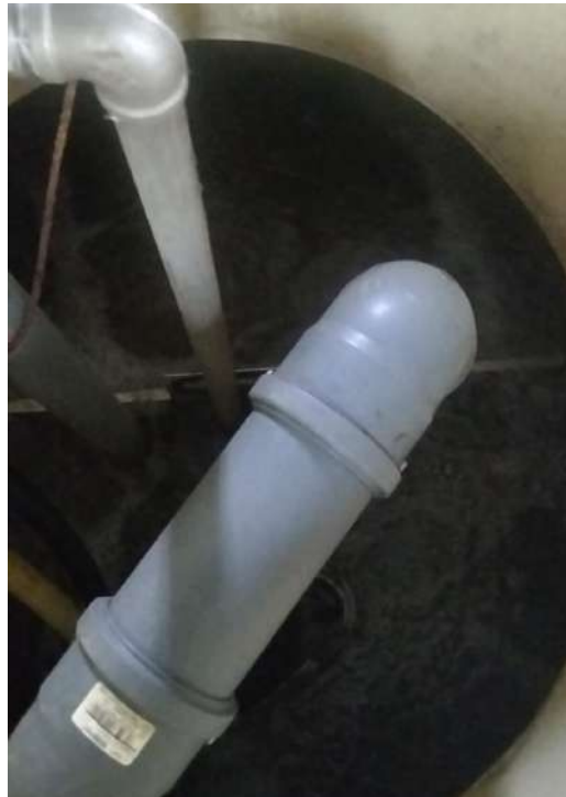
Imagen 20. Validación aireación sistema SBR
