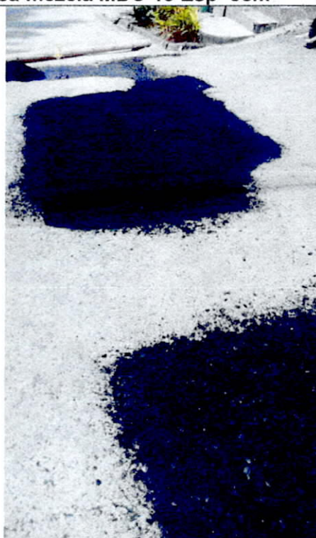
12- Relleno compactado con material de la excavación.
