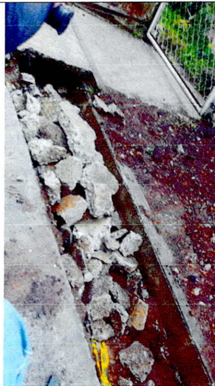
3- Excavación de material común y retiro de sobrantes.
