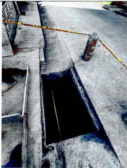
8- Suministro e instalación de rejilla marco 1'-1/4"X1/8", Contramarco 1"X1/8", Varilla de 1/2".
