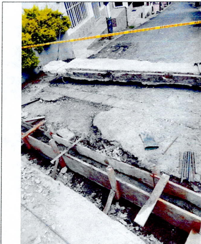
3- Excavación de material común y retiro de sobrantes.
