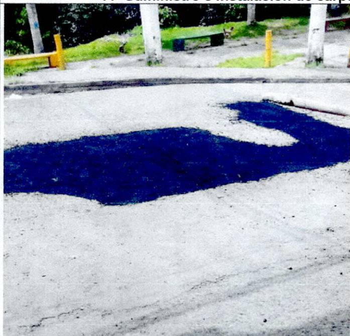
11- Suministro e Instalación de carpeta asfáltica mezcla MDC-19 Esp=8cm
