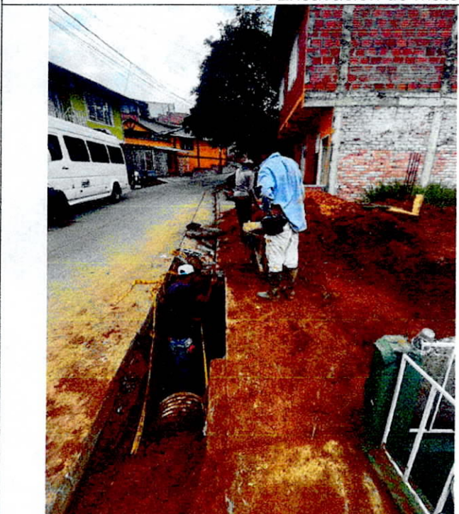
4- Suministro e instalación de tubería PVC unión mecánica para alcantarillado (16")-NP-1.
