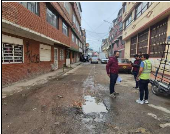
Estado actual del frente de obra
