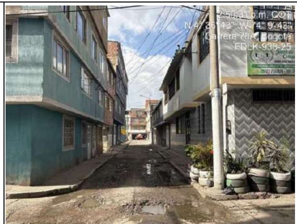
Estado actual del frente de obra
