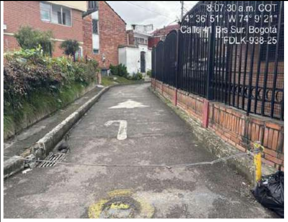
Estado actual del frente de obra
