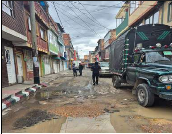
Estado actual del frente de obra
