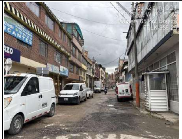
Estado actual del frente de obra
