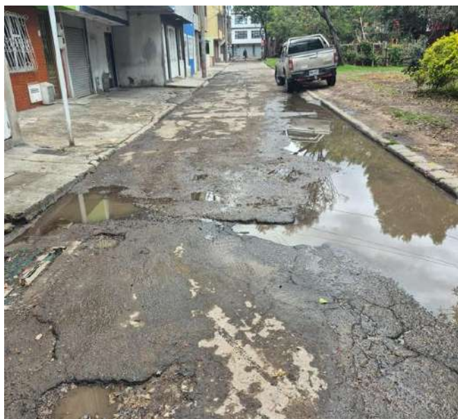
Civ's a Construir Barrio Jackeline
