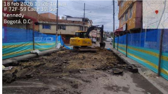
ILUSTRACIÓN 1 FRENTE DE OBRA CAMPIÑA. FUENTE: SAVIMAC S.A.S.
