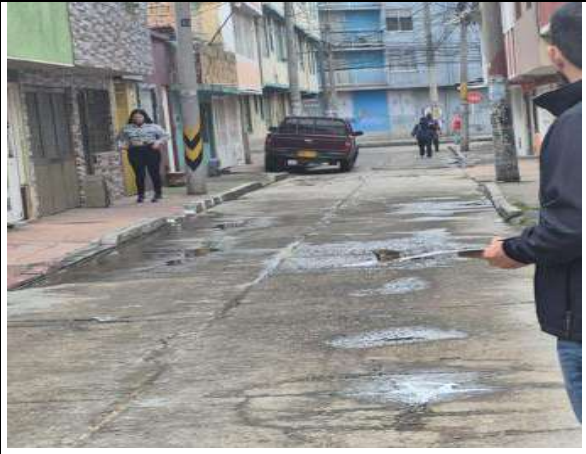
Estado actual del frente de obra
