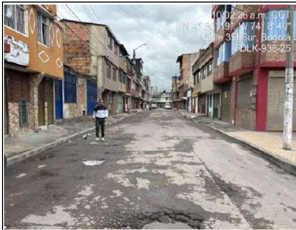
Estado actual del frente de obra
