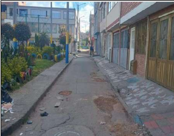
Estado actual del frente de obra
