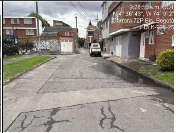
Estado actual del frente de obra
