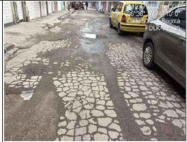
Estado actual del frente de obra
