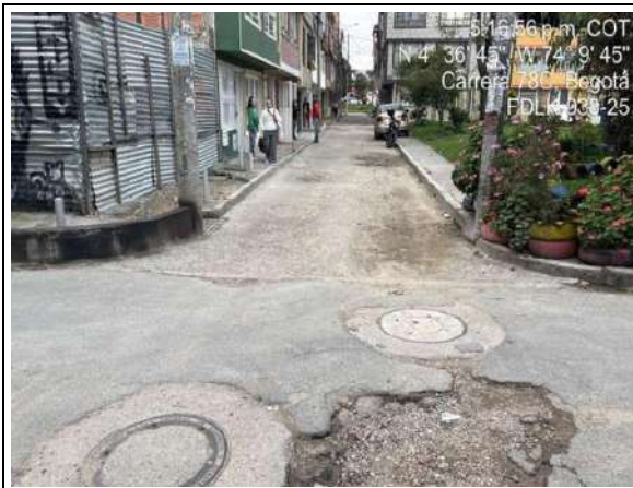
Estado actual del frente de obra
