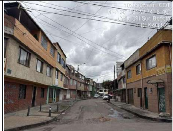
Estado actual del frente de obra
