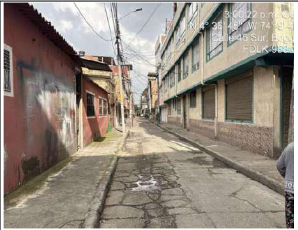
Estado actual del frente de obra
