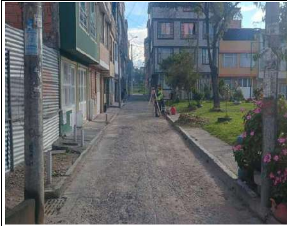
Estado actual del frente de obra
