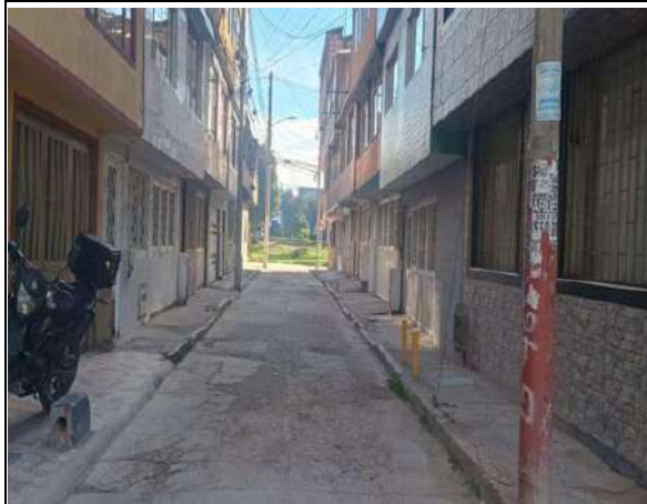
Estado actual del frente de obra
