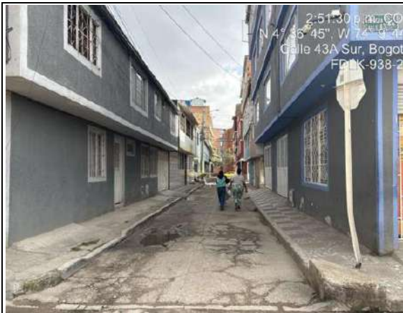
Estado actual del frente de obra
