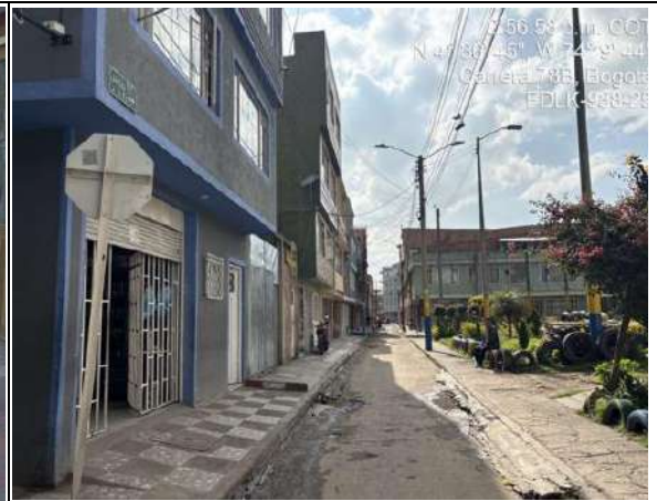
Estado actual del frente de obra
