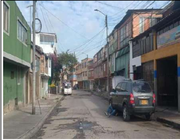
Estado actual del frente de obra
