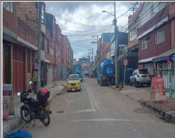
Estado actual del frente de obra
