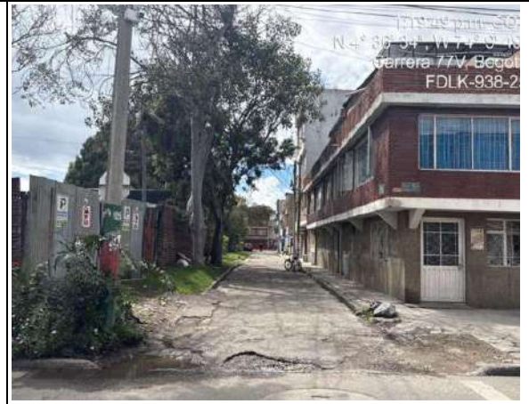
Estado actual del frente de obra
