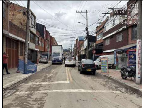
Estado actual del frente de obra
