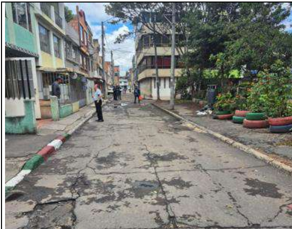
Estado actual del frente de obra
