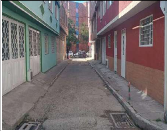
Estado actual del frente de obra
