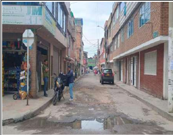
Estado actual del frente de obra
