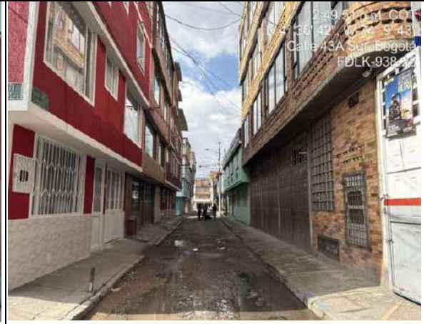
Estado actual del frente de obra
