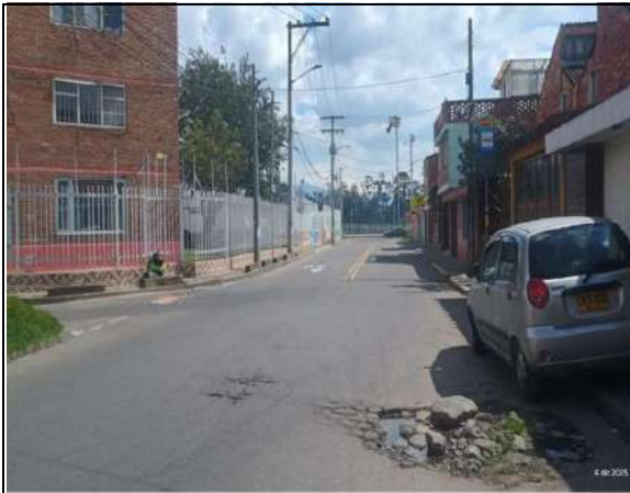
Estado actual del frente de obra
