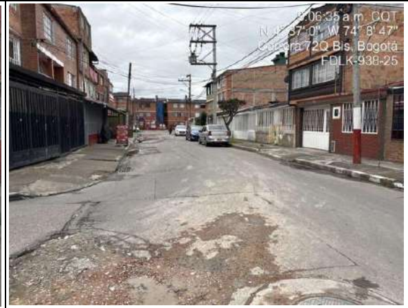
Estado actual del frente de obra
