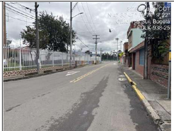
Estado actual del frente de obra
