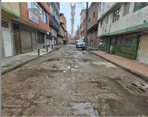
Estado actual del frente de obra
