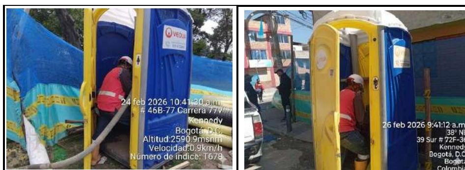
Imagen 5 Mantenimiento de Baños
