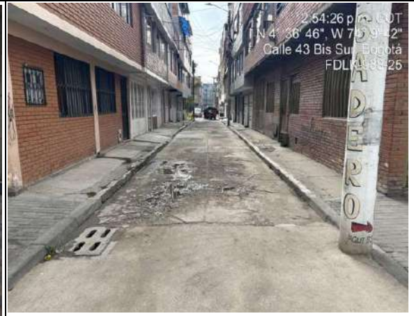
Estado actual del frente de obra
