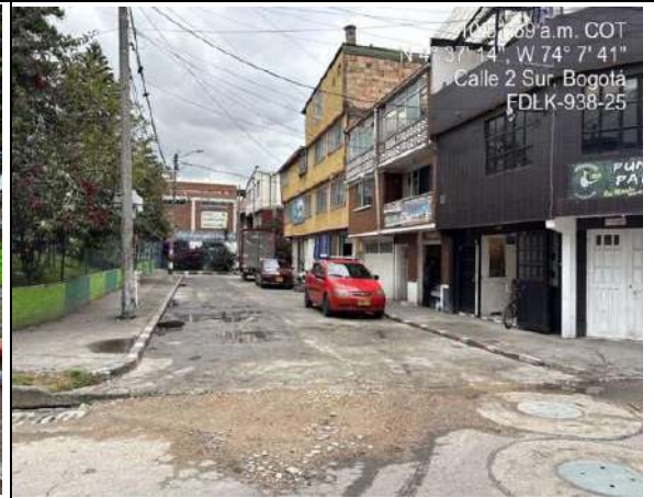
Estado actual del frente de obra
