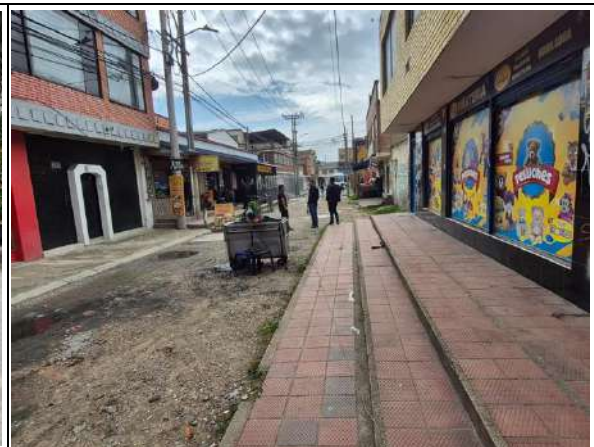
Estado actual del frente de obra
