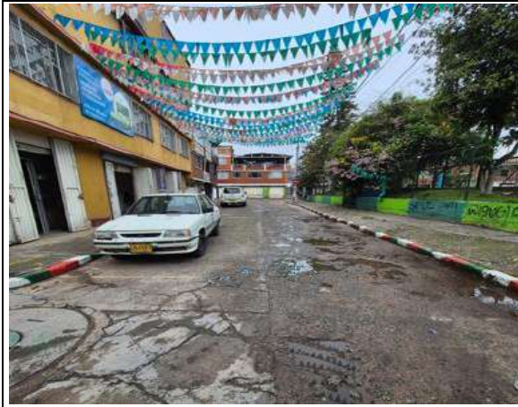
Estado actual del frente de obra
