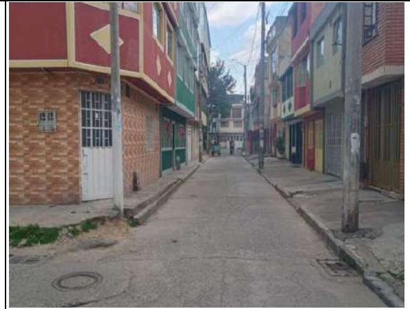
Estado actual del frente de obra
