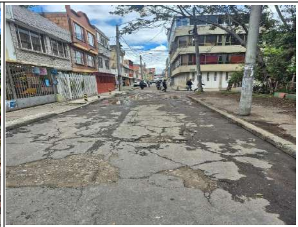
Estado actual del frente de obra
