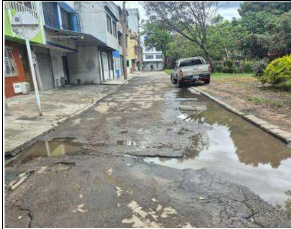
Estado actual del frente de obra
