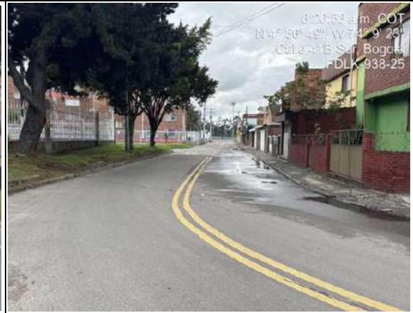
Estado actual del frente de obra
