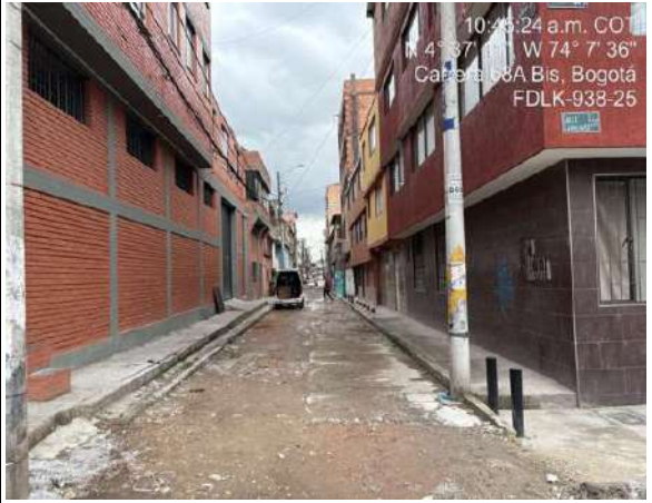
Estado actual del frente de obra
