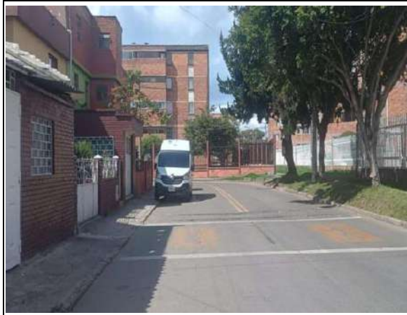
Estado actual del frente de obra
