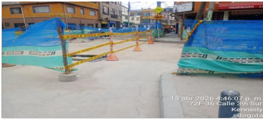
Mantenimiento de sendero peatonal CIV 8010914-8010695(N26-N27)
