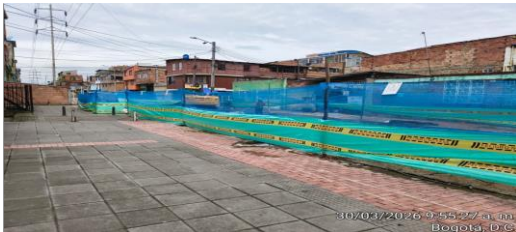
Mantenimiento de cerramiento perimetral CIV 8010826 (N29)
