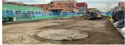
Céreo, compactación y nivelación de material AR-BG38 estabilizado CIV 8010826 (NC29).
