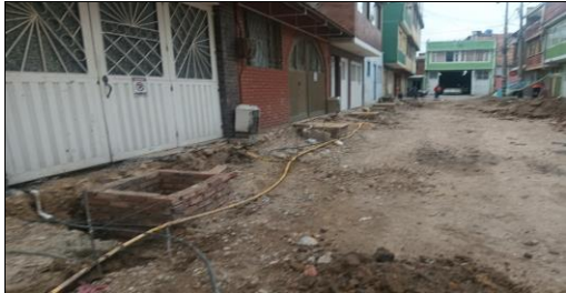
Construccion de cajas de inspeccion CIV 8009456 (NC11).
