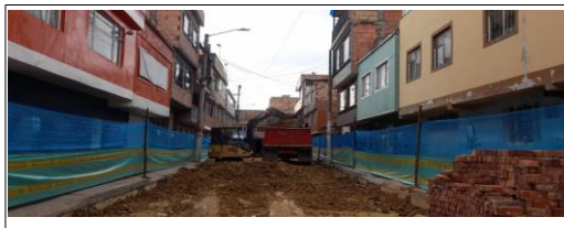
Cargue de volqueta, retiro y transporte de RCD de vía CIV 8009473 (NC12).
