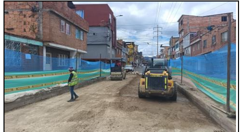
Céreo, compactación y nivelación de material AR-BG38 estabilizado CIV 8010826 (NC29).
