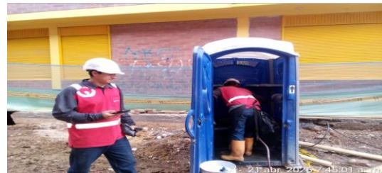
Mantenimiento de unidad sanitaria CIV 8009456-8009473 (N11-N12)
