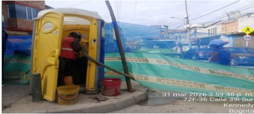
Mantenimiento de unidad sanitaria CIV 8010914-8010695(N26-N27)
