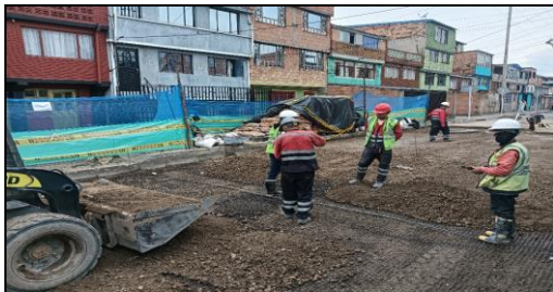
Instalación de Geomalla en vía CIV 8010826 (NC29).
