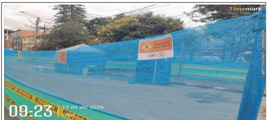
Señalización de sst en el siguiente CIV: 8006953-8006810
