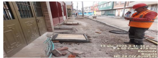
Instalación y nivelación de marcos y tapas para cajas de inspección CIV 8009549 (NC28).
