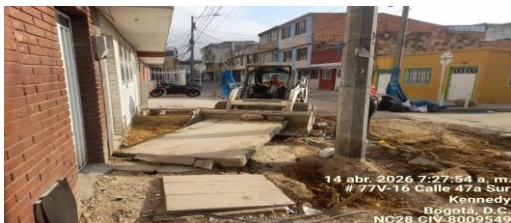
Demolición de espacio público CIV 8009549 (NC28).
