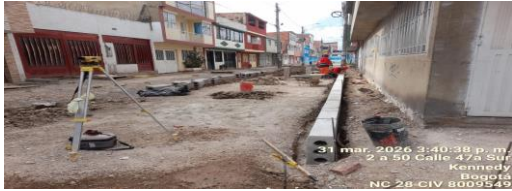
Instalación de prefabricados CIV 8009549 (NC28).
