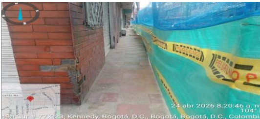
Mantenimiento de sendero peatonal CIV 8009327 (N3)
