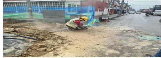
Corte de asfalto para conexión en red pluvial CIV 8007698 (NC24).
