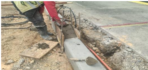
Construcción de hombros en concreto CIV 8010914 (NC26).
