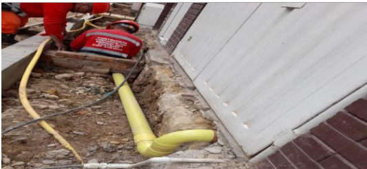
Construcción de cajas de inspección y adecuación de bajantes de agua sanitaria CIV 8009456 (NC11).
