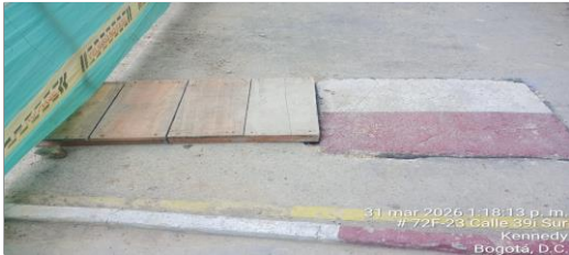
Plafonamiento y Adecuación Senderos peatonales
