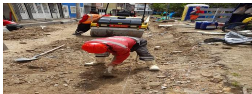
Excavación para instalación de prefabricados CIV 8009556 (NC6).
