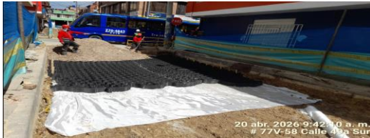
Instalación de geotextil, geo celda y subbase reciclada AR-SBG50 CIV 8009473 (NC12).
