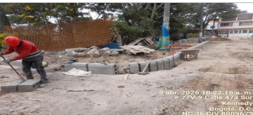
Excavación e instalación de prefabricados CIV 8009623 (NC36).
