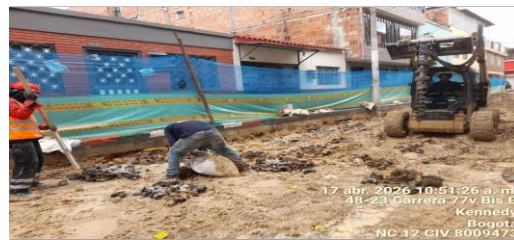
Marcación, perforación de barrenos e inyección de cal en vía CIV 8009473 (NC12).
