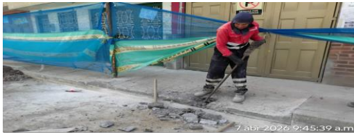
Demolición de rampa de acceso vehicular CIV 8010695 (NC27).
