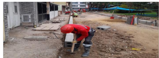
Instalación de prefabricados CIV 8009556 (NC6).
