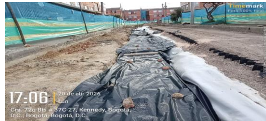
Mantenimiento de cerramiento perimetral CIV 8007698 (N24)
