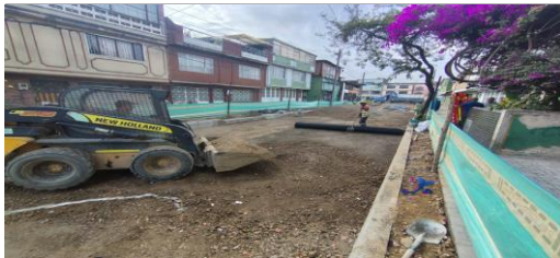
Instalación de geomalla y material estabilizado CIV 8010914 (NC26).
