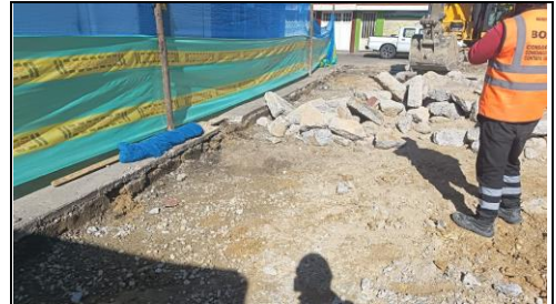
Demolición de concreto en vía CIV 8006810 (NC8).
