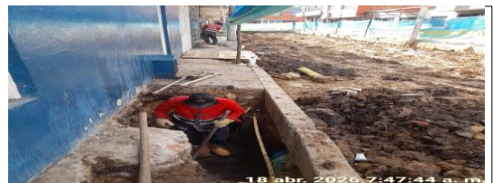
Demolición de cajas de inspección CIV 8009473 (NC12).
