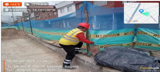
Mantenimiento de cerramiento perimetral CIV 8010826 (N29)
