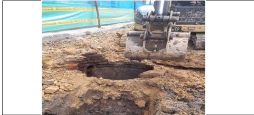
Demolición de pozo existente CIV 8009473 (NC12).
