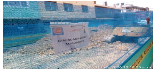
Instalación Señalización SST
