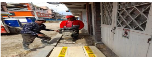
Instalación de material estabilizado y compactación con canguro en andén CIV 8009456 (NC11).
