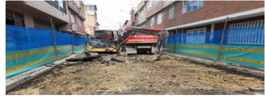
Demolición de carpeta asfáltica y cargue de material RCD 8009473 (NC12).
