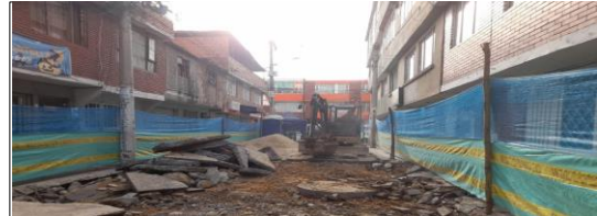
Demolición de placa en concreto vía CIV 8009327 (NC3).
