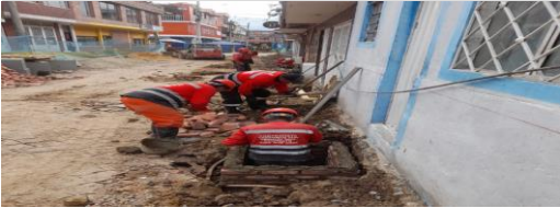
Construcción de cajas de inspección CIV 8009456 (NC11).
