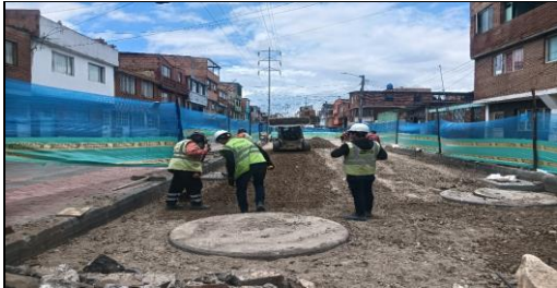
Céreo, compactación y nivelación de material AR-BG38 estabilizado CIV 8010826 (NC29).
