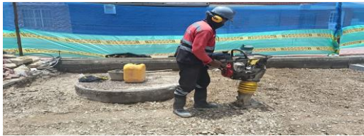
Compactación del terreno en zonas críticas CIV 8010826 (NC29).
