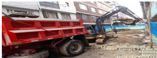
Cargue de volqueta, retiro y transporte de RCD de vía CIV 8009327 (NC3).
