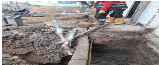
Demolición de sardinel CIV 8009456 (NC11).
