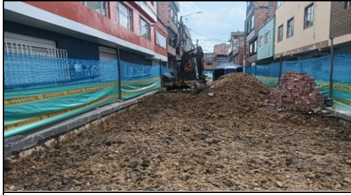
Demolición de carpeta asfáltica y cargue de material RCD 8009473 (NC12).
