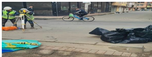
Replanteo para cambio red sanitaria CIV 8009327 (NC3).
