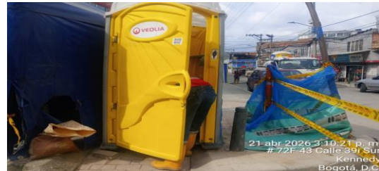
Mantenimiento de unidad sanitaria CIV 8010914-8010695 (N26-N27)
