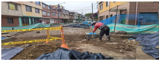
Excavación para red de agua potable CIV 8010914 (NC26).
