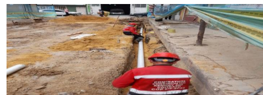
Colocación de arena e instalación de tubería 4" para red de agua potable CIV 8009456 (NC11).
