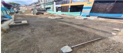
Instalación de geomalla, humectación y compactación de ARBG-38 estabilizado CIV 8010914 (NC26).
