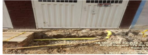
Adecuación de bajantes CIV 8009456 (NC11).
