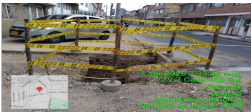
Señalización perimetral CIV 8009556-8009549(N6-N28)
