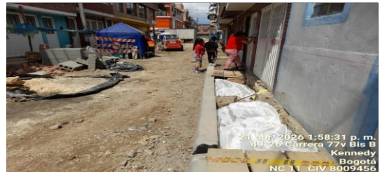
Instalación de geotextil en andén CIV 8009456 (NC11).
