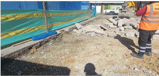
Demolición de concreto en vía CIV 8006810 (NC8).
