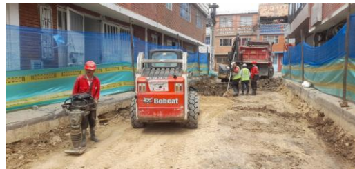
Compactación con canguro sobre tubería de 8" sanitaria con material B200 CIV 8009473 (NC12).
