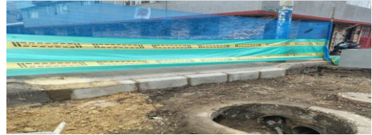
Instalación de sardinel bajo rampa CIV 8010826 (NC29).
