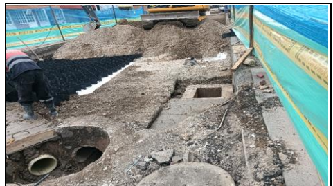
Instalación de sumidero CIV 8010826 (NC29).
