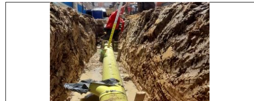
Instalación de Kit Silla Yee CIV 8009473 (NC12).
