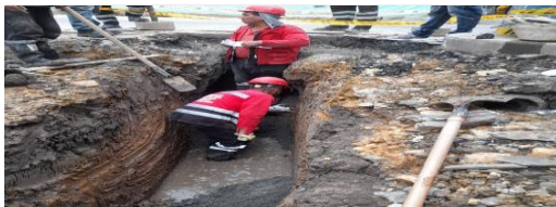
Excavación manual para conectar a pozo existente de agua sanitaria CIV 8009473 (NC12).
