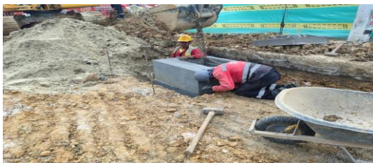
Instalación de sumidero CIV 8007698 (NC24).
