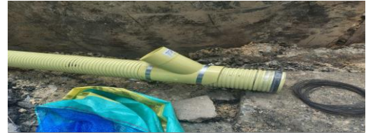
Instalación de Kit Silla Yee CIV 8007698 (NC24).
