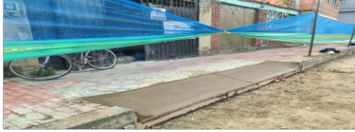
Instalación de concreto MR 41, estampado, curado y demarcación en rampas de acceso vehicular CIV 8010826 (NC29).
