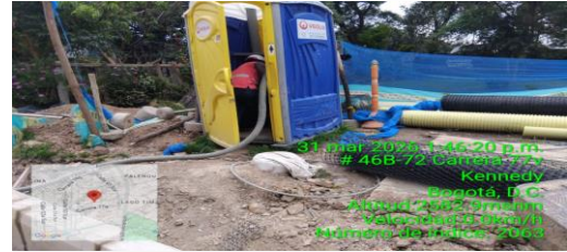
Mantenimiento de unidad sanitaria CIV 8009556-8009549(N6-N28)
