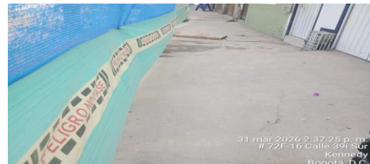
Adecuación Sendero Peatonal
