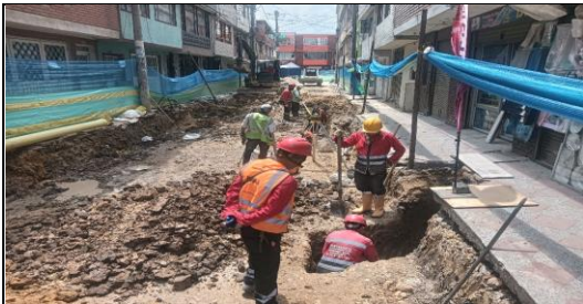
Excavación para tubería sanitaria CIV 8009327 (NC3).
