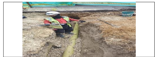
Instalación de domiciliarias CIV 8007698 (NC24).
