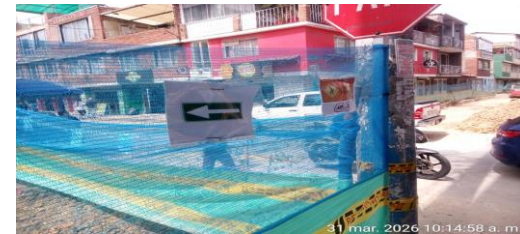
Instalación Señalización SST
