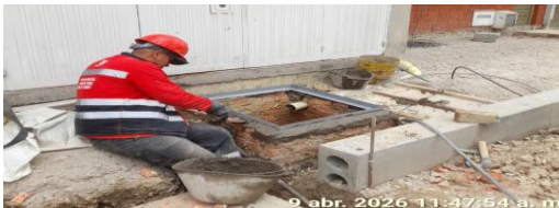
Instalación de marcos en cajas de inspección CIV 8009556 (NC6).
