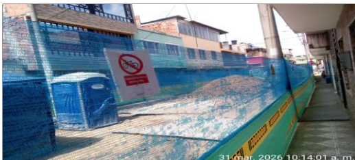
Instalación Señalización SST
