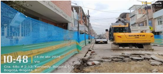
Instalación de cerramiento perimetral CIV 8006810 (N8)
