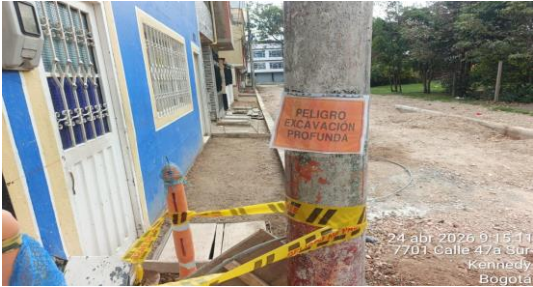
Instalación Señalización SST CIV 8009556
