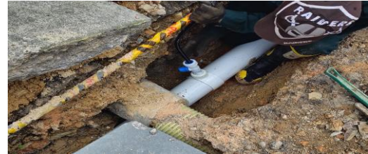
Instalación de tubería de 4" CIV 8010914 (NC26).
