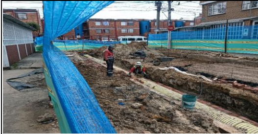
Construcción de cárcamo CIV 8007698 (NC24).
