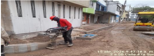
Compactación de bordes en vía CIV 8009556 (NC6).
