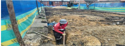
Apique para identificación de la red del gas CIV 8009473 (NC12).
