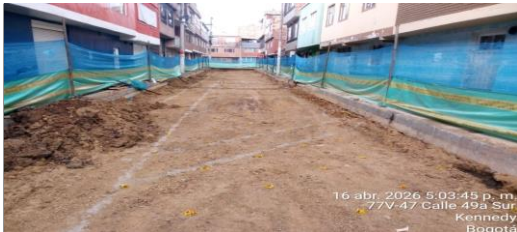
Mantenimiento de cerramiento perimetral CIV 8009473 (N12)
