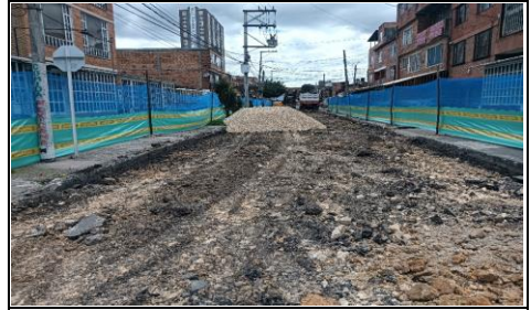
Demolicion de carpeta asfaltica existente CIV 8007698 (N24)
