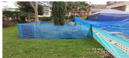
Mantenimiento de protección arborea CIV 8009556-8009549-8009623(N6-N28-N36)
