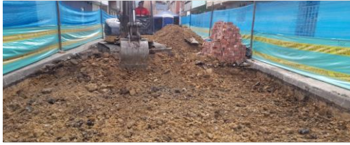
Excavación de subrasante 8009473 (NC12).
