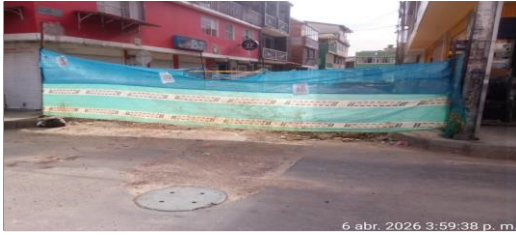
Mantenimiento de cerramiento perimetral CIV 8009456 (N11)
