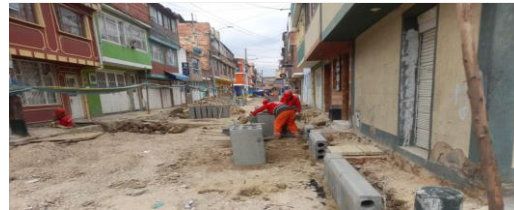
Excavación e instalación de prefabricados CIV 8009456 (NC11).
