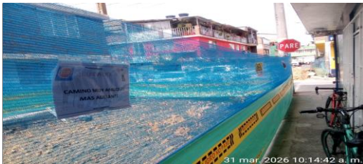
Instalación Señalización SST
