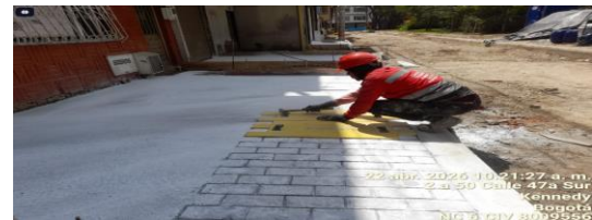
Fundida de concreto y estampado en andenes CIV 8009556 (NC6).
