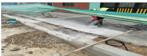
Corte para ajustar la rampa de acceso vehicular, atraque y nivelación de cinta de ajuste de andenes CIV 8010914 (NC26).
