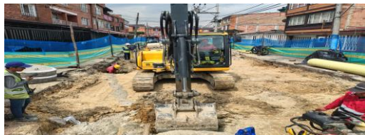
Excavación para la red pluvial de 20" CIV 8007698 (NC24).
