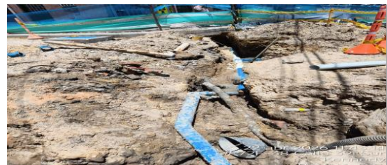
Instalación de accesorios para la red de acueducto CIV 8010914 (NC26).
