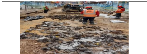
Marcación de barrenos en vía e inyección de cal CIV 8009456 (NC11).
