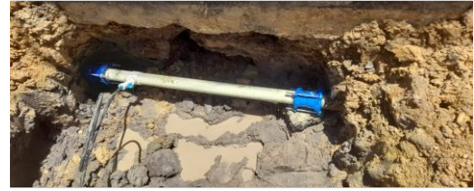
Reparación fuga de red de agua potable 8009473 (NC12).
