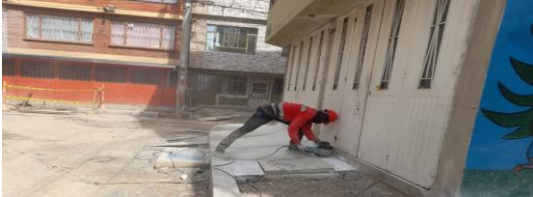
Cortes para dilataciones de concreto CIV 8009556 (NC6).
