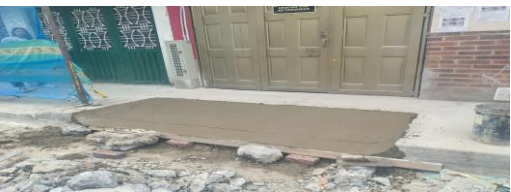
Instalación de concreto MR 41, estampado, curado y demarcación en rampas CIV 8010695 (NC27).
