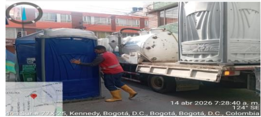
Instalación unidad sanitaria CIV 8009327 (N3)
