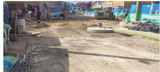
Céreo, compactación y nivelación de material AR-BG38 estabilizado CIV 8010695 (NC27).
