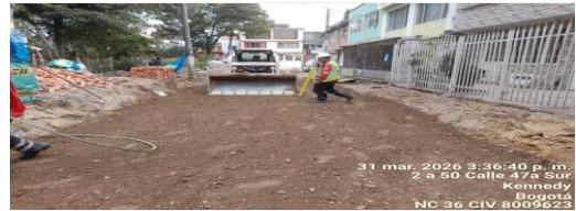
Céreo, compactación y nivelación de material AR-SBG50 estabilizado CIV 8009623 (NC36).
