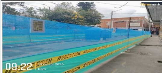
cerramiento vertical en el siguiente CIV:8006953-8006810
