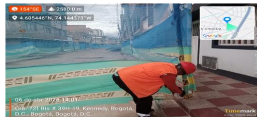
Mantenimiento de cerramiento perimetral CIV 8010914-8010695(N26-N27)
