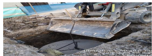
Instalación de placa fondo pozo en pozo pluvial CIV 8010914 (NC26).
