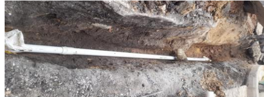
Instalación de tubería 4" para red de agua potable en cruce CIV 8009456 (NC11).
