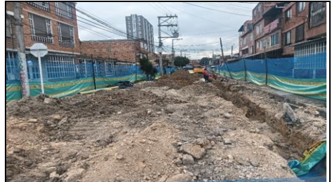
Instalación de accesorios para conexión domiciliaria CIV 8007698 (NC24).
