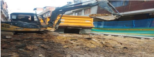
Excavación mecánica en vía y transporte de RCD CIV 8009327 (NC3).
