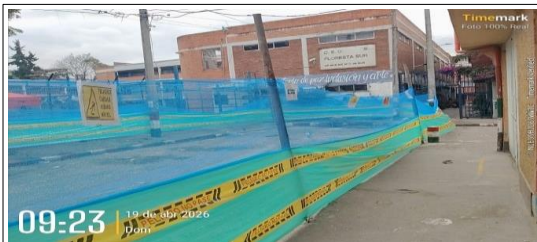
Señalización de sst en el siguiente CIV: 8006953-8006810
