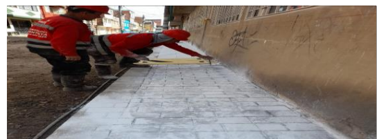
Fundida de concreto y estampado en andenes CIV 8009549 (NC28).
