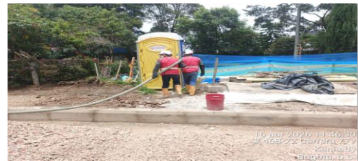
Mantenimiento unidad sanitaria CIV 8009556-8009549(N6-N28)
