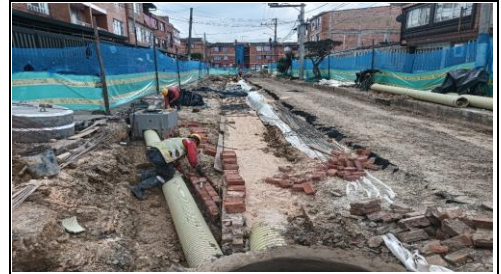
Construcción de parrilla e instalación de concreto para cárcamo CIV 8007698 (NC24).
