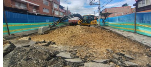
Demolición, excavación mecánica, carga de volqueta, retiro y transporte de RCD de vía CIV 8009473 (NC12).
