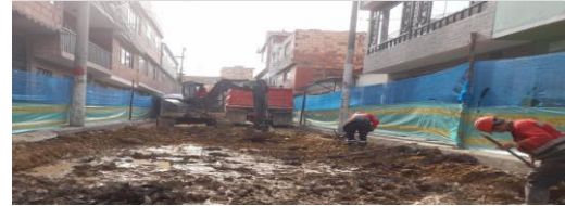
Excavación de subrasante CIV 8009473 (NC12).
