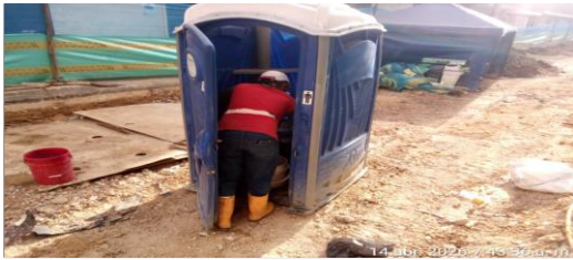
Mantenimiento unidad sanitaria CIV 8009456 (N11)
