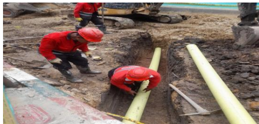
Excavación e instalación de domiciliarias CIV 8009473 (NC12).
