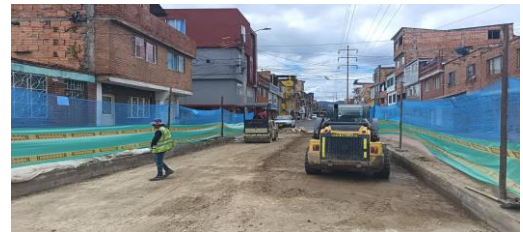
Compactación y nivelación de ARBG-38 estabilizado con Cemento y aditivo CIV 8010826 (NC29).
