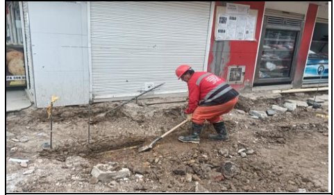
Demolicion de concreto existente en andenes CIV 8009456 (NC11).
