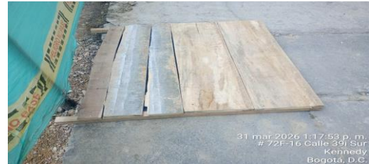
Plafonamiento y Adecuación Senderos peatonales
