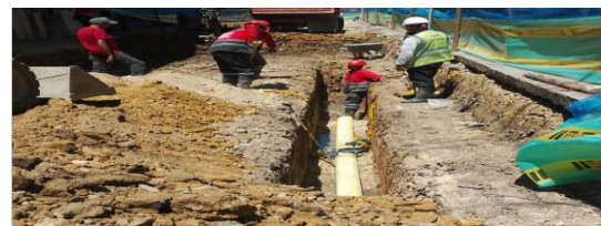
Instalación tubería sanitaria CIV 8009327 (NC3).
