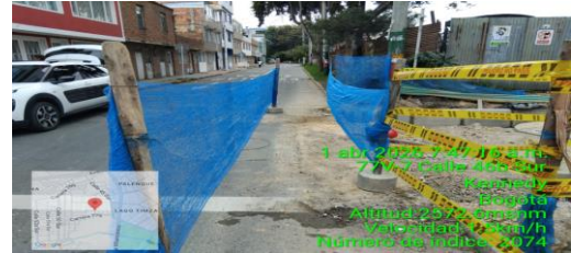
Mantenimiento de sendero peatonal CIV 8009556-8009549(N6-N28)
