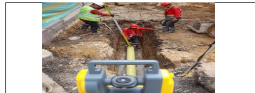
Instalación de tubería sanitaria Novafort de 8" CIV 8009473 (NC12).
