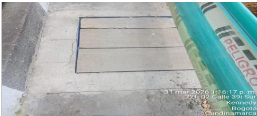
Plafonamiento y Adecuación Senderos peatonales
