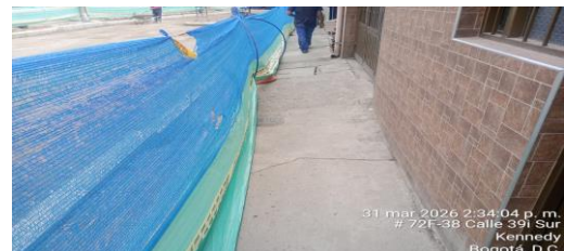
Adecuación Sendero Peatonal
