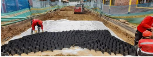
Instalación de geotextil, Geocelda y material tipo AR-SBG50 CIV 8009456 (NC11).
