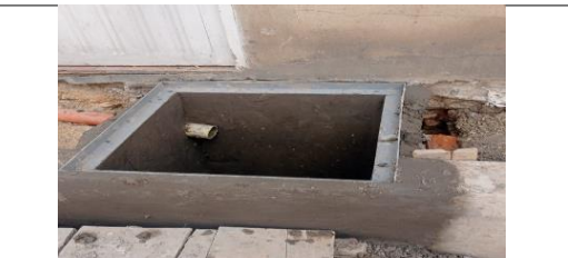
Instalación de marcos en cajas de inspección CIV 8009549 (NC28).
