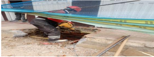
Demolición de cajas de inspección existentes CIV 8009456 (NC11).
