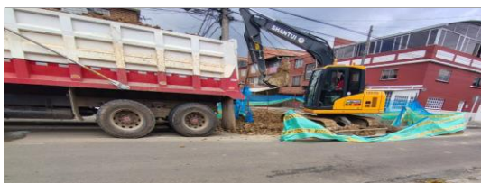
Cargue de material de excavación CIV 8007698 (NC24).
