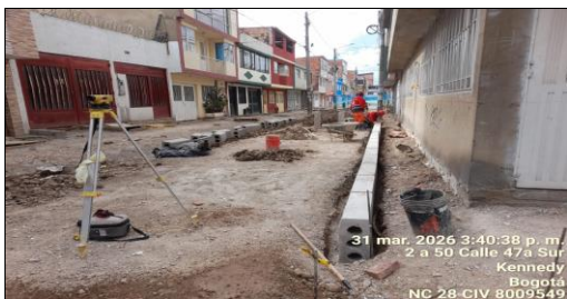
Instalación de prefabricados CIV 8009549 (NC28).
