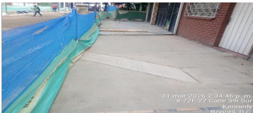
Adecuación Sendero Peatonal
