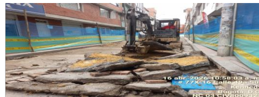
Demolición de placa en concreto CIV 8009327 (NC3).
