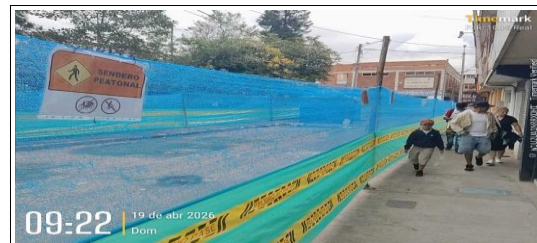
Adecuación cerramiento vertical en el siguiente CIV:8006953-8006810
