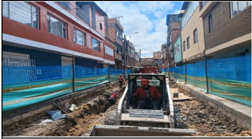
Instalación de tubería sanitaria Novafort de 8" CIV 8009473 (NC12).
