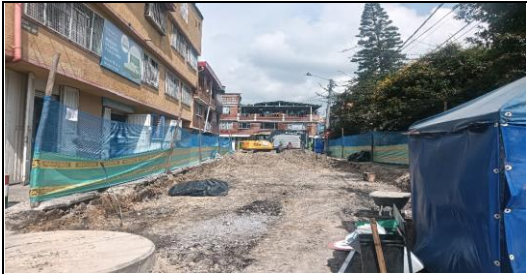
Demolición de concreto en vía CIV 8006810 (NC8).
