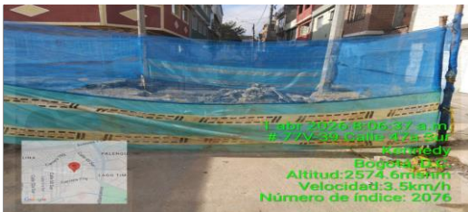
Mantenimiento de cerramiento perimetral CIV 8009556-8009549(N6-N28)
