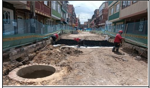
Instalación de geotextil, Geocelda y material tipo AR-SBG50 CIV 8009456 (NC11).
