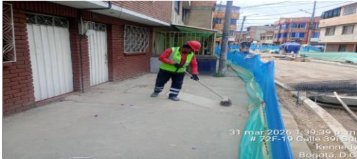
Mantenimiento de sendero peatonal CIV 8010914-8010695(N26-N27)
