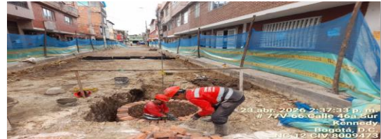
Construcción de pozo inicial sanitario CIV 8009473 (NC12).
