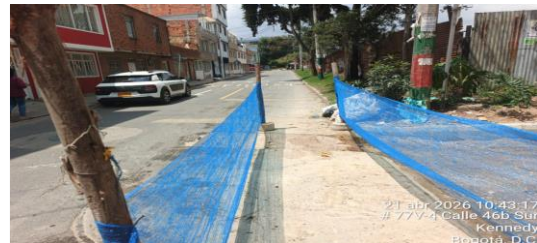
Mantenimiento de sendero peatonal CIV 8009556-8009549-8009623(N6-N28-N36)
