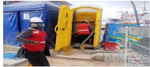
Mantenimiento unidad sanitaria CIV 8010914-8010695(N26-N27)
