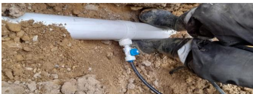
Instalación de collarines CIV 8009456 (NC11).
