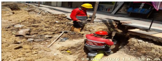
Excavación e instalación de tubería para domiciliaria CIV 8009327 (NC3).
