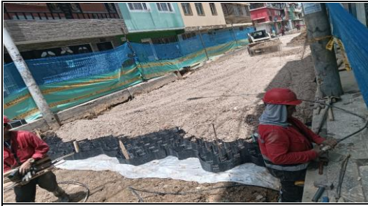
Instalación de geotextil, geo celda y subbase reciclada AR-SBG50 CIV 8009473 (NC12).
