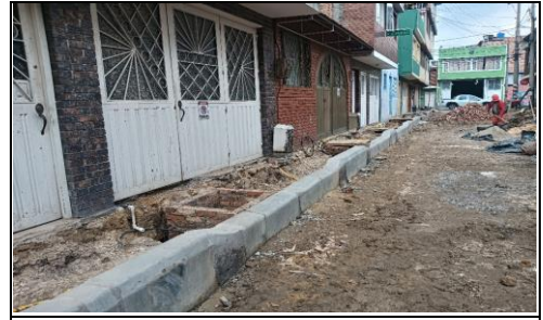
Construcción de cajas de inspección CIV 8009456 (NC11).
