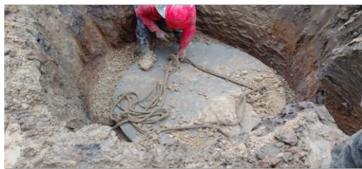
Instalación placa fondo pozo pluvial CIV 8009473 (NC12).
