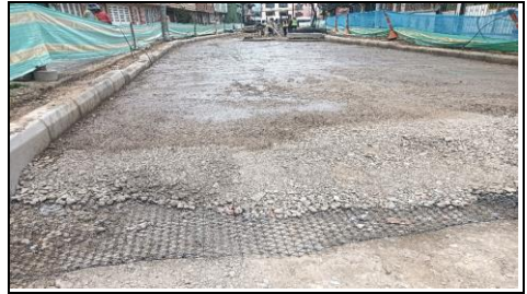
Compactación y nivelación de material AR-BG38 estabilizado CIV 8010914 (NC26).
