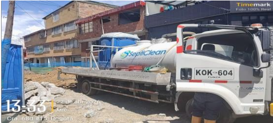
Mantenimiento de unidad sanitaria CIV 8006953 (N7)
