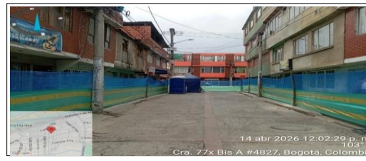
cerramiento vertical en el siguiente CIV: 8007698
