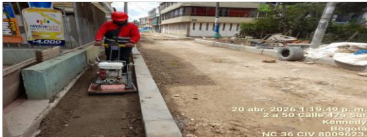
Céreo anden con material estabilizado CIV 8009623 (NC36).
