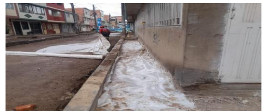
Instalación de geotextil e instalación de material estabilizado en espacio público CIV 8009549 (NC28).
