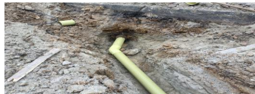
Instalación de accesorios para conexión domiciliaria CIV 8007698 (NC24).
