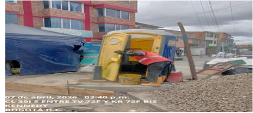
Mantenimiento de unidad sanitaria CIV 8010914-8010695(N26-N27)
