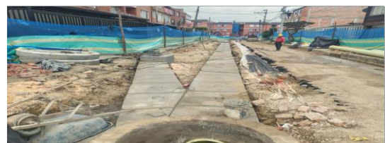
Construcción de parrilla e instalación de concreto para cárcamo CIV 8007698 (NC24).
