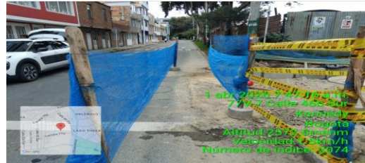
Adecuación Sendero Peatonal
