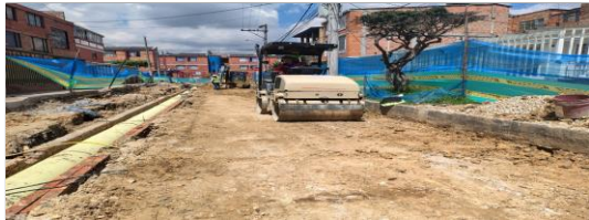
Compactación de subrasante CIV 8007698 (NC24).
