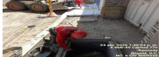
Construcción de cañuelas en cajas de inspección CIV 8009556 (NC6).
