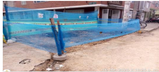
Mantenimiento de cerramiento perimetral CIV 8009456 (N11)
