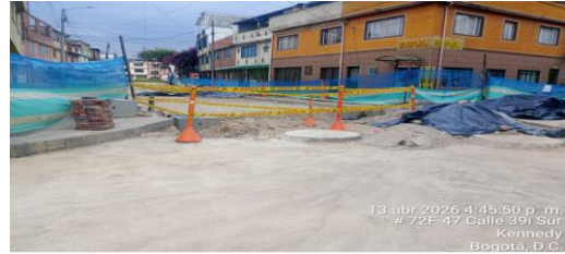
Mantenimiento de cerramiento perimetral CIV 8010914-8010695(N26-N27)
