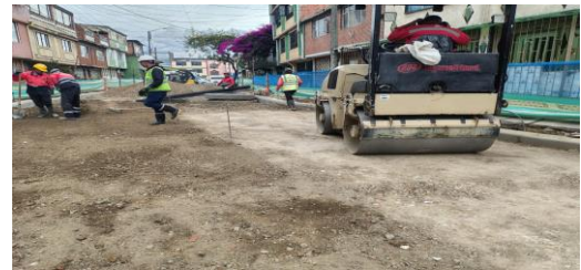
Céreo, compactación y nivelación de material AR-BG38 estabilizado CIV 8010914 (NC26).
