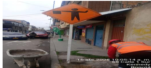
Instalación de PMT CIV 8006953-8006810 (N7-N8)
