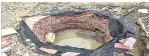
Construcción de pozo pluvial y excavación manual para tubería de 12" CIV 8010914 (NC26).
