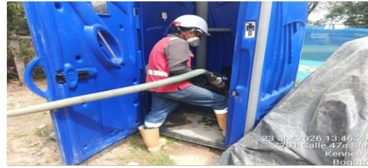
Mantenimiento de unidad sanitaria CIV 8009556-8009549-8009623(N6-N28-N36)
