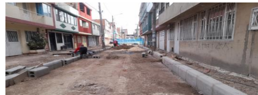
Instalación y alineación de prefabricados CIV 8009549 (NC28).
