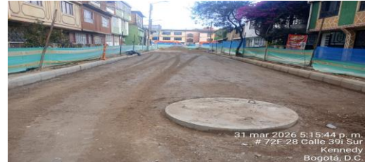
Jornada Orden, Aseo, Limpieza y Adecuación Cerramiento
