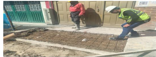
Instalación de malla electrosoldada en rampa CIV 8010695 (NC27).
