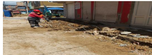
Demolición manual de espacio público 8009456 (NC11).
