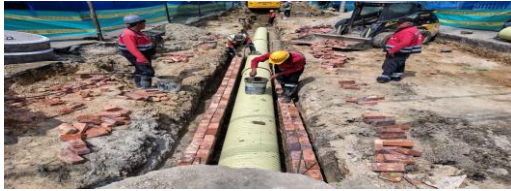
Instalación de tubería y construcción de cárcamo red pluvial 20" CIV 8007698 (NC24).
