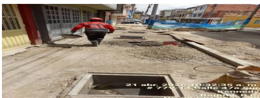
Construcción de cañuelas CIV 8009549 (NC28).
