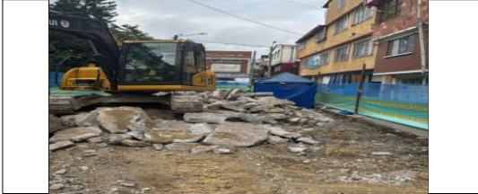
Demolición de concreto en vía CIV 8006953 (NC7).
