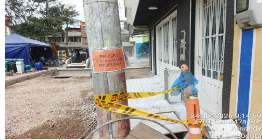
Instalación Señalización SST CIV 8009556
