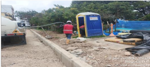
Mantenimiento de unidad sanitaria CIV 8009556-8009549(N6-N28)
