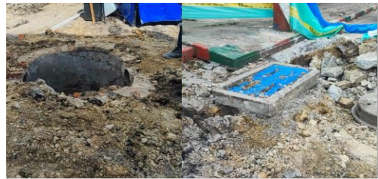
Demolición de pozos y sumideros CIV 8006810 (NC8).
