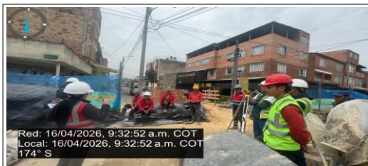
Capacitación de prevención de accidentes e incidentes en obra en siguiente CIV: 8007698
