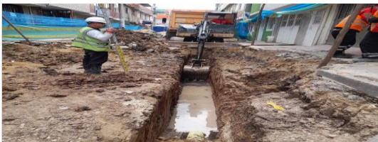
Excavación para tubería sanitaria CIV 8009327 (NC3).
