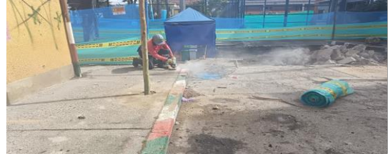
Cortes con pulidora en concreto existente CIV 8006953 (NC7).
