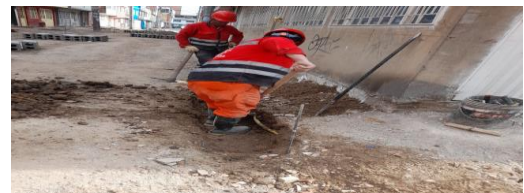
Excavación para instalación de prefabricados CIV 8009549 (NC28).
