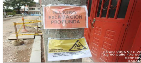
Instalación Señalización SST CIV 8009556
