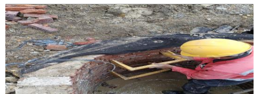
Instalación de pasos y pañete de pozo pluvial CIV 8010914 (NC26).
