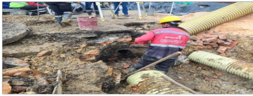
Demolición para la renovación de pozos CIV 8007698 (NC24).
