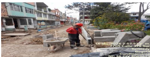
Excavación e instalación de prefabricados CIV 8009623 (NC36).
