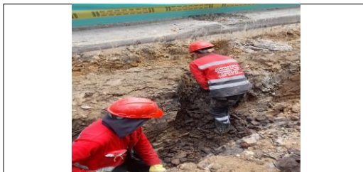
Excavación manual para domiciliares CIV 8009473 (NC12).
