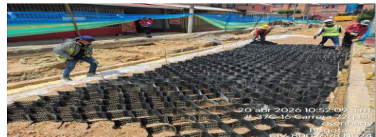
Instalación de geotextil, geo celda y subbase reciclada AR-SBG50 CIV 8007698 (NC24).
