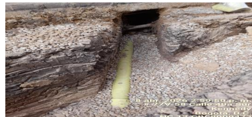
Instalación de domiciliares CIV 8009473 (NC12).
