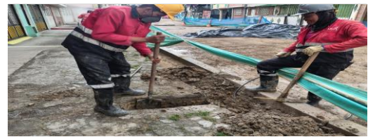
Cortes y excavación para conexiones de acometidas de acueducto CIV 8010914 (NC26).
