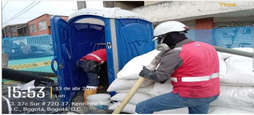
Mantenimiento unidad sanitaria CIV 8007698 (N24)
