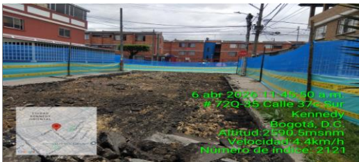
Instalación de cerramiento CIV 8007698 (N24)
