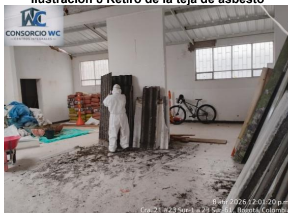
Ilustración 8 Retiro de la teja de asbesto
