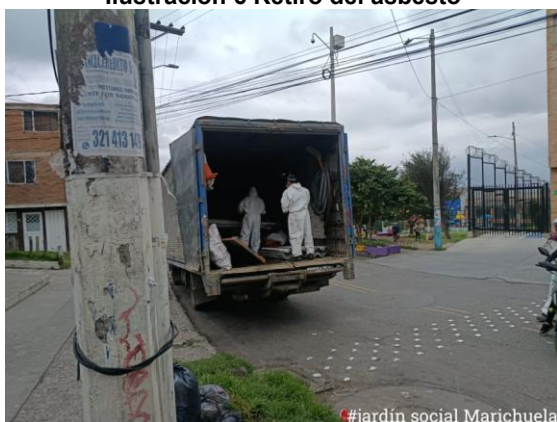
Ilustración 8 Retiro de la teja de asbesto
