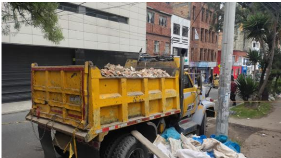
Ilustración 4 Retiro de RCD
