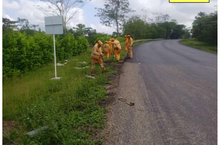
COLOCACIÓN DE DEFENSAS METÁLICAS PR31+0100 L.I
