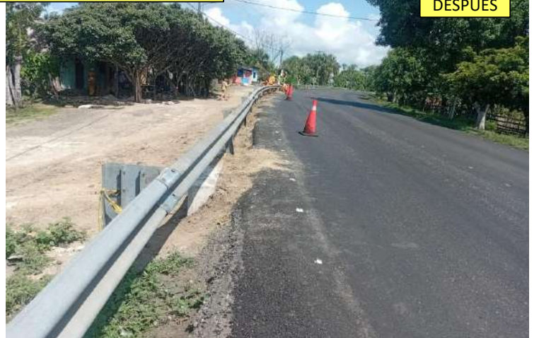
COLOCACIÓN DE DEFENSAS METÁLICAS PR31+0100 L.I
