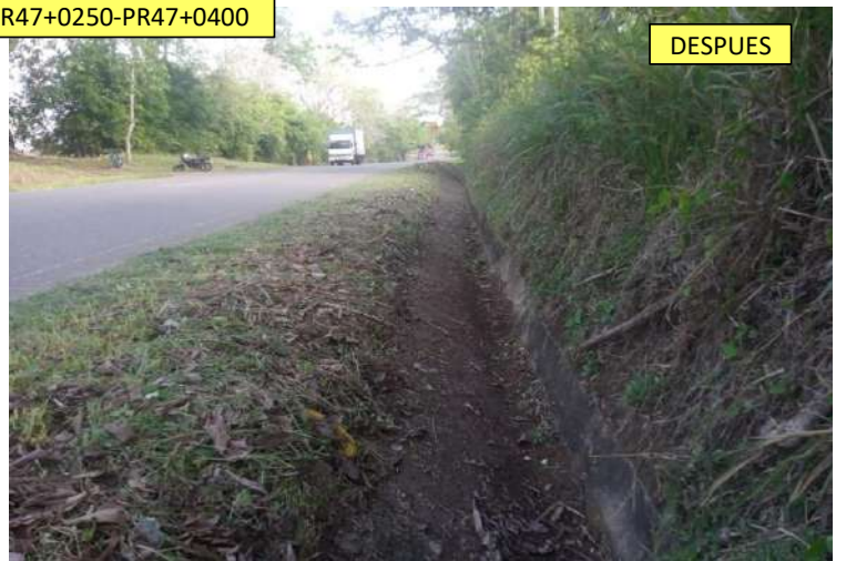
LIMPIEZA DE CUNETAS PR47+0250-PR47+0400
