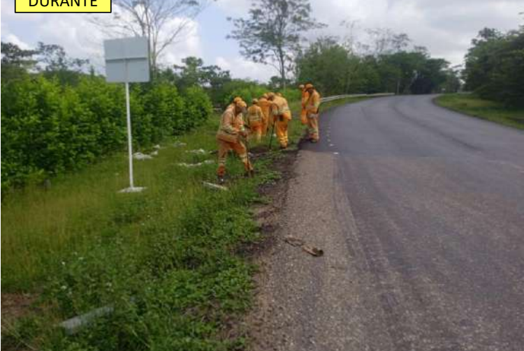
COLOCACIÓN DE DEFENSAS METÁLICAS PR31+0100 L.I
