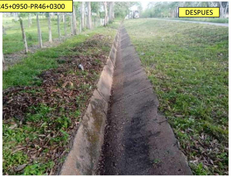
ROCEÍA Y DESMONTE MANUAL PR47+0500-PR49+0000
