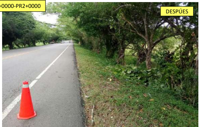
LIMPIEZA DE CUNETAS PR2+0000-PR2+0780
