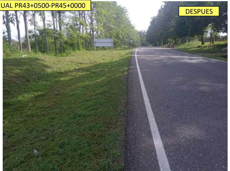
LIMPIEZA DE CUNETAS PR43+0500-PR44+0000
