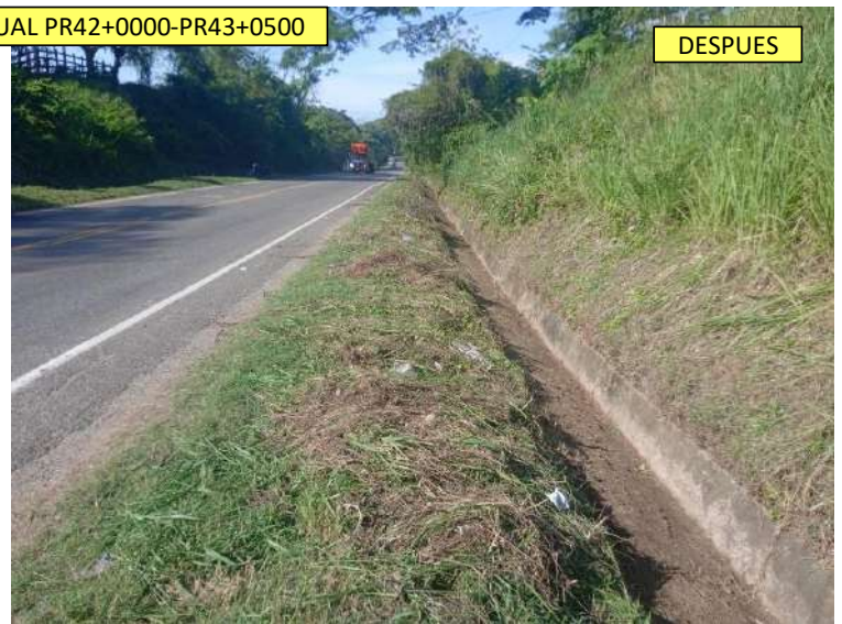
LIMPIEZA DE CUNETAS PR42+0750-PR42+0900
