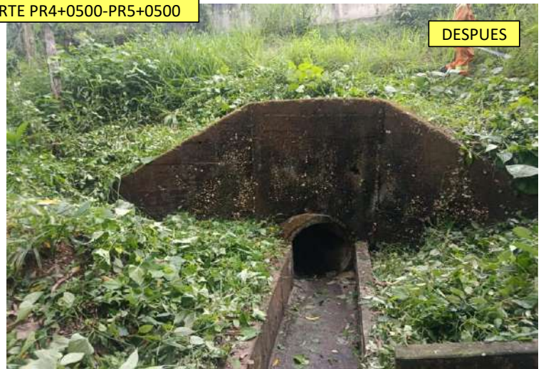
LIMPIEZA DE CUNETAS PR4+0500-PR5+0500
