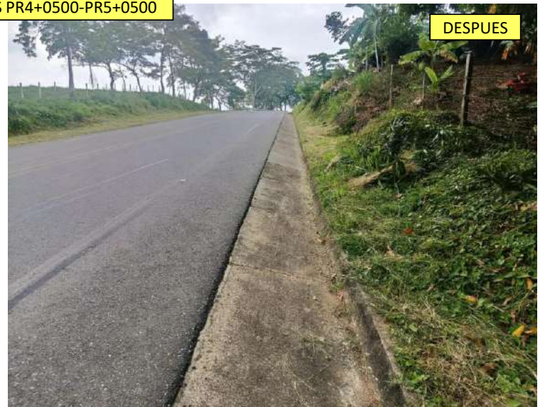
LIMPIEZA DE CUNETAS PR4+0500-PR5+0500
