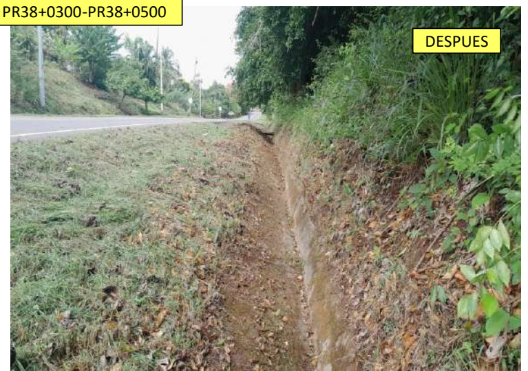
LIMPIEZA DE CUNETAS PR38+0300-PR38+0500
