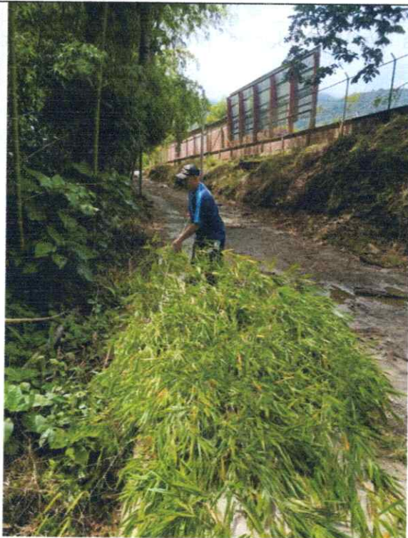
Imagen 43. Apoyo mejoramiento de vías
