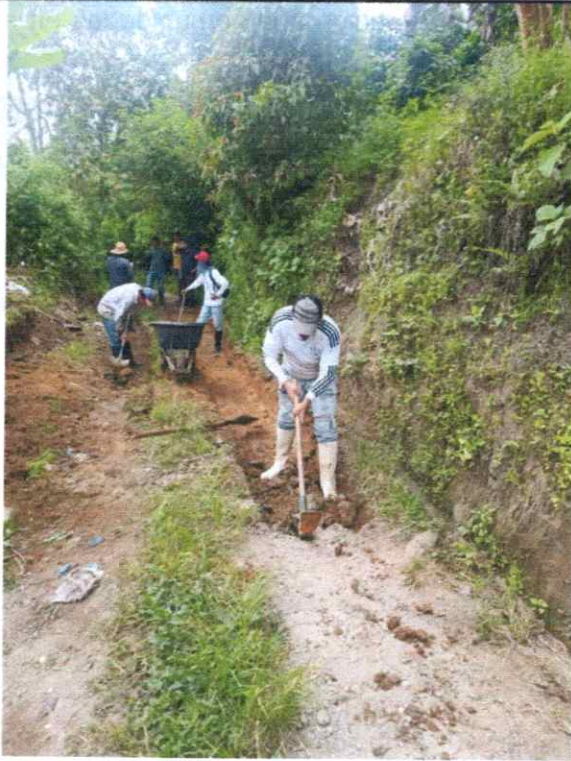
Imagen 41. Apoyo mejoramiento de vías
