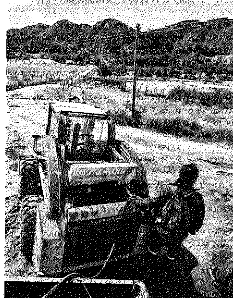
Imagen 6. Suministro de combustible
