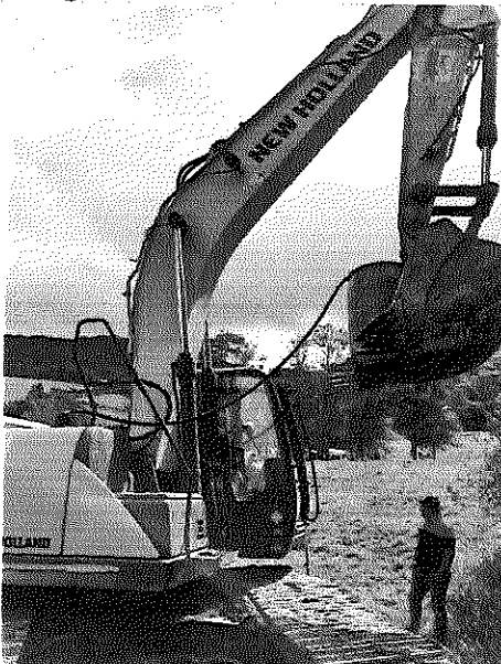
Imagen 5. Suministro de combustible
