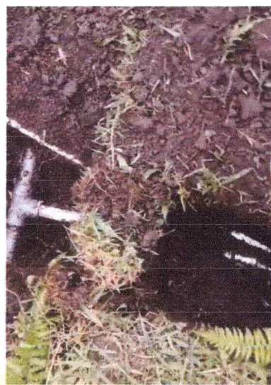
Mantenimiento y reparación de tubería, Acueducto 2 la florida.
