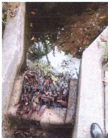
Limpieza de bocatoma Acueducto 1 el Palmar
