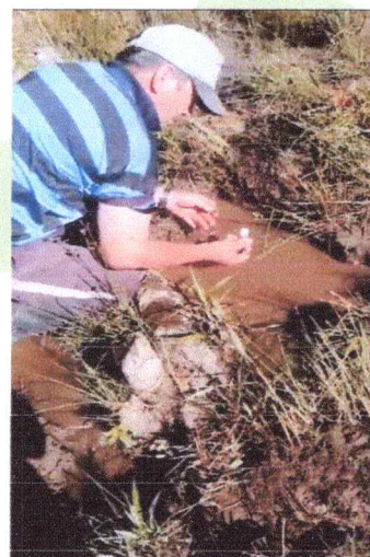
Mantenimiento y reparación de tubería, Acueducto 3 la florida.
