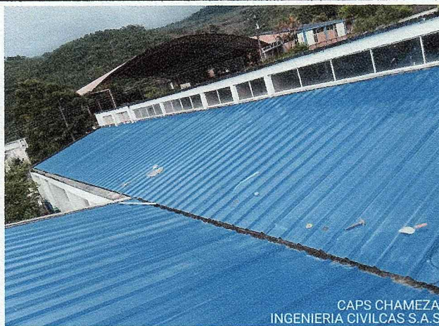
instalacion de cubierta
