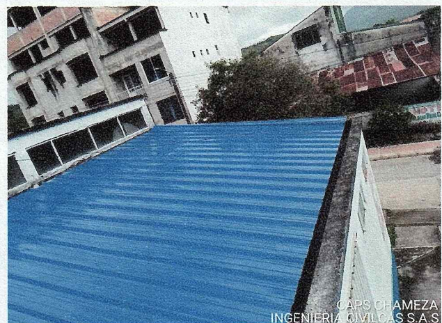
instalacion de cubierta
