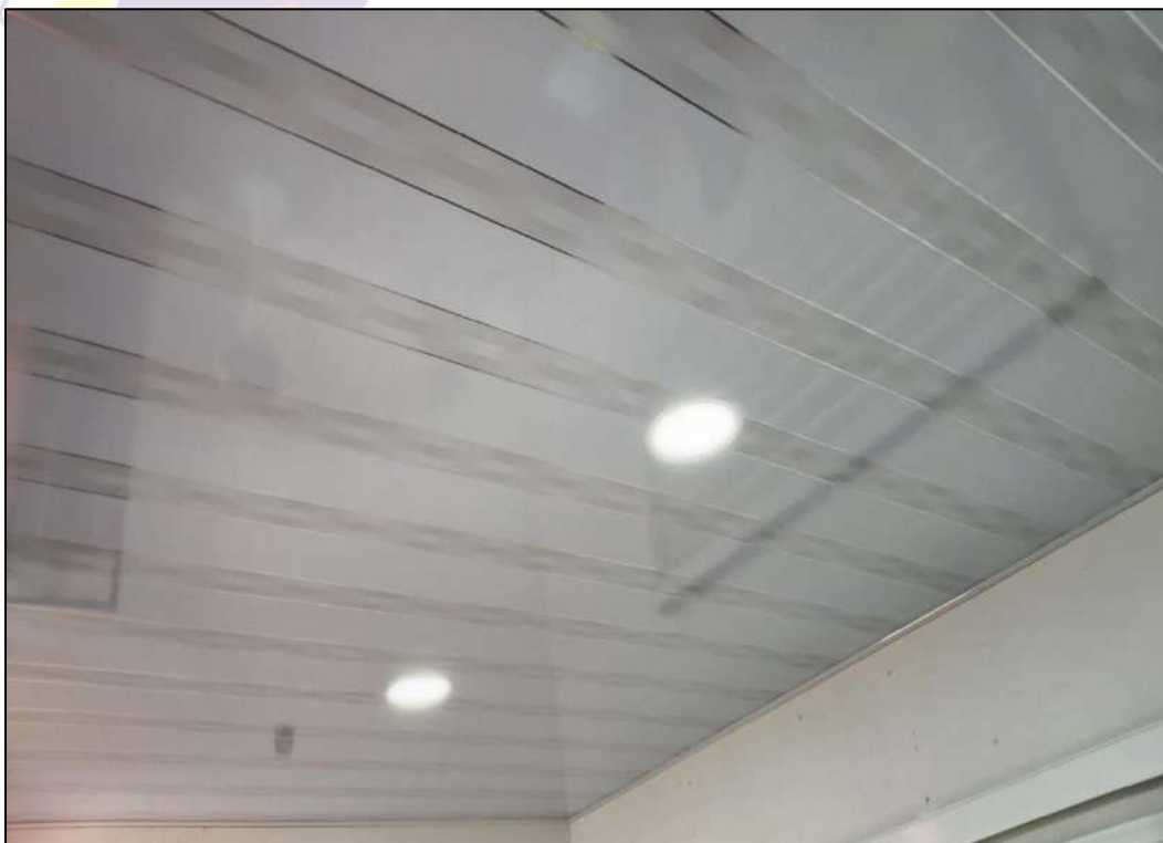
Imagen 85. Instalación de cielo raso para la oficina de dirección.
