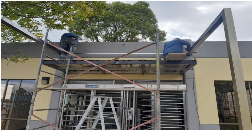
INSTALACION DE ESTRUCTURA PERGOLA ACCESO PEATONAL
