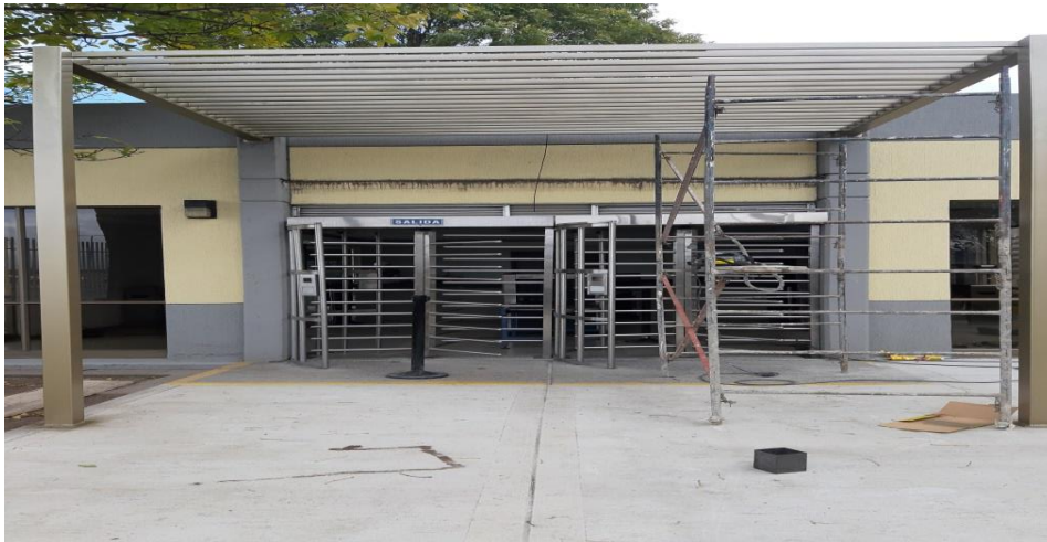
INSTALACION DE ESTRUCTURA PERGOLA ACCESO PEATONAL
