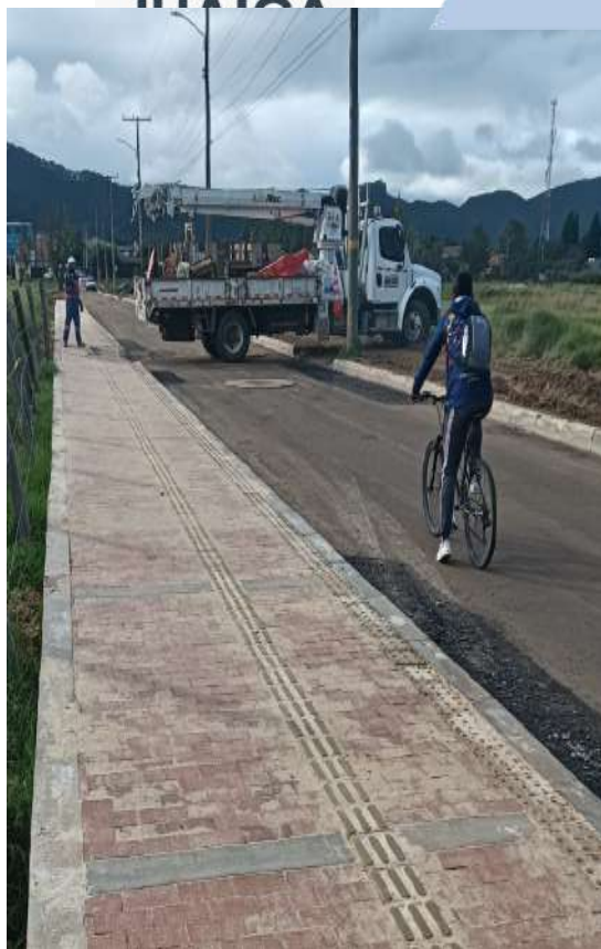
K+ 240 COSTADO NORTE Y SUR
