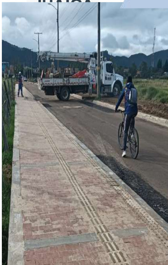
K+ 240 COSTADO NORTE Y SUR
