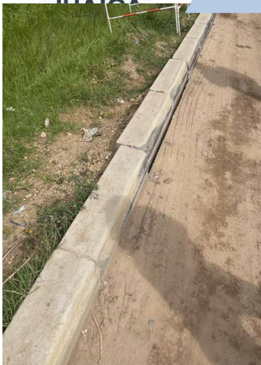
K+380 COSTADO NORTE
