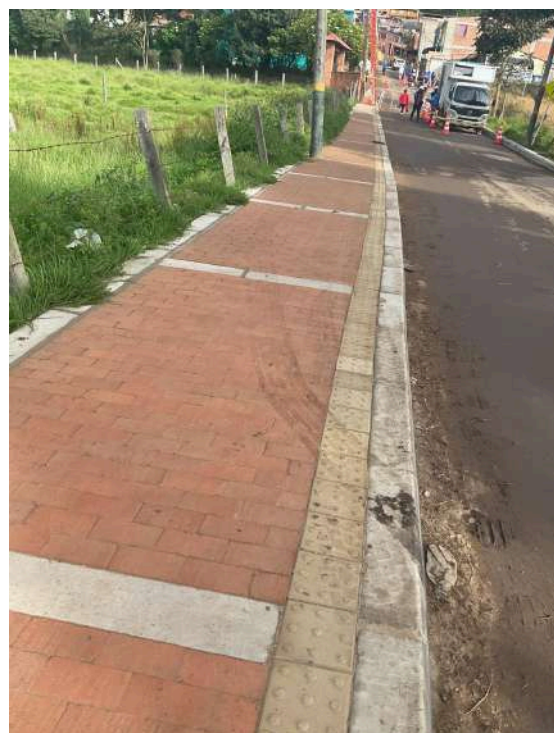
K+470 COSTADO SUR
