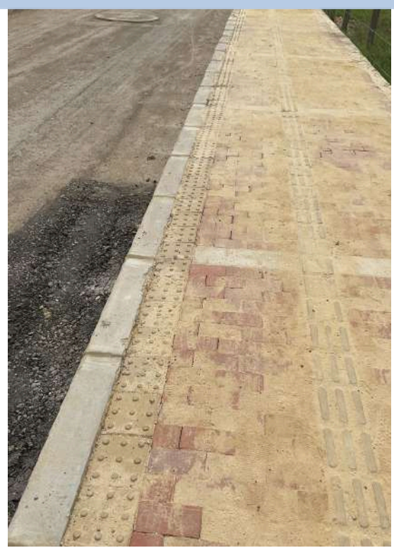
k+270 COSTADO NORTE
