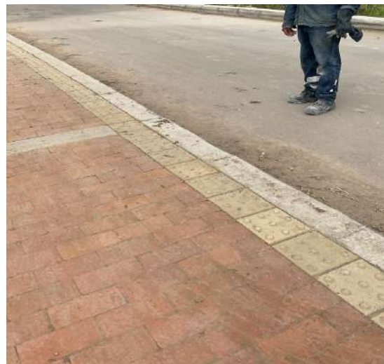
K+240 DESPRENDIMIENTO DE SARDINELES, DESPORTILLADOS, MANCHADOS, FISURADOS
