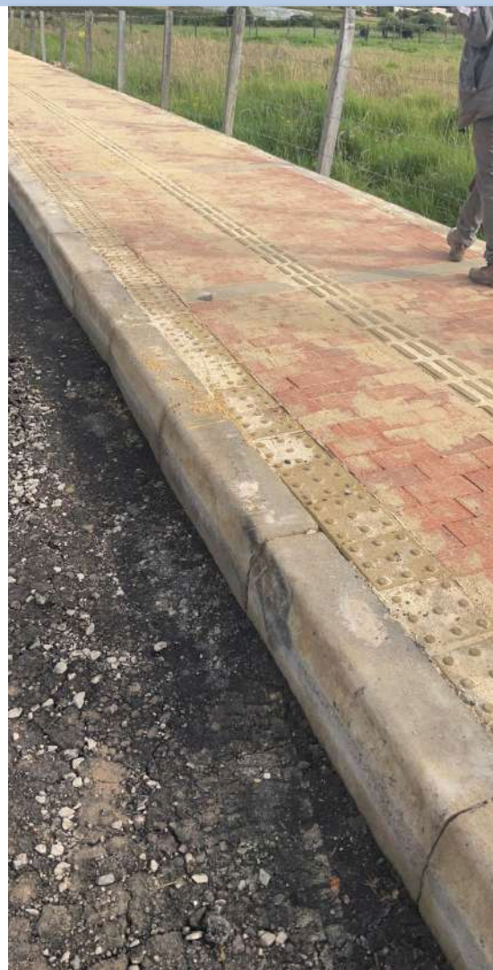
K+ 250 COSTADO NORTE
