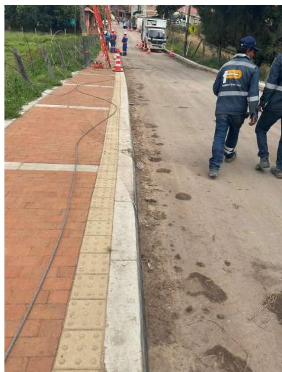
K+ 470 COSTADO SUR
