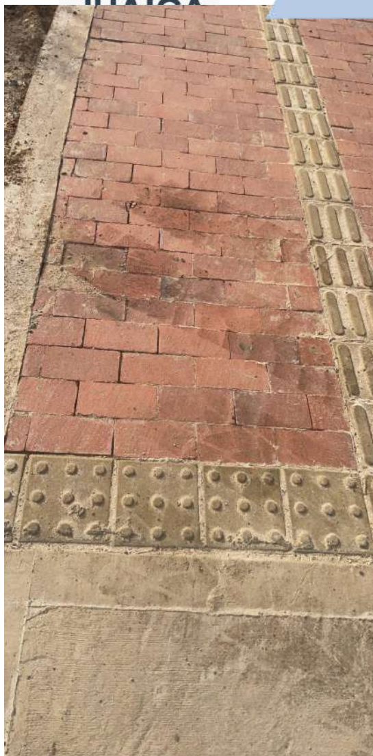
K+230 COSTADO NORTE
