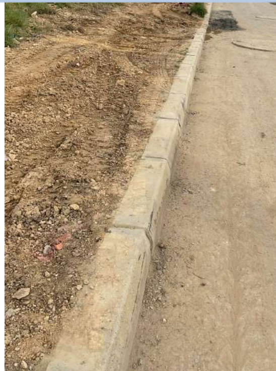
K+240 DESPRENDIMIENTO DE SARDINELES, DESPORTILLADOS, MANCHADOS, FISURADOS
