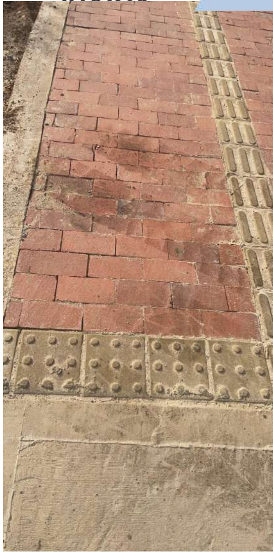
K+230 COSTADO NORTE
