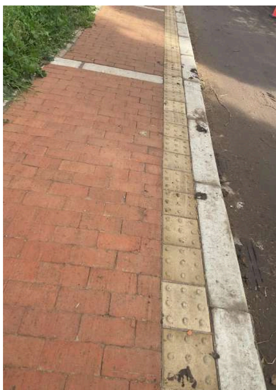
K+ 480 COSTADO SUR
