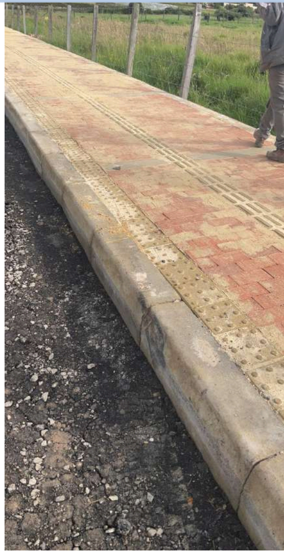
K+ 250 COSTADO NORTE
