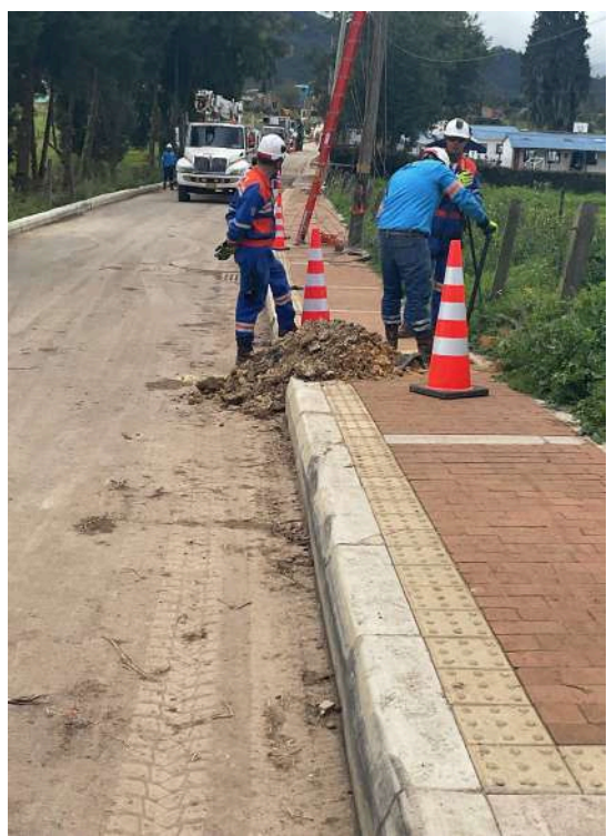
K+470 COSTADO SUR
