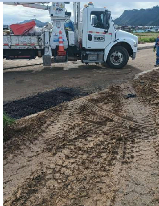
K+ 240 COSTADO NORTE
