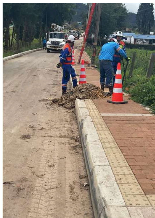
K+470 COSTADO SUR
