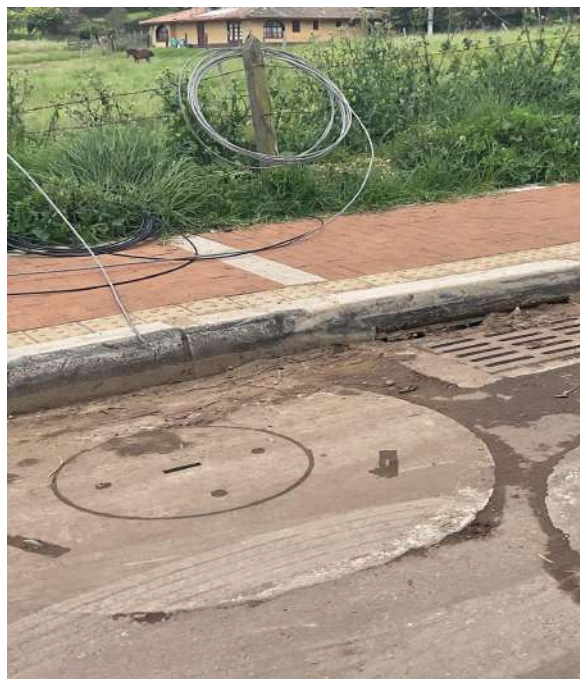
K+490 COSTADO SUR
