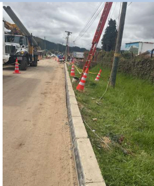
K+380 COSTADO SUR
