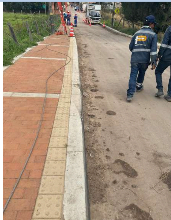
K+ 470 COSTADO SUR
