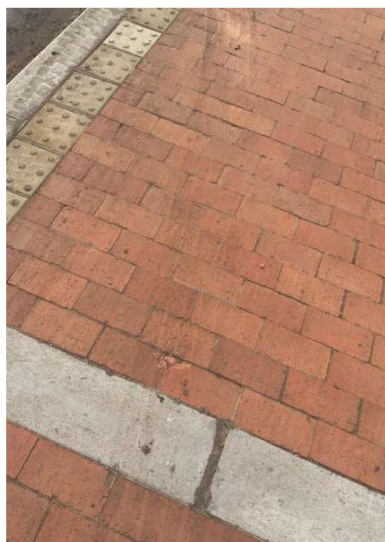
K+480 COSTADO SUR
