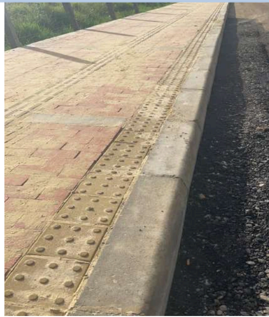
K+280 COSTADO NORTE
