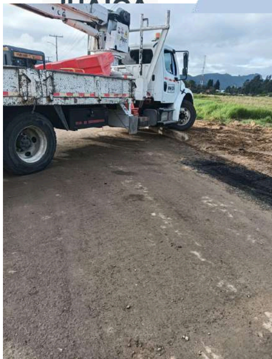
K+ 240 COSTADO SUR
