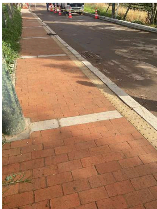
K+ 470 COSTADO SUR
