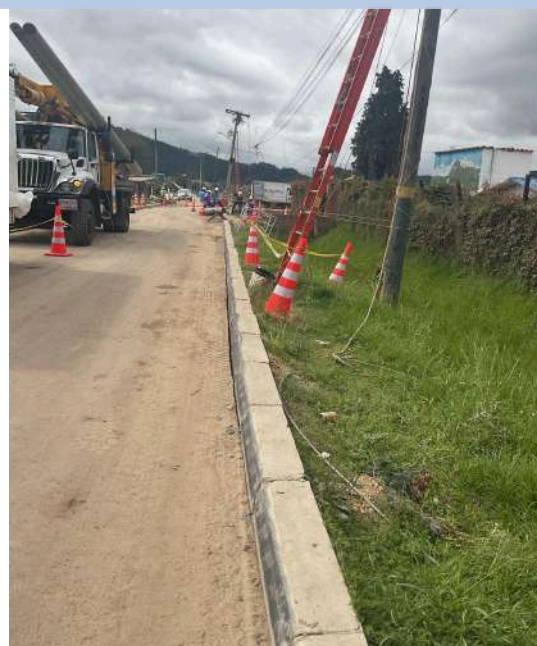
K+380 COSTADO SUR
