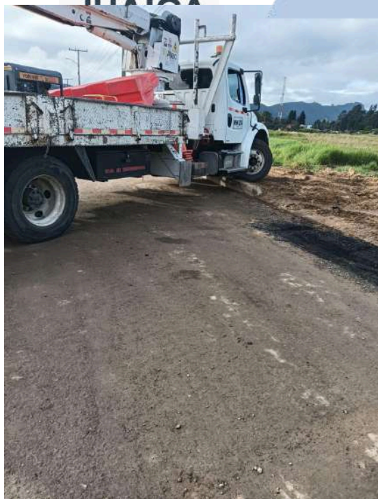
K+ 240 COSTADO SUR
