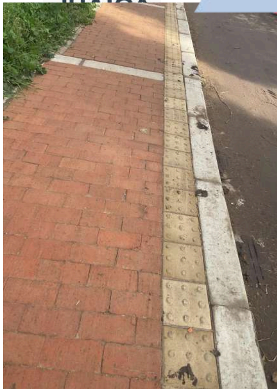
K+ 480 COSTADO SUR
