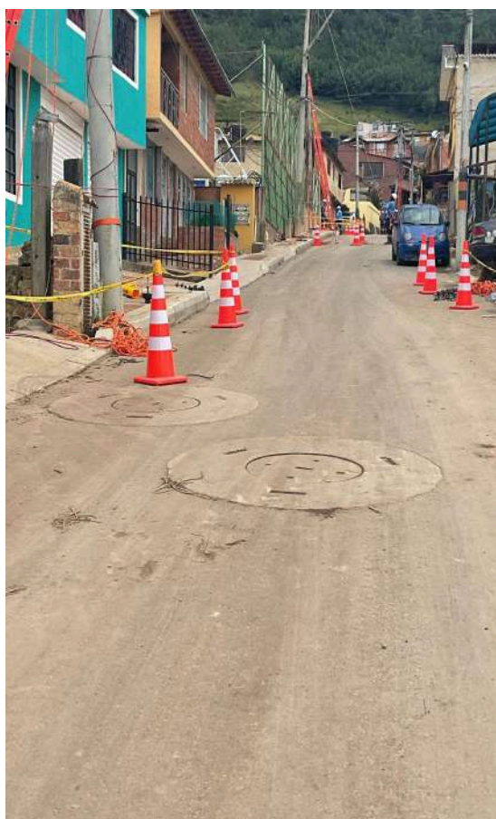
K+500 COSTADO SUR
