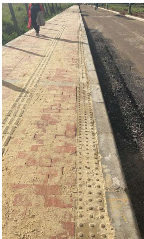
K' +280 COSTADO NORTE
