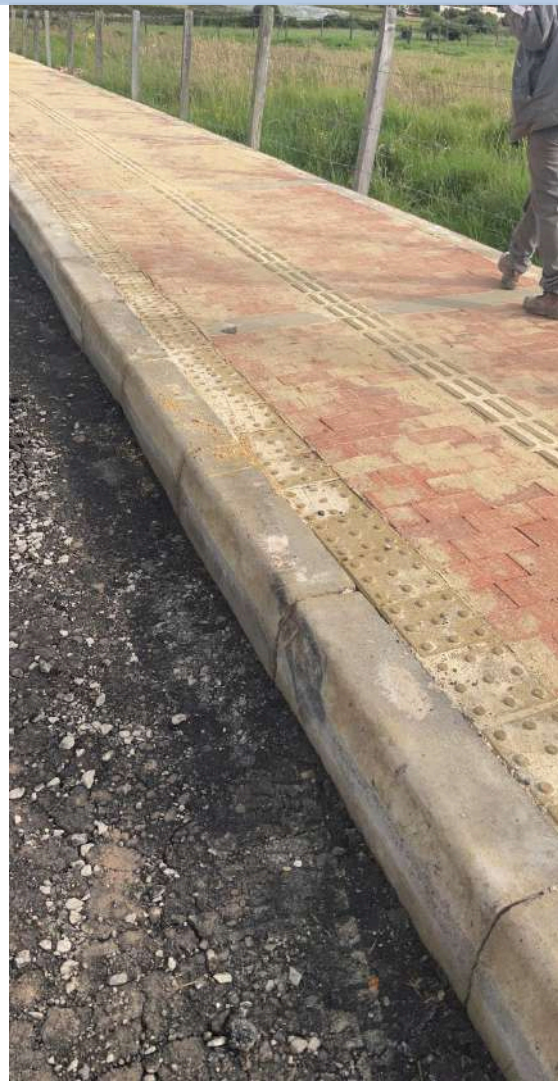
K+ 250 COSTADO NORTE
