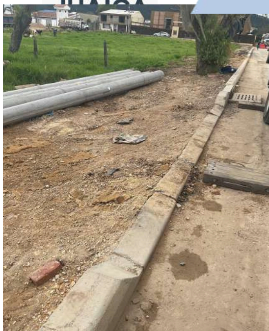
K+80 COSTADO NORTE
