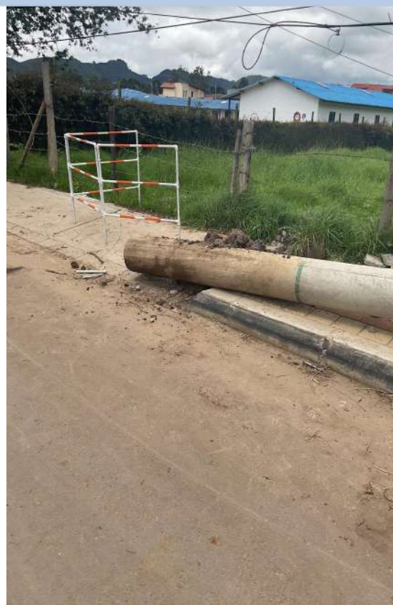
K+420 COSTADO NORTE
