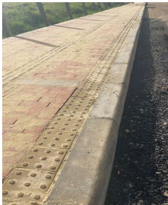
K+280 COSTADO NORTE
