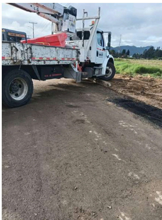
K+ 240 COSTADO SUR
