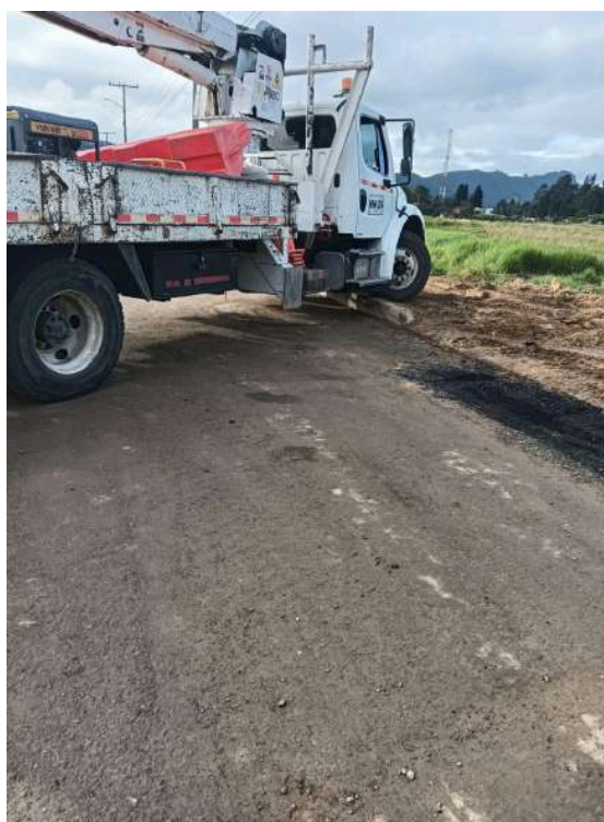
K+ 240 COSTADO SUR
