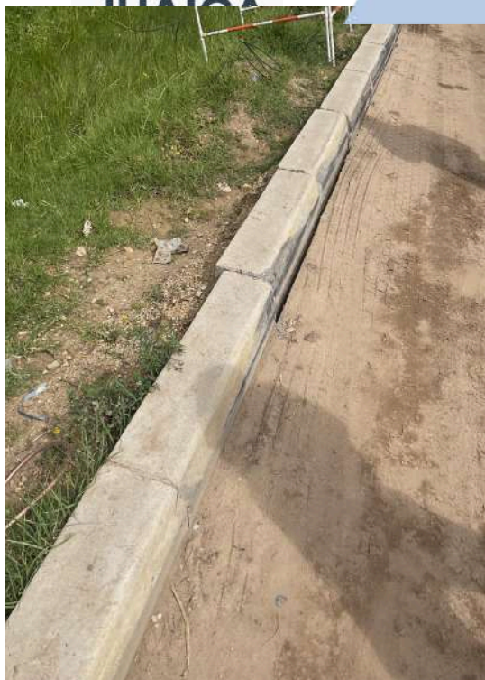
K+380 COSTADO NORTE
