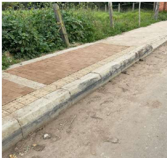
K+20 A K+70 DESPRENDIMIENTO DE SARDINELES, DESPORTILLADOS, MANCHADOS, FISURADOS
