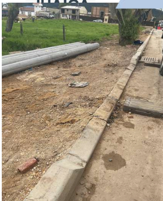
K+80 COSTADO NORTE
