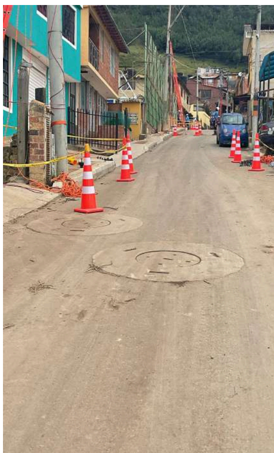
K+500 COSTADO SUR
