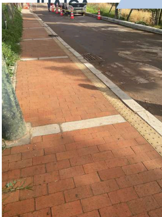
K+ 470 COSTADO SUR
