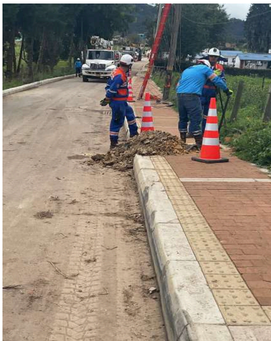
K+ 470 COSTADO SUR
