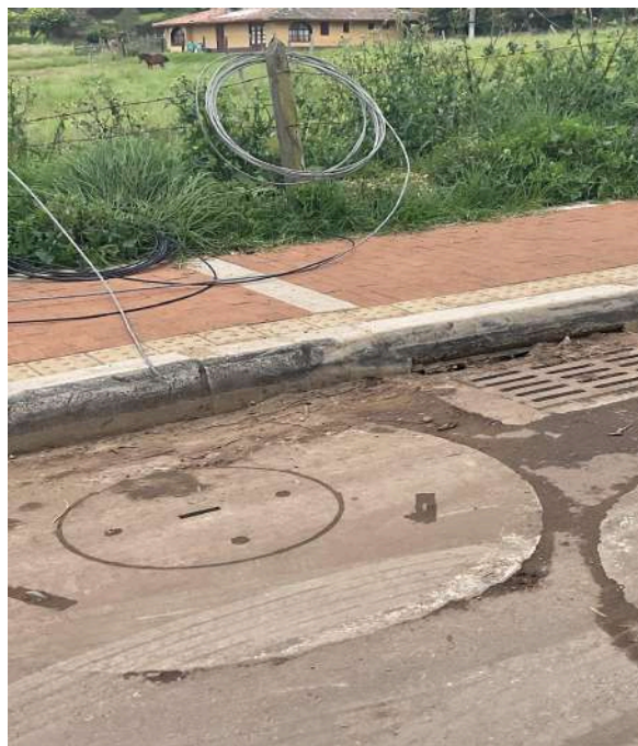
K+490 COSTADO SUR
