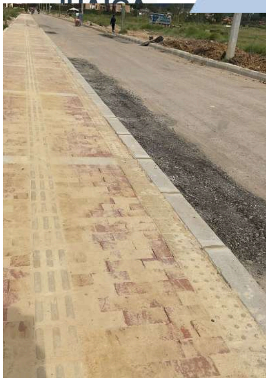
K+270 COSTADO NORTE
