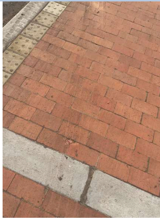
K+480 COSTADO SUR
