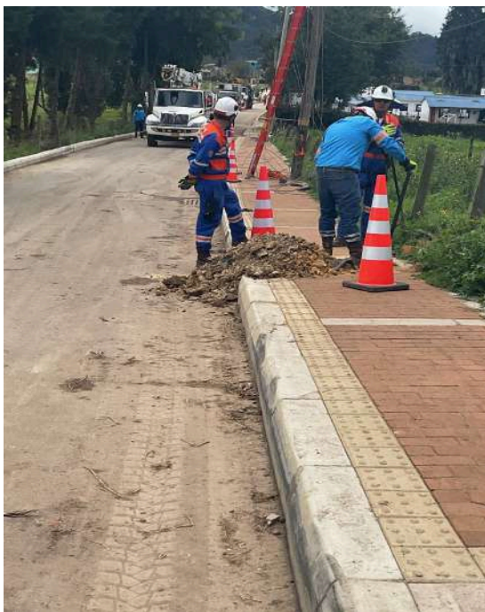
K+ 470 COSTADO SUR
