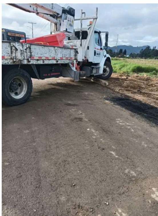
K+ 240 COSTADO SUR
