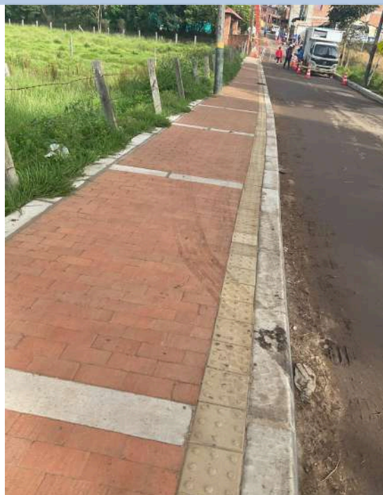
K+470 COSTADO SUR
