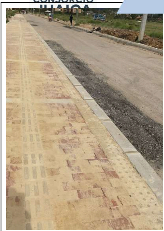
K+270 COSTADO NORTE
