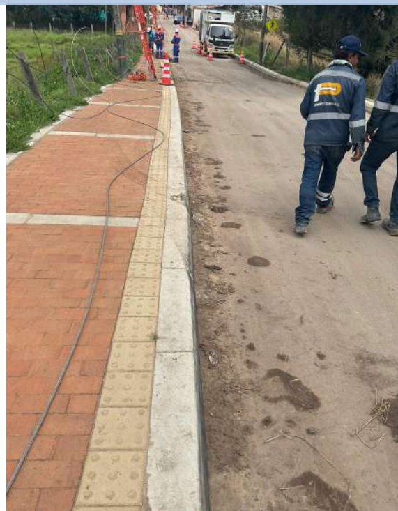
K+ 470 COSTADO SUR
