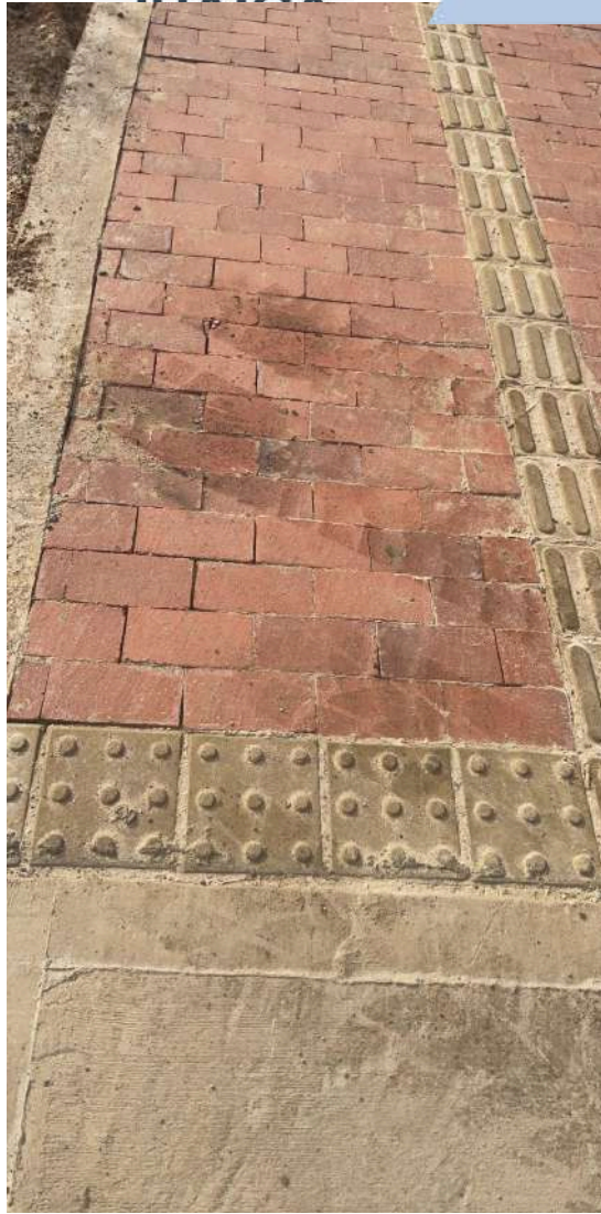
K+230 COSTADO NORTE
