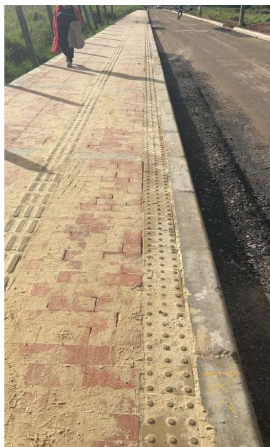
K' +280 COSTADO NORTE
