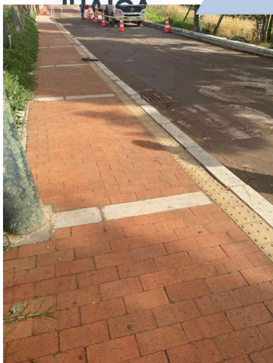
K+ 470 COSTADO SUR
