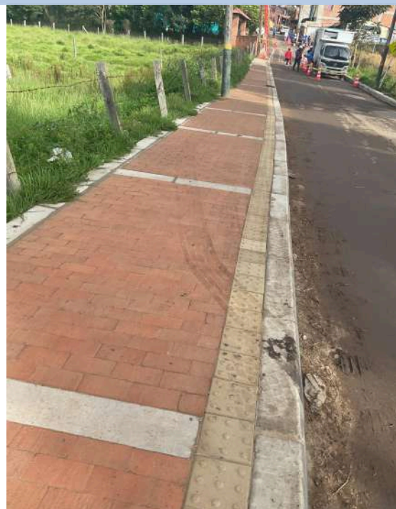
K+470 COSTADO SUR
