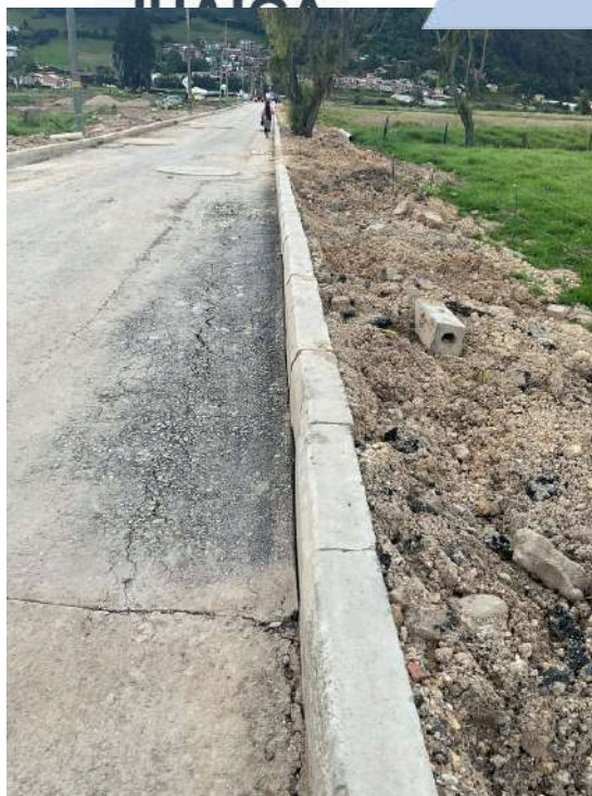
K+20 A K+70 DESPRENDIMIENTO DE SARDINELES, DESPORTILLADOS, MANCHADOS, FISURADOS
