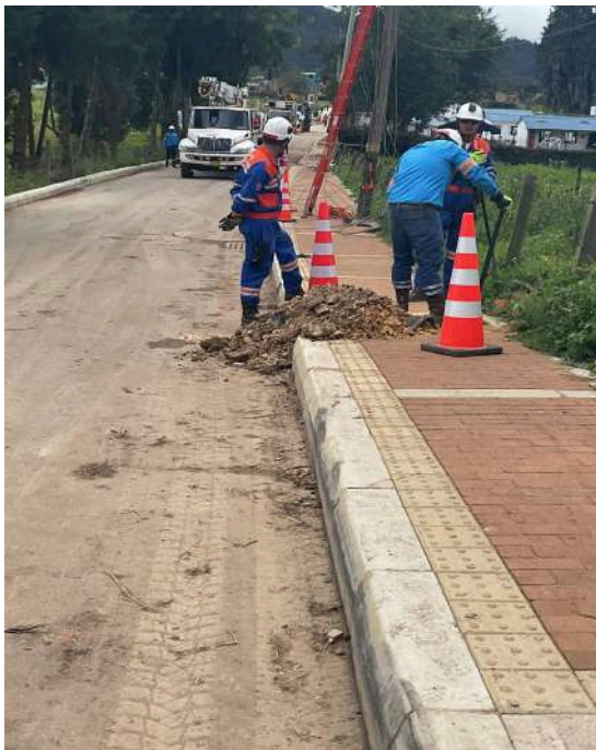
K+ 470 COSTADO SUR
