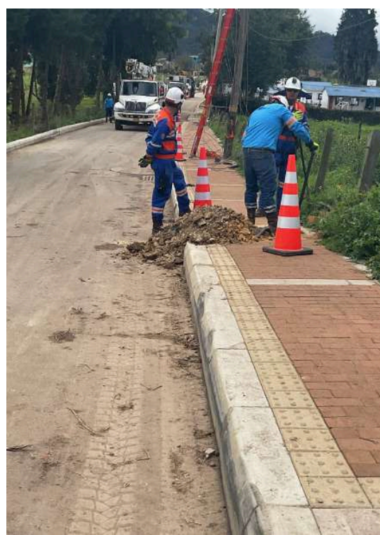
K+470 COSTADO SUR
