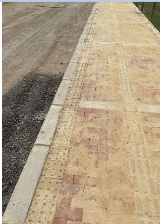
k+270 COSTADO NORTE
