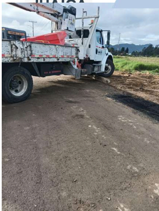
K+ 240 COSTADO SUR
