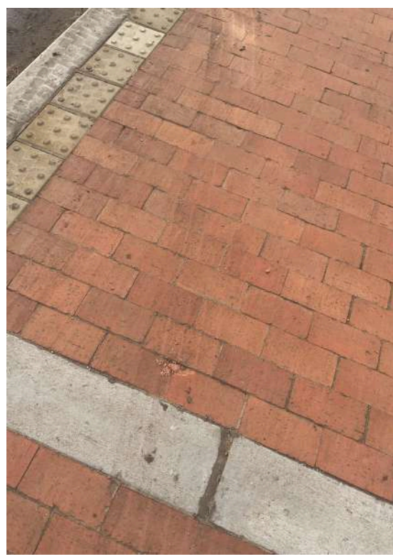
K+480 COSTADO SUR
