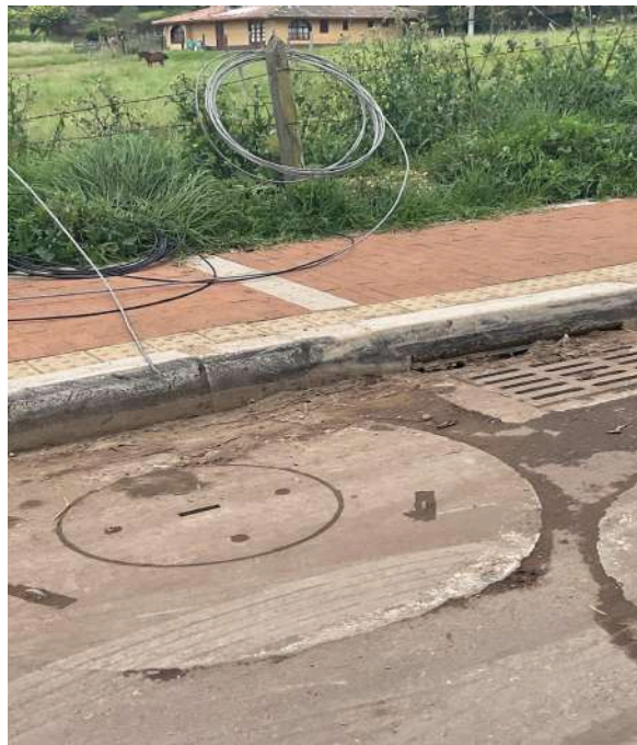
K+490 COSTADO SUR
