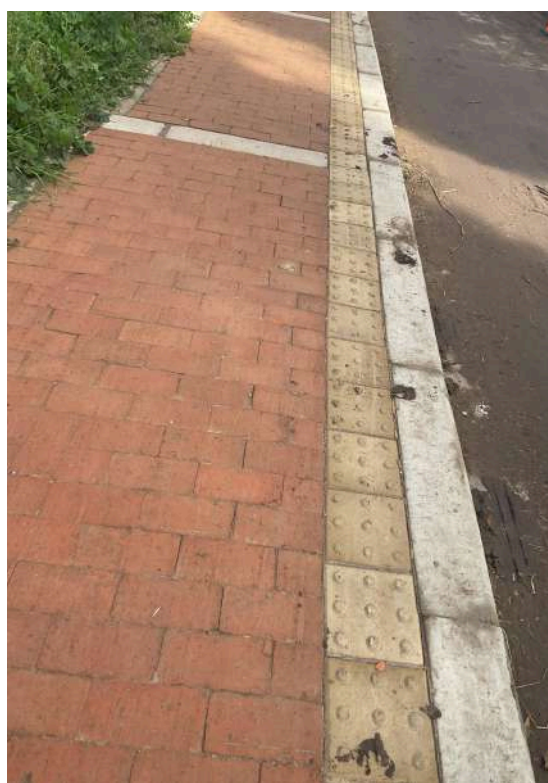
K+ 480 COSTADO SUR
