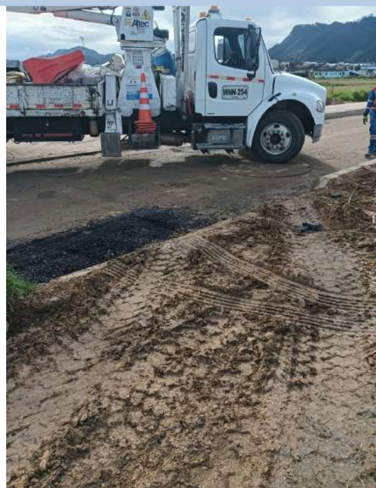
K+ 240 COSTADO NORTE
