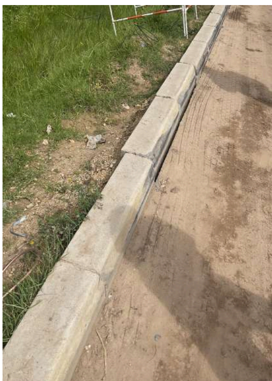
K+380 COSTADO NORTE
