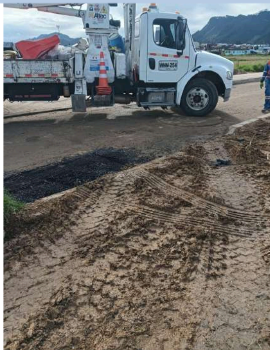
K+ 240 COSTADO NORTE
