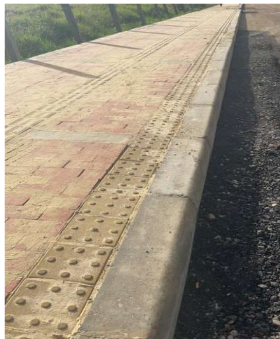
K+280 COSTADO NORTE
