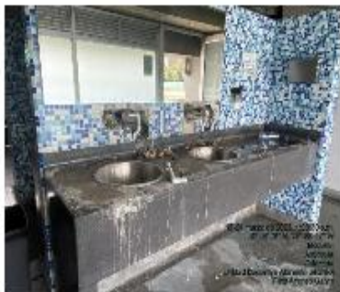
Adecuación e instalación sistema hidráulico push en lavamanos
