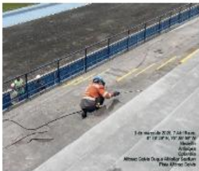
Lavado de guarderías con hidrolavadora
