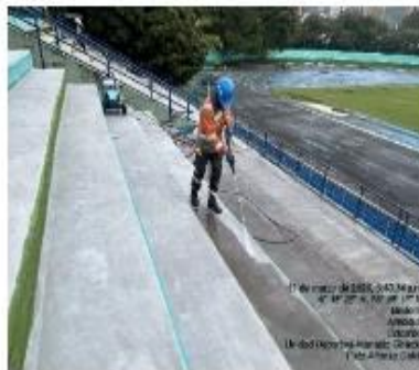
El lavado se realiza solo con agua de acuerdo a la recomendación del proveedor
