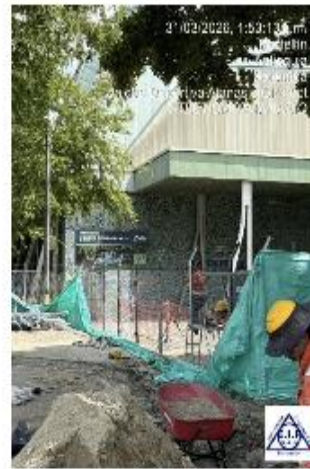
En este punto se hace cambio de malla
