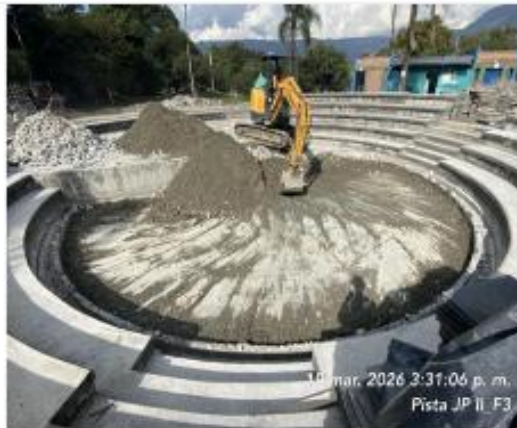
DEMOLICIÓN LOSA DE CONCRETO EN ROTONDA CENTRAL
