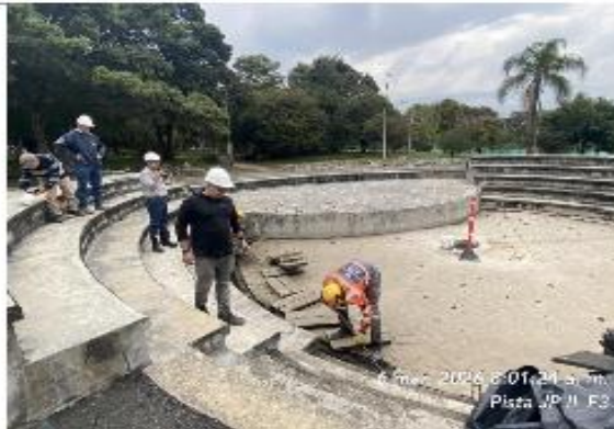
INVESTIGACIÓN DE REDES HIDROSANITARIAS EN ROTONDA CENTRAL
