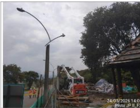
DEMOLICIÓN DE MÓDULOS COMERCIALES
