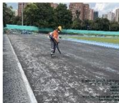
Una vez retirado el material se procedió a la limpieza de residuos pequeños con soplador
