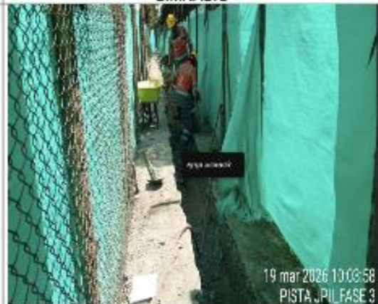
EXCAVACIÓN PARA VIGA DE CIMENTACIÓN EN CERRAMIENTO EXTERNO
