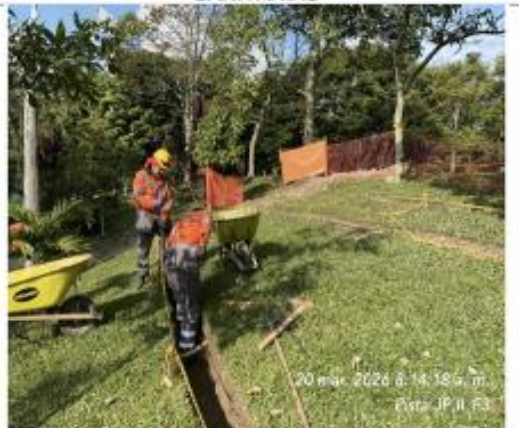
MARCACIÓN DE GAVIONES EN ZONA DE GIMNASIO
