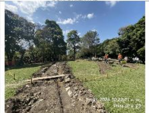
MARCACIÓN CON TOPOGRAFÍA Y RETIRO DE GRAMA EN ZONA DE GIMNASIO
