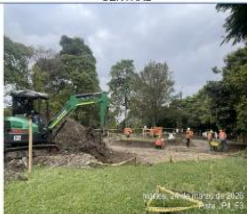
EXCAVACION DE HUELLA EN EL GIMNASIO
