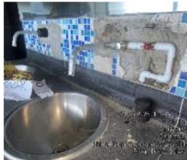
Instalación llave de paso en cada sistema hidráulico de push en lavamanos
