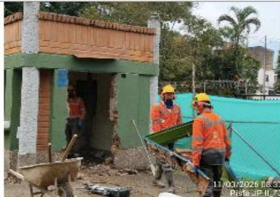
INICIA DEMOLICIÓN DE MÓDULOS COMERCIALES
