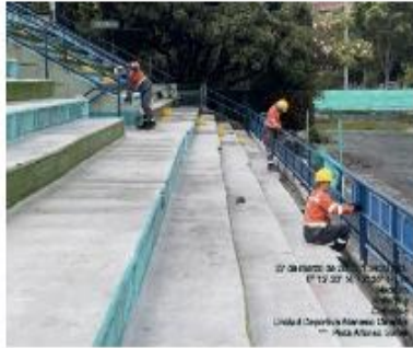
Mantenimiento de pasamanos metálico en la zona de gradería.
