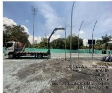
Retiro de elementos de la jaula ubicados en la media luna costado sur
