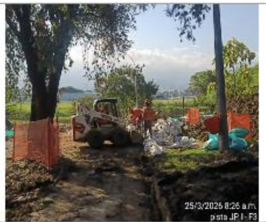
ACOPIO DE MATERIAL PRODUCTO DE LAS DEMOLICIONES DE MÓDULOS Y UNIDADES SANITARIAS
