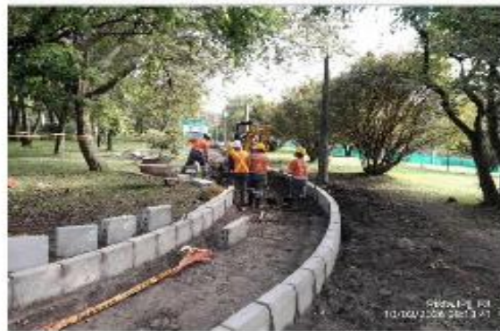
INSTALACIÓN DE CORDONERÍA EN PISTA DE TROTE
