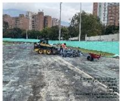
Retiro de material tapete en el bobcat
