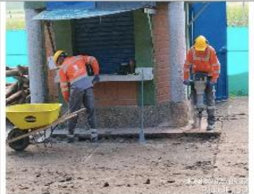
DEMOLICIÓN DE PISOS EN MÓDULOS COMERCIALES
