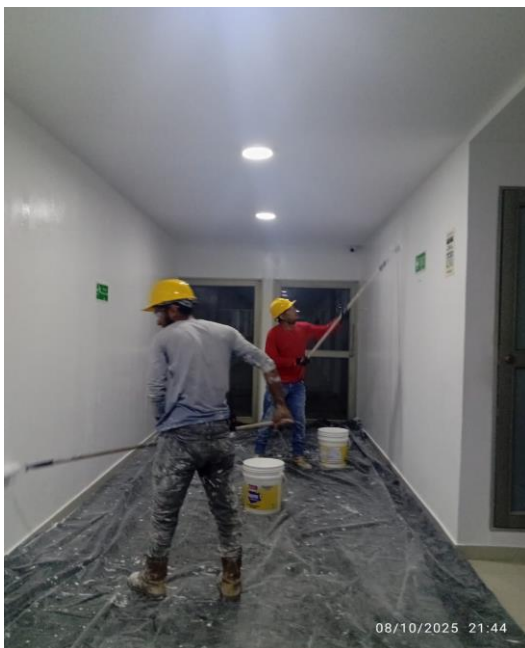
Aplicación de pintura vinilo tipo I en muros interiores – Piso 2.
