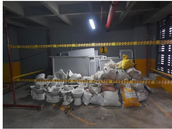
Lugar de acopio de los materiales – Sótano.
