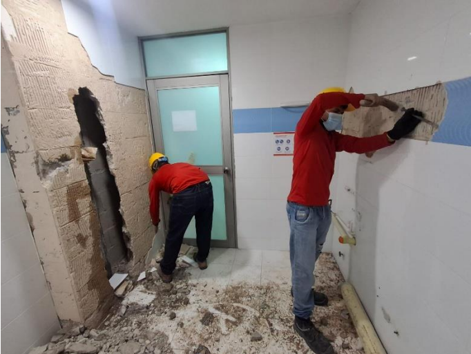
Demolición de enchape de muros – Piso 5.
