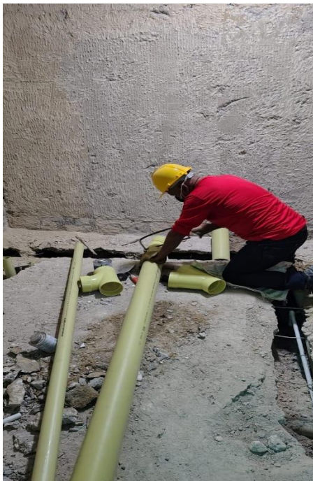
Suministro de tubería sanitaria de 4" y 2" – Piso 6
