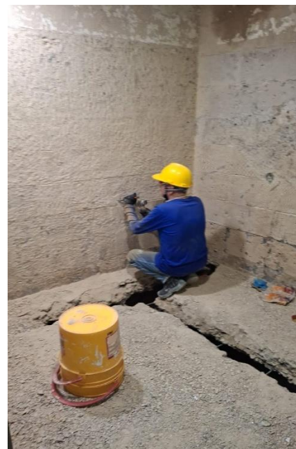
Estratificación de muros – Piso 5
