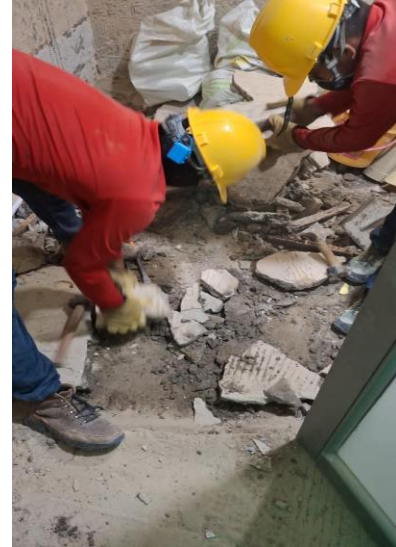
Demolición de enchape de piso – Piso 5.
