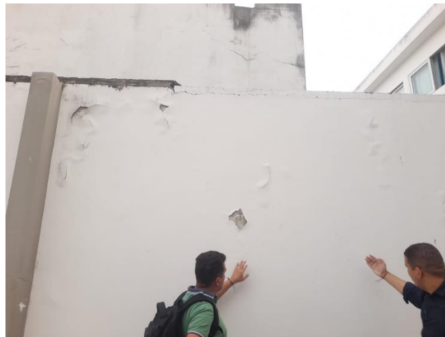
INSPECCIÓN TECNICA PARA VERIFICACIÓN DEL ESTADO ACTUAL DE MUROS EN EL PARQUEADERO DEL PALACIO DE JUSTICIA DE COROZAL
