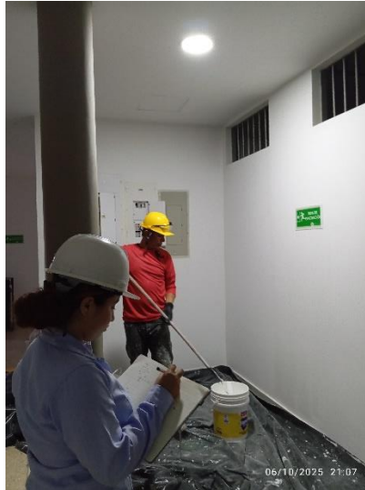
SUPERVISIÓN DE ACTIVIDADES EJECUTADAS EN EL FRENTE DEL PALACIO DE JUSTICIA COROZAL: APLICACIÓN DE PINTURA VINILO BLANCA (REVISIÓN DE CALIDAD DE MATERIALES Y CANTIDADES EJECUTADAS)
