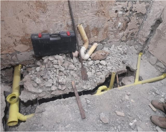
Instalación de tubería sanitaria de 4" y 2" – Piso 6.
