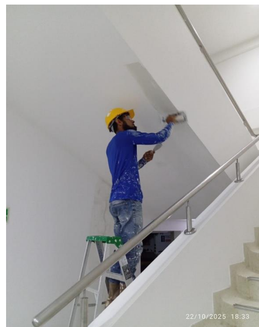
Resane de muro interior en área de escaleras previo a aplicación de pintura vinilo tipo I – Piso 1.
