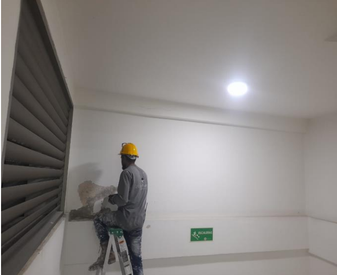
Raspado y resane de muro previo a aplicación de pintura vinilo tipo I en área interior – Zona escaleras.
