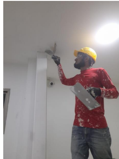
Raspado y resane de muro previo a aplicación de pintura vinilo tipo I en área interior – Piso 3.
