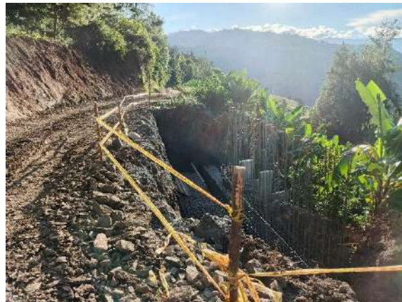
Fig. 66: Señalización de la zona de trabajo.
