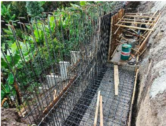
Fig. 25: Corte, figurado y armado de aceros.
