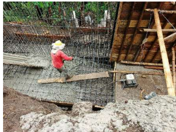
Fig. 34: Armado de formaleta y vaciado de concreto.
