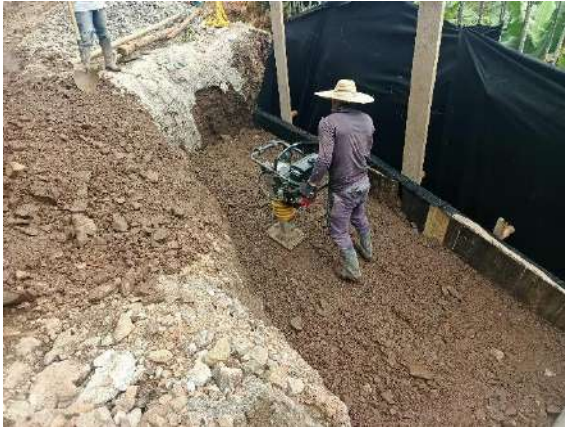
Fig. 51: Relleno compactado zona de muro y filtro drenante.
