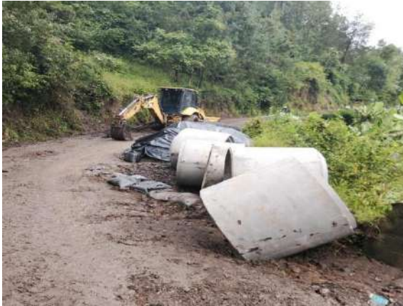
Fig. 47: Tubería de alcantarilla de 900 mm.
