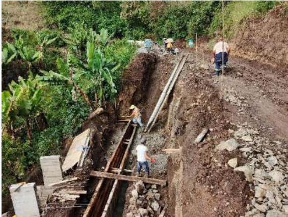
Fig. 17: Mejoramiento de terreno con concreto ciclópeo.
