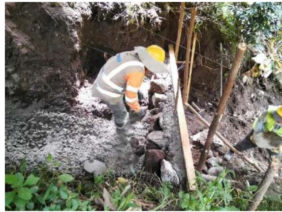
Fig. 14: Mejoramiento de terreno con concreto ciclópeo.
