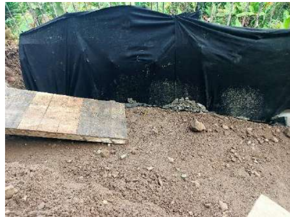
Fig. 54: Relleno compactado zona de muro y filtro drenante.
