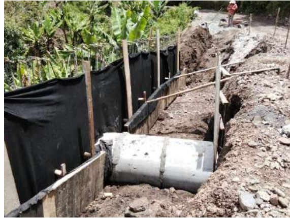
Fig. 48: Tubería de alcantarilla de 900 mm.
