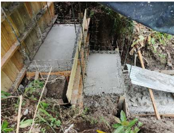
Fig. 27: Armado de formaleta y vaciado de concreto.
