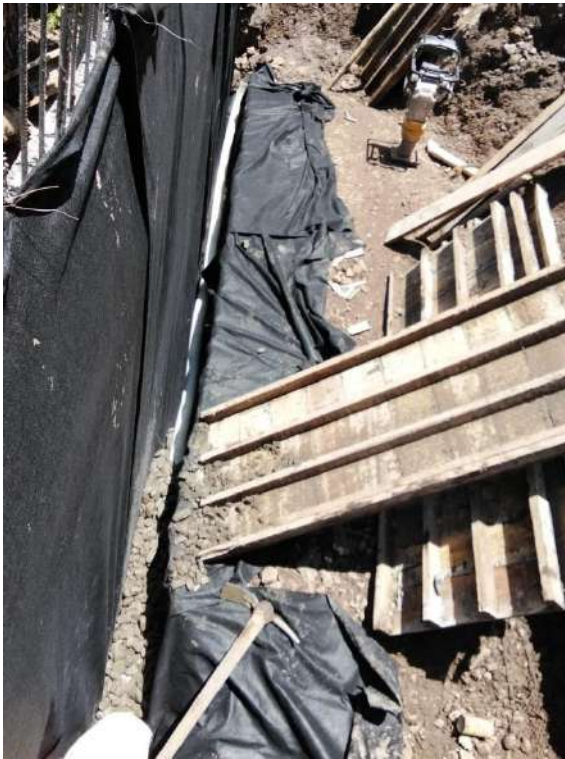
Fig. 49: Tubería perforada de drenaje de 4 plg y geotextil.
