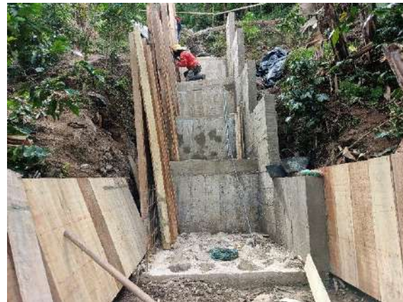
Fig. 32: Armado de formaleta y vaciado de concreto.
