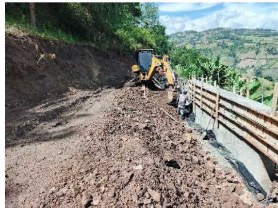
Fig. 56: Relleno compactado zona de muro y filtro drenante.
