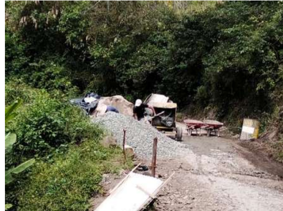
Fig. 12: Acopio de materiales, cerca de obras.
