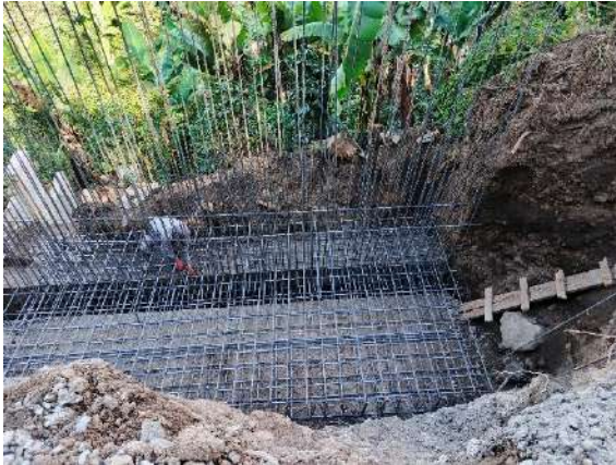
Fig. 23: Corte, figurado y armado de aceros.
