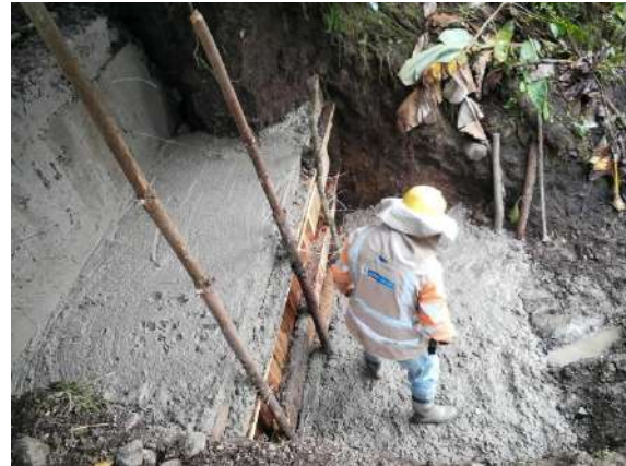
Fig. 16: Mejoramiento de terreno con concreto ciclópeo.
