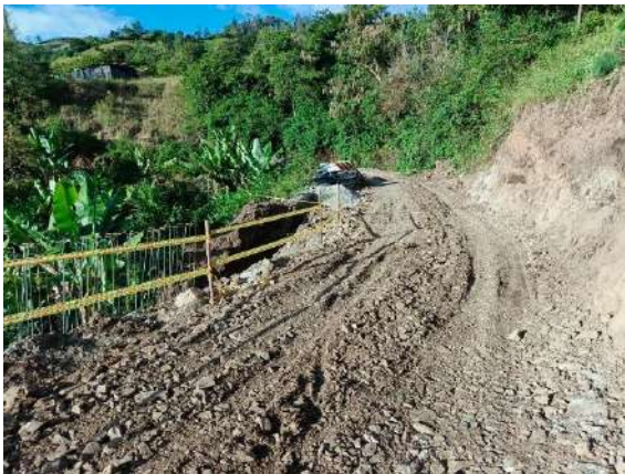
Fig. 65: Señalización de la zona de trabajo.
