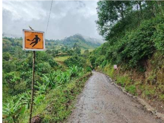
Fig. 64: Señalización de la zona de trabajo.
