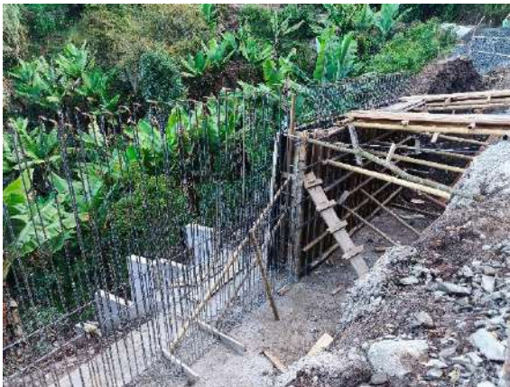
Fig. 37: Armando de formaleta y vaciado de concreto.
