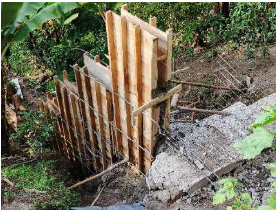
Fig. 31: Armado de formaleta y vaciado de concreto.
