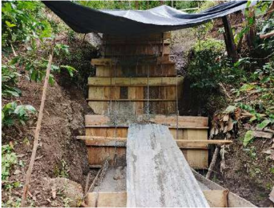
Fig. 29: Armado de formaleta y vaciado de concreto.
