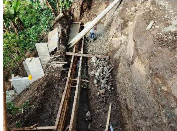
Fig. 18: Mejoramiento de terreno con concreto ciclópeo.
