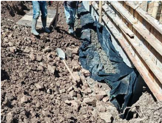
Fig. 57: Relleno compactado zona de muro y filtro drenante.
