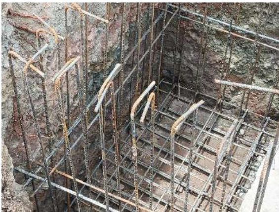
Fig. 21: Corte, figurado y armado de aceros.
