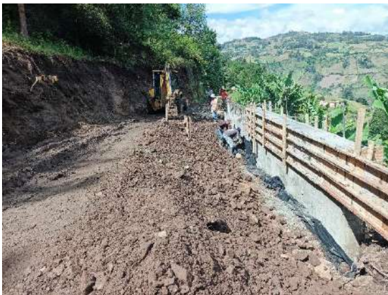
Fig. 55: Relleno compactado zona de muro y filtro drenante.
