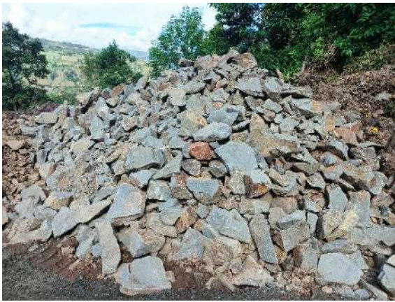
Fig. 13: Acopio de materiales, cerca de obras.
