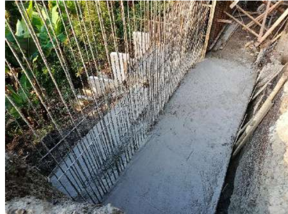
Fig. 36: Armando de formaleta y vaciado de concreto.
