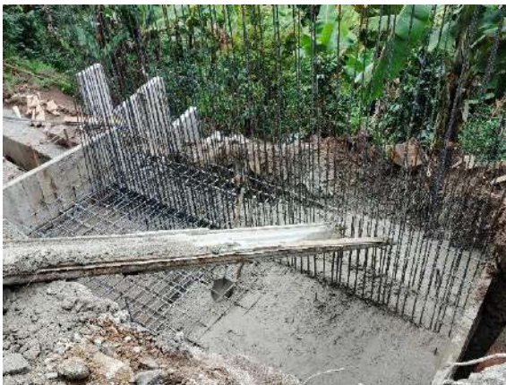
Fig. 33: Armado de formaleta y vaciado de concreto.
