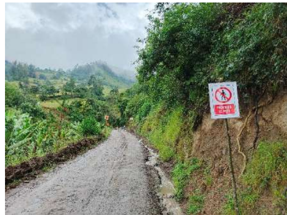
Fig. 62: Señalización de la zona de trabajo.
