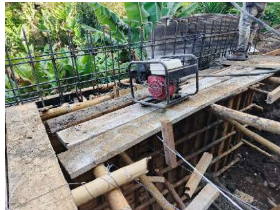
Fig. 38: Armando de formaleta y vaciado de concreto.
