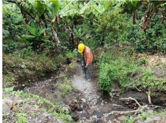
Fig. 2: Demolición de concretos de alcantarilla.
