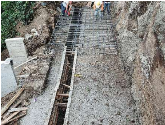
Fig. 19: Mejoramiento de terreno con concreto ciclópeo.
