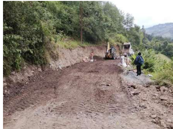
Fig. 58: Relleno compactado zona de muro y vía.
