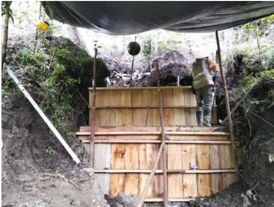
Fig. 15: Mejoramiento de terreno con concreto ciclópeo.
