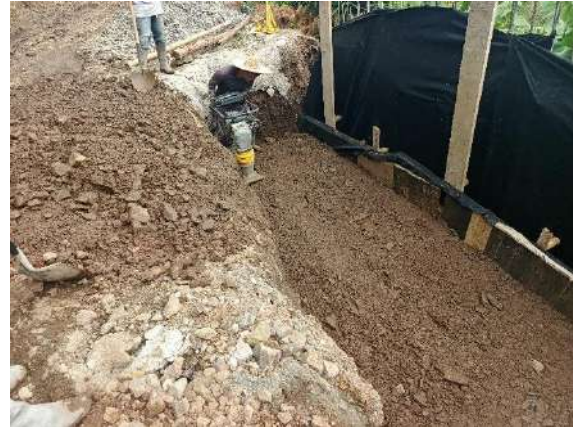
Fig. 52: Relleno compactado zona de muro y filtro drenante.
