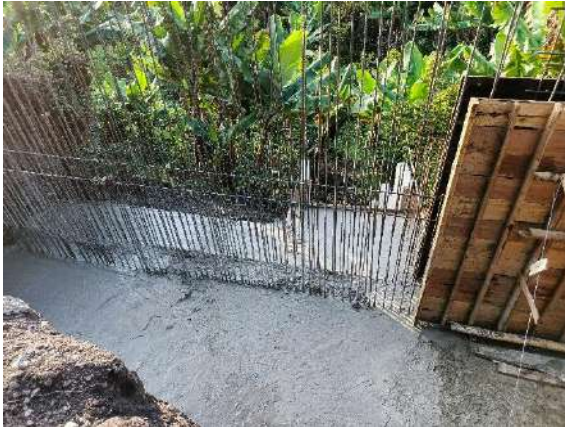
Fig. 35: Armando de formaleta y vaciado de concreto.
