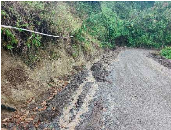
Fig. 59: armado de cunetas para encauzar aguas lluvias.
