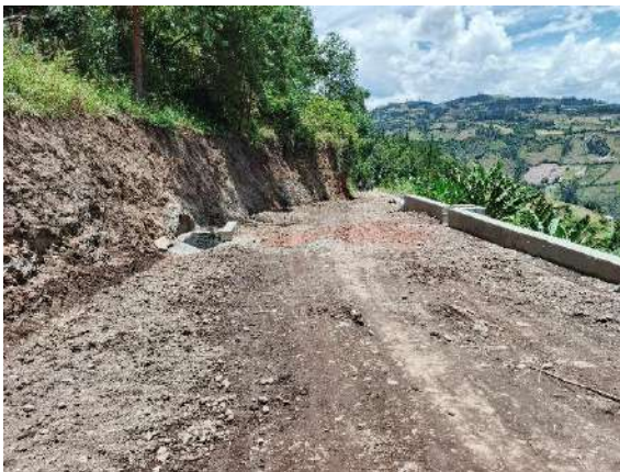
Fig. 61: armado de cunetas para encauzar aguas lluvias.
