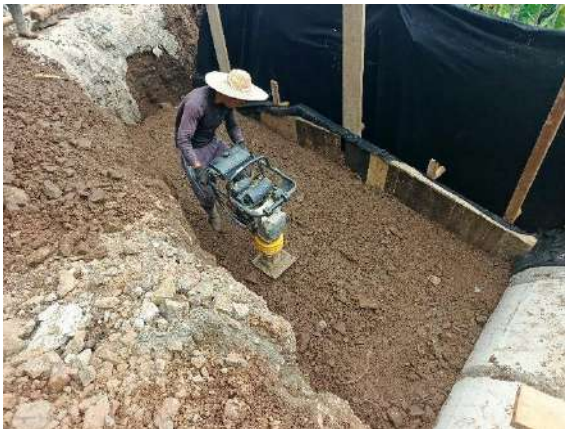
Fig. 53: Relleno compactado zona de muro y filtro drenante.
