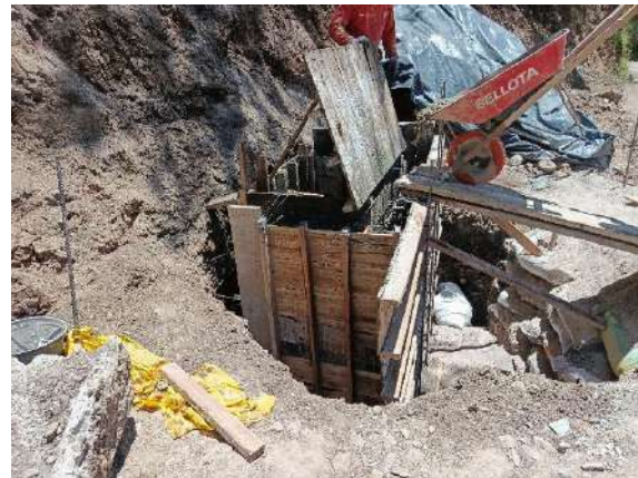
Fig. 26: Armado de formaleta y vaciado de concreto.
