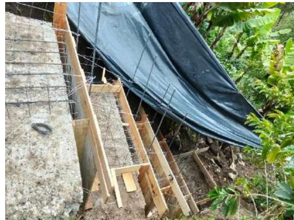
Fig. 20: Corte, figurado y armado de aceros.
