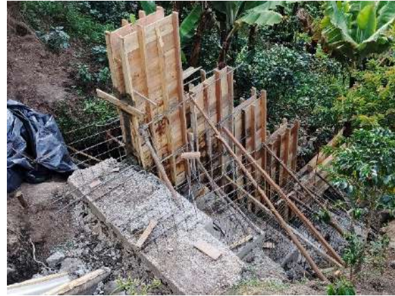
Fig. 30: Armado de formaleta y vaciado de concreto.
