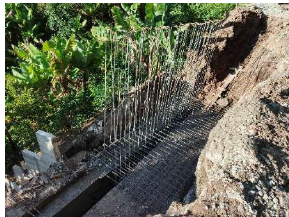
Fig. 22: Corte, figurado y armado de aceros.
