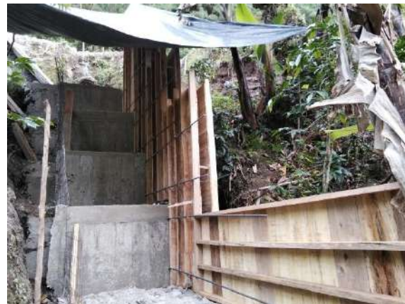
Fig. 28: Armado de formaleta y vaciado de concreto.
