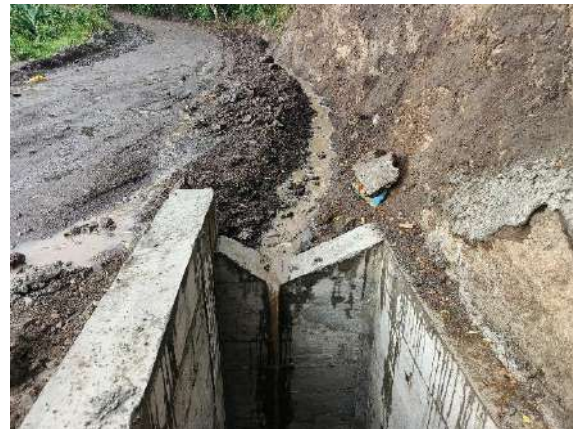
Fig. 60: armado de cunetas para encauzar aguas lluvias.
