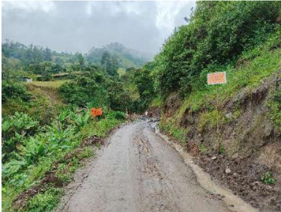
Fig. 63: Señalización de la zona de trabajo.
