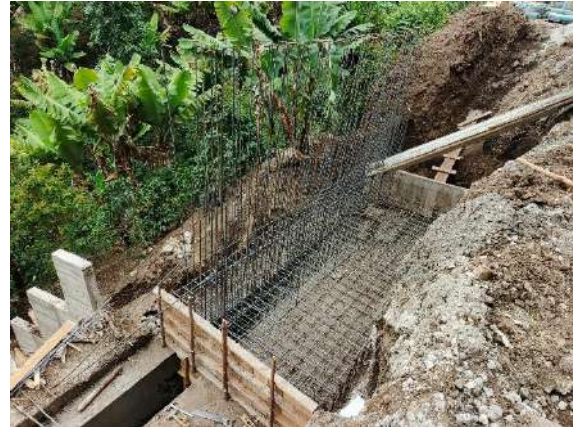
Fig. 24: Corte, figurado y armado de aceros.
