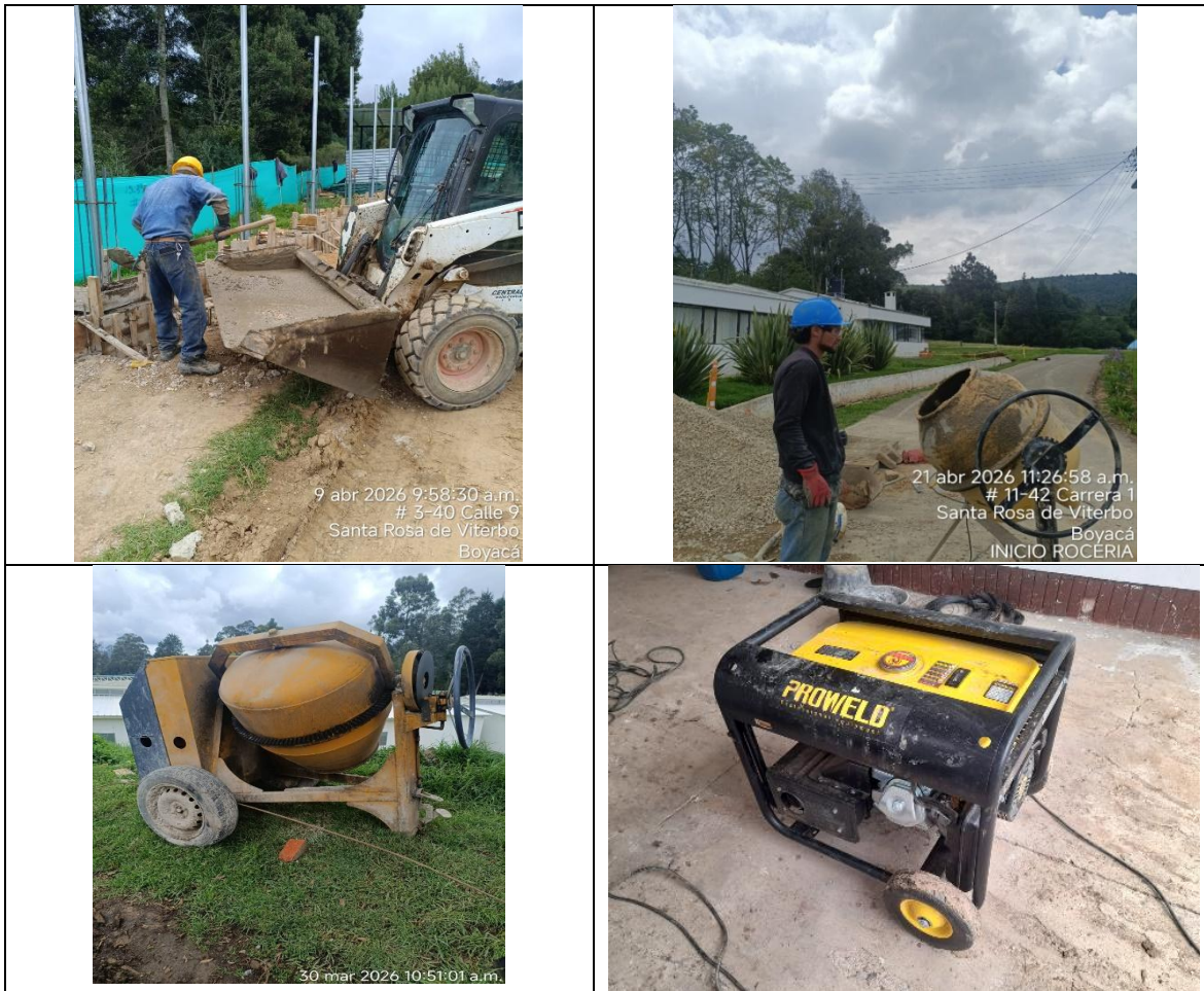
Uso de herramientas manuales para instalación de cerramiento en obra.
