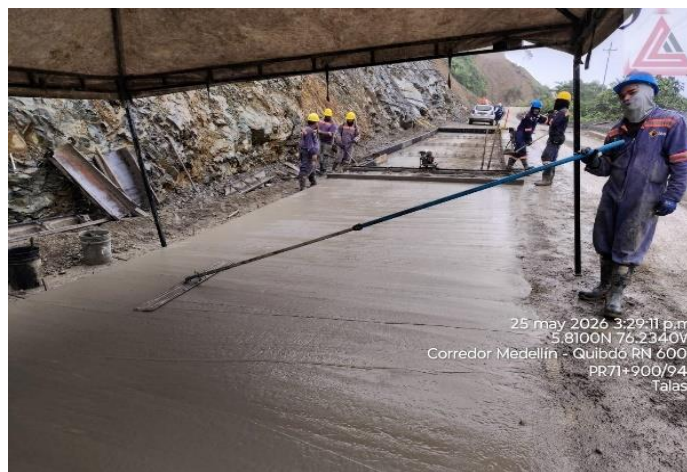
Figura 13. PR71+900/945 Ruta 6002. Instalación de concreto para placas de pavimento carril izquierdo
