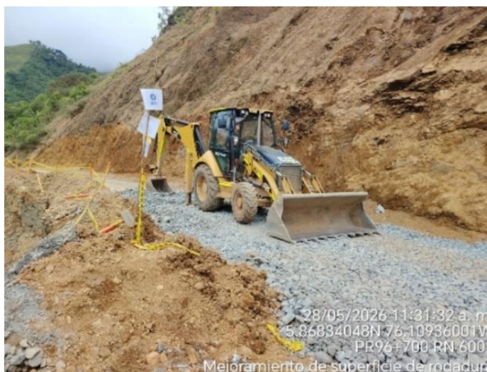
Figura 24. PR96+700 Ruta 6002. Mejoramiento superficie de rodadura
