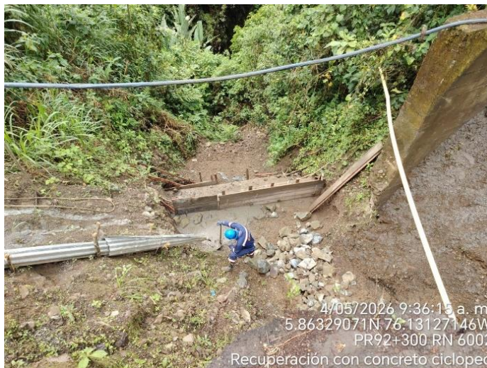
Figura 27. PR97+050 Ruta 6002. Pr92+300 Ruta 6002. Reposición escalonada para muro
