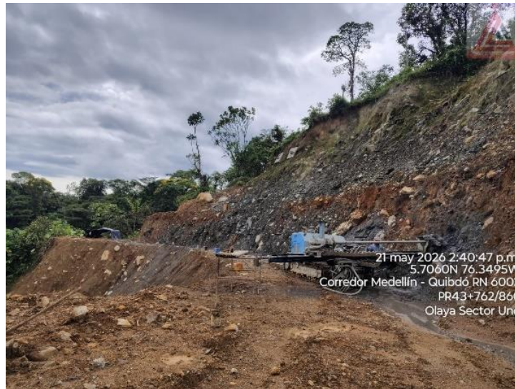
Figura 3. PR43+762/860 Ruta 6002. Perforación para instalación de drenes sub horizontales sobre talud terraza No 2.
