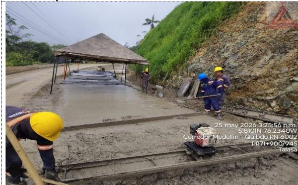
PR71+900/945 Ruta 6002, Instalación concreto para placas de pavimento carril izquierdo
