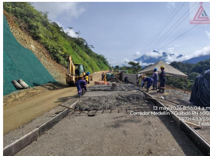
Figura 17. PR71+483/550 Ruta 6002. Instalación de concreto para placas pavimento margen derecha.
