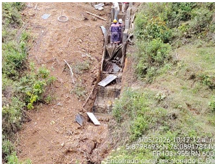
Figura 20. Pr103+955 Ruta 6002. Canal escalonado
