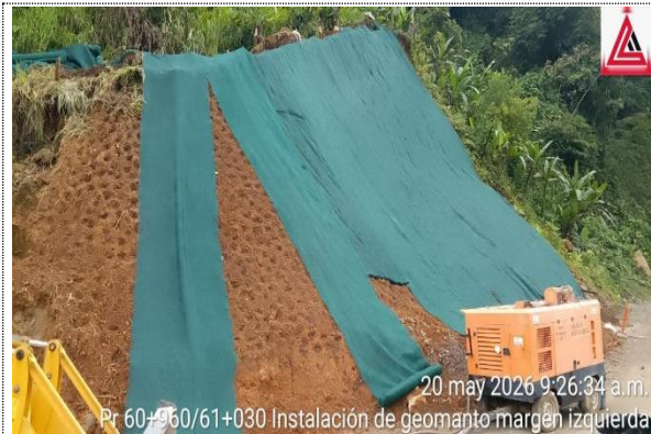
Pr 60+960/61+030 Ruta 6002. Empradización de talud e Instalación de manto permanente TRM500
