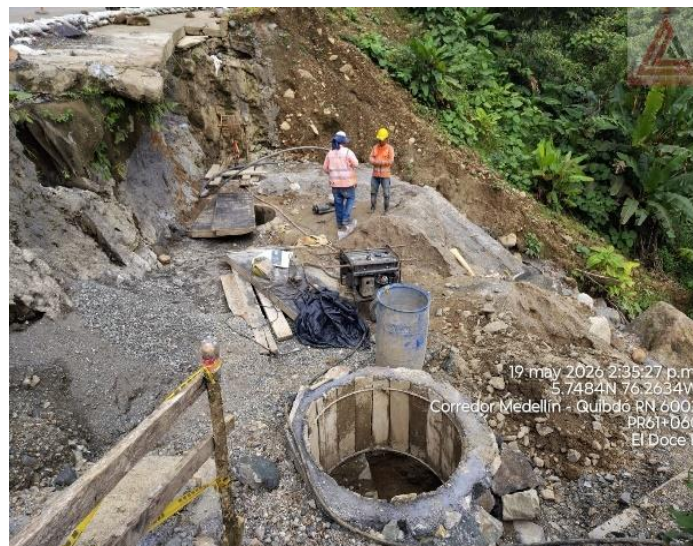
Figura 8. PR61+060 Ruta 6002. Excavación pilas para muro margen derecha
