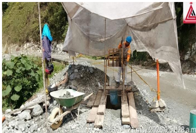
Figura 12. Pr 70+140 Ruta 6002. Excavación manual de pilas estribo 2, puente #9
