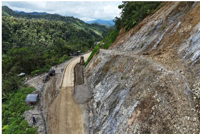
Figura 16. PR71+900/945 Ruta 6002. Conformación de terraza y nivelación Subrasante margen izquierda.
