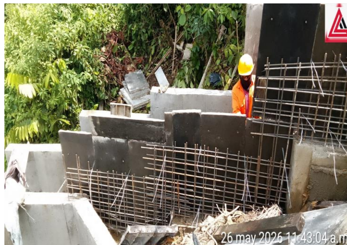
Figura 4. Pr 43+980 Ruta 6002. Instalación de refuerzo y Encofrado muros laterales dissipador
