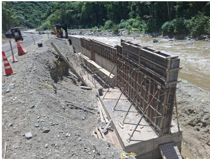
Figura 22. Pr36+0350 Ruta 6003. Distribución de acero de refuerzo y formaleas para concluir el vaciado de la mezcla de concreto para los vástagos.
