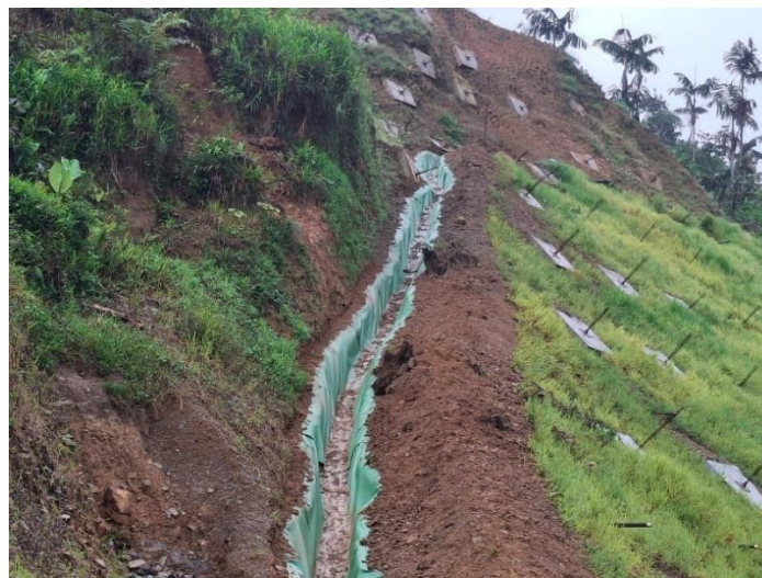
Figura 18. Pr73+0500 Ruta 6002. Cuneta perimetral en realidad izquierdo
