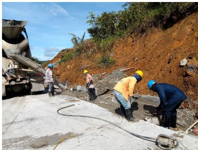
Figura 11. Pr 66+545.47/620.20 Ruta 6002. Vaciado de berma cunetas iniciales margen izquierda
