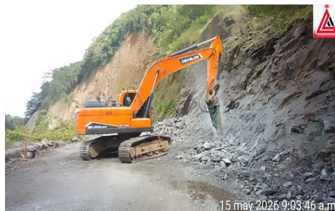
Figura 5. Pr 45+000 Ruta 6002. Explanación en Roca con retroexcavadora con martillo
