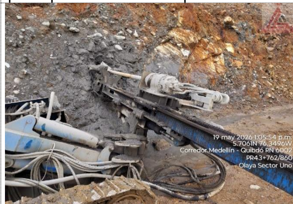
PR43+762/860 Ruta 6002. Perforación para instalación de drenes sub horizontales sobre talud terraza No.2.
