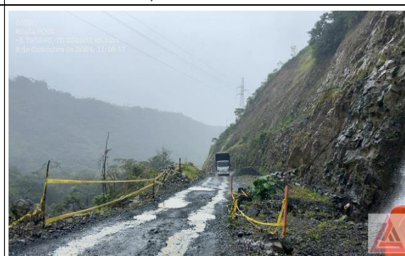
PR68+350 RUTA 6002, ESTADO CAPA DE RODADURA.
