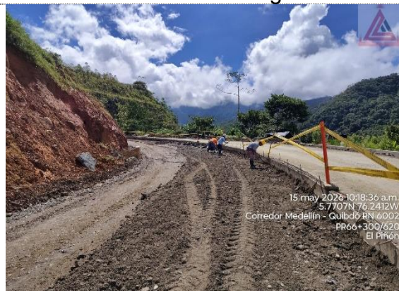
PR66+545/620 Ruta 6002. Nivelación subrasante márgen izquierda.
