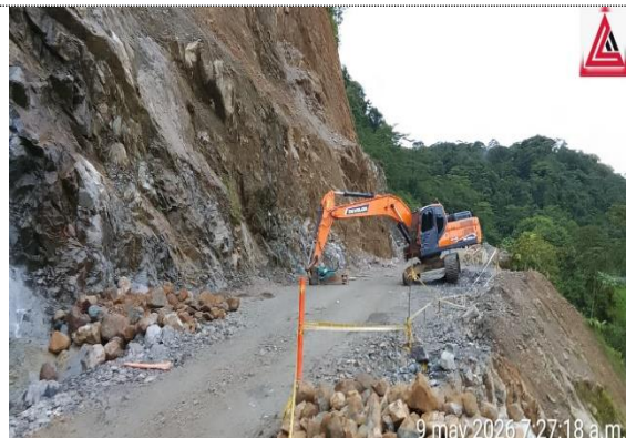
Pr 44+800 Ruta 6002, Explanación en Roca con retroexcavadora con martillo sector toldas
