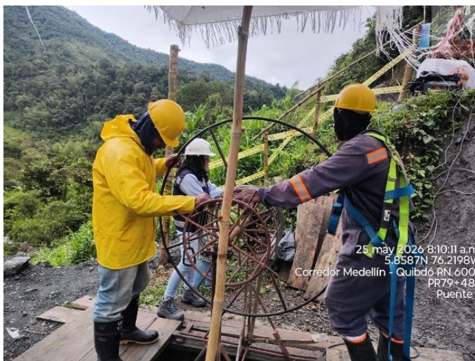
Figura 19. PR79+480 Ruta 6002. Puente 3 Excavación pila No.3
