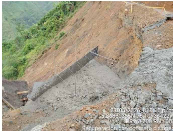
Figura 25. PR96+700 Ruta 6002. Recuperación con concreto ciclopeo
