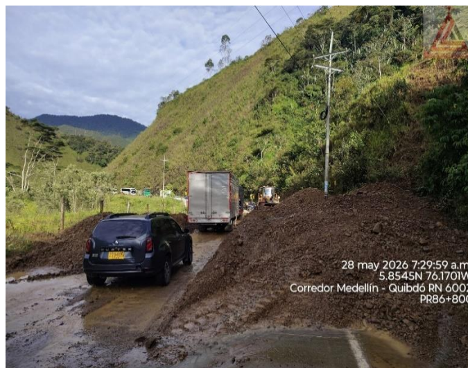
Figura 28. Remoción de derrumbes
