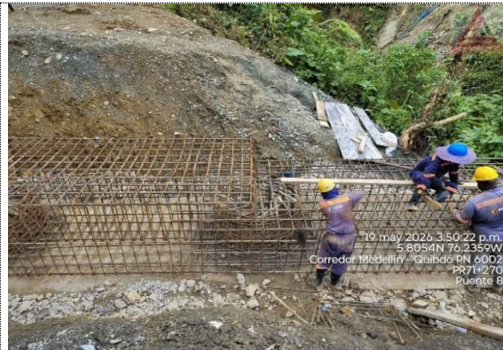
PR71+270 Ruta 6002. Instalación acero para viga estribo de entrada puente 8.
