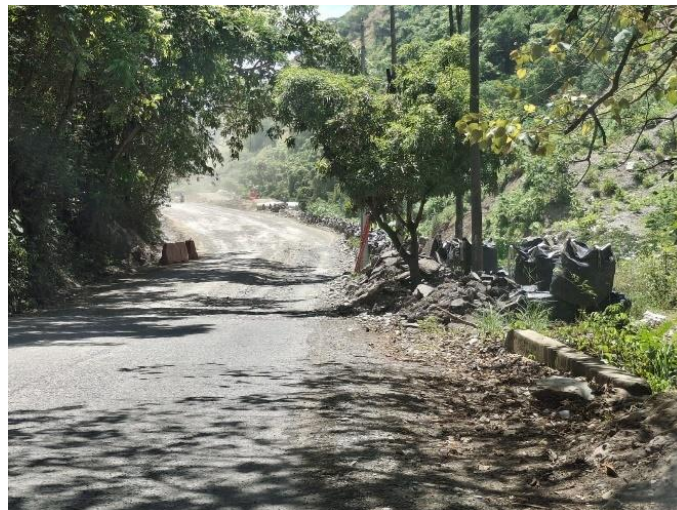
Figura 23. Pr36+0180 Ruta 6002. Sector La Chuchita Se ha conformado a nivel de SBR para la nueva estructura del pavimento.
