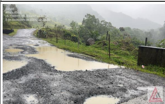
PR 52+635 RUTA 6002, ESTADO CAPA DE RODADURA.
