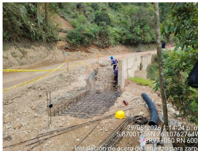
Figura 26. PR97+050 Ruta 6002. Instalación de acero de refuerzo para zarpa
