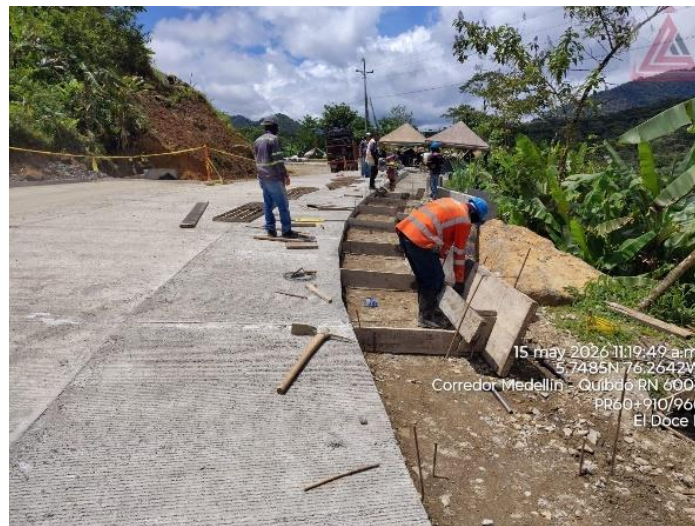
Figura 7. PR60+910/960 Ruta 6002. Fundición cunetas margen derecha.
