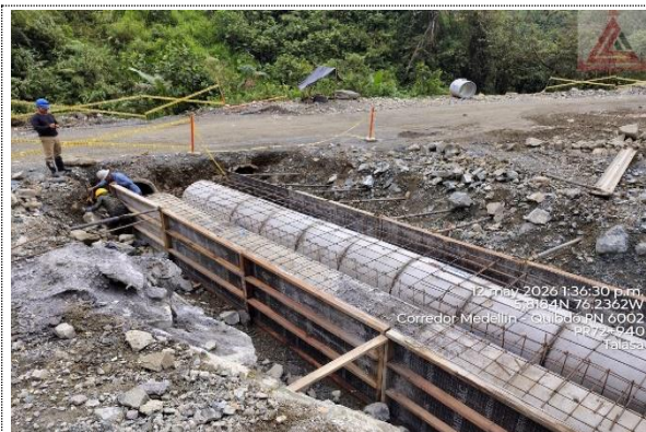
PR72+940 Ruta 6002, Instalación formaleta (encofrado) para alcantarilla tubería doble de 36".
