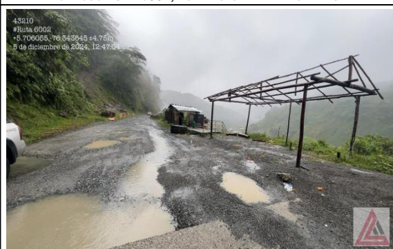
PR 43+210 RUTA 6002, ESTADO CAPA DE RODADURA.
