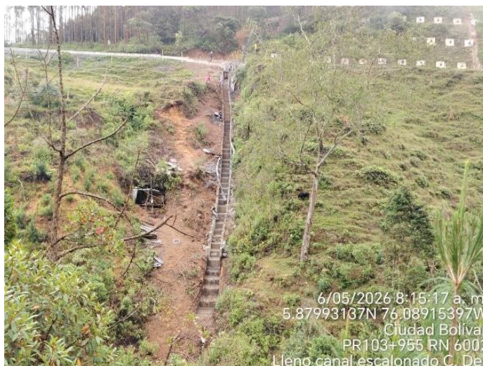
Figura 21. Pr103+955 Ruta 6002. Lleno con material común
