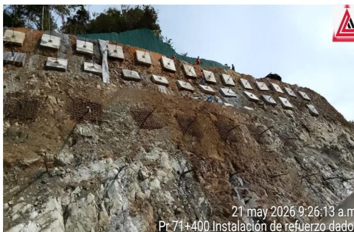
Figura 14. Pr 71+400 Ruta 6002. Instalación de refuerzo y Encofrado dados para anclajes
