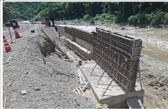
Pr36+0350_Ruta 6003, Sector La Chuchita Margen derecha Muro Instalación / distribución de acero de refuerzo y formaletas
