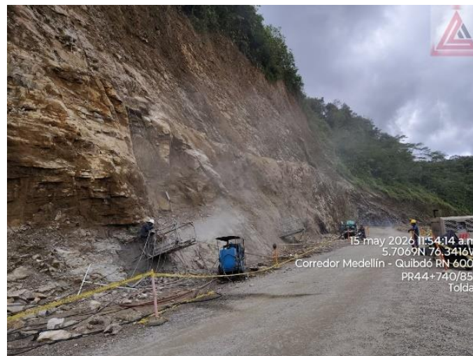
Figura 6. PR44+740/850 Ruta 6002. Perforación para instalación de pernos longitud 4,00m.
