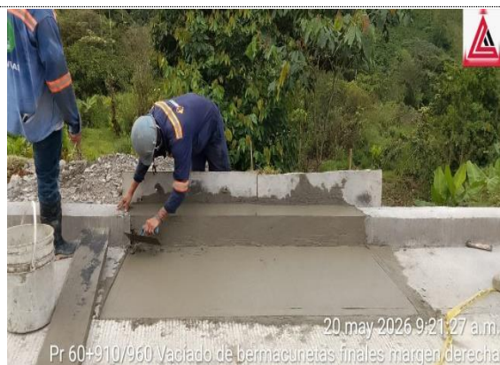
Pr 60+910/960 Ruta 6002. Vaciado de bermacunetas finales margen derecha
