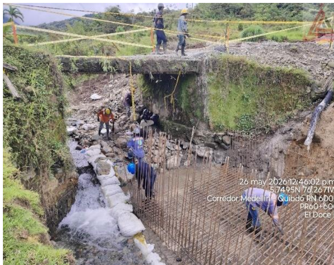
Figura 9. PR60+600 Ruta 6002. Figurado acero para box Culvert margen derecha.
