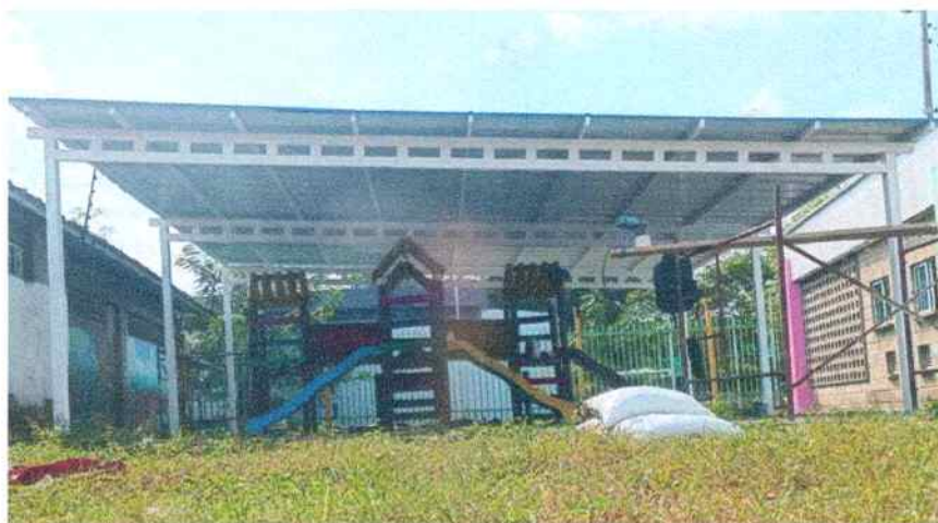
SUMINISTRO E INSTALACIÓN DE TEJA GALVANIZADA
