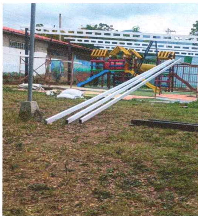
CUBIERTA EN ESTRUCTURA METALICA
