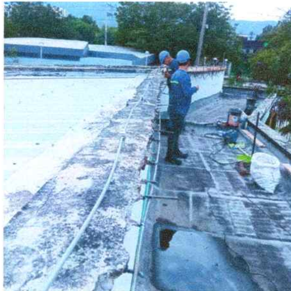
REPARACION DE GOTEROS EN CONCRETO , ANCLADOS EN ACERO.
