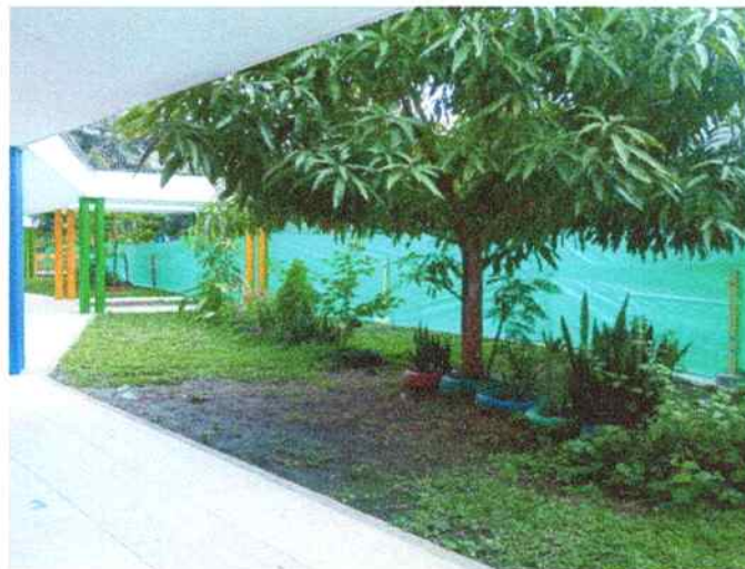
Cerramiento en lona de protección, se usó para aislar los niños del área de intervención.
