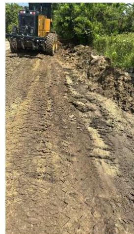
Imagen 2 Actividades de excavación
