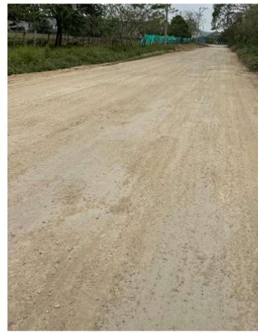
Imagen 9 Conformación de calzada
