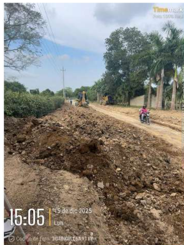
Imagen 1 Actividades de excavación
