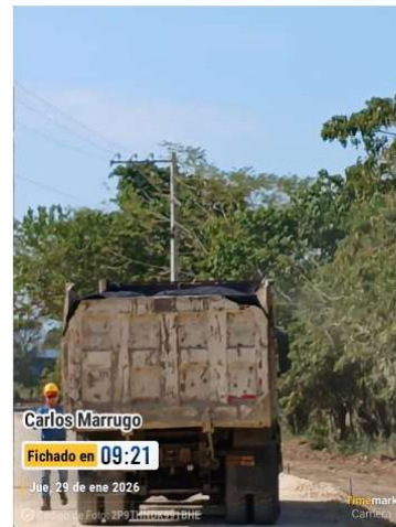
Imagen 7 Actividades de excavación
