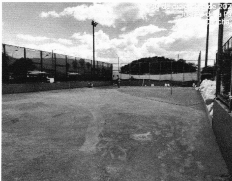
Cancha de tenis No 2, en ejecución
