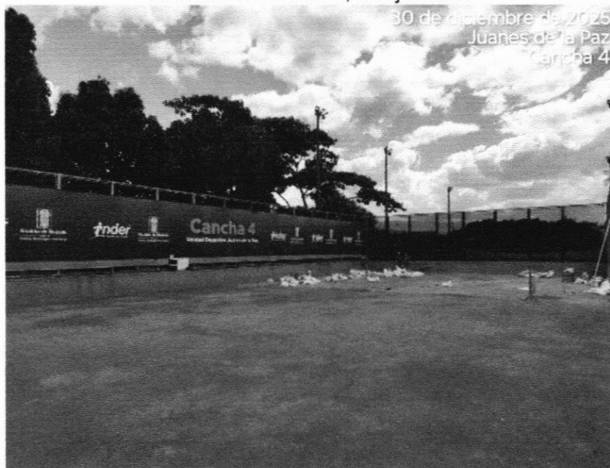
Cancha de tenis No 4, en ejecución
