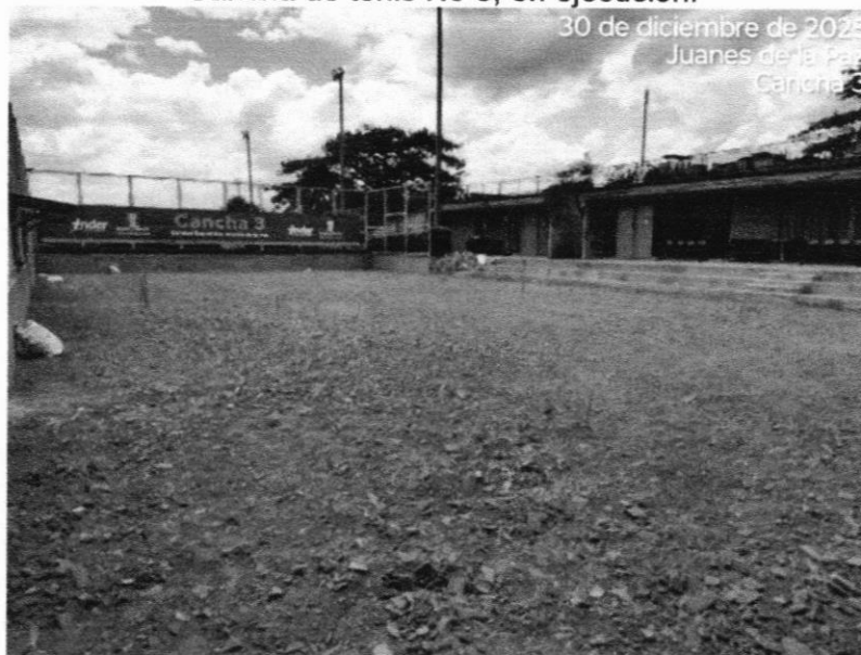
Cancha de tenis No 3, en ejecución.
