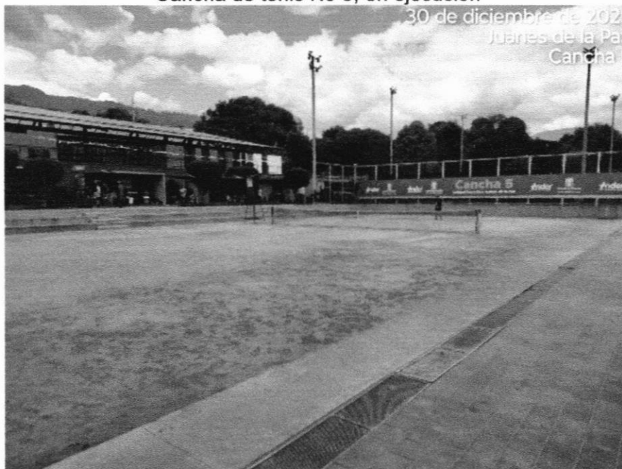
Cancha de tenis No 5, en ejecución
