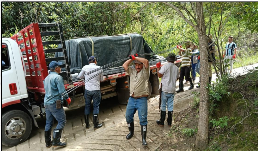
Apoyo en la entrega de Materiales y EPP Construcción Placa Huella – Proyecto FEC Zona veredal del Municipio de Manta - Cundinamarca
