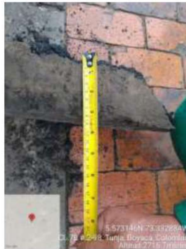
Fotografía 1. Espesor de carpeta asfáltica encontrado en Tramo 2
