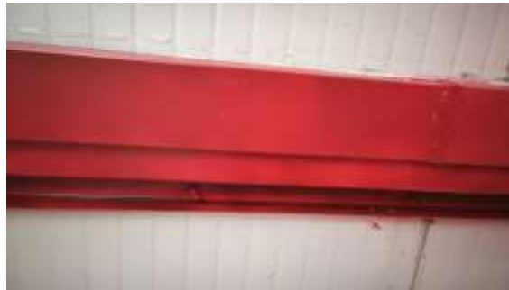
Foto # 18. Mantenimiento en la ludoteca tenemos fugas de agua sobre el techo necesitamos con urgencias.
