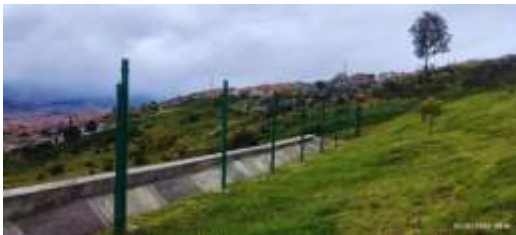
Fotos # 9, 10 y 11 Falta la malla de protección del muro de contención, zona peligrosa hay un abismo
