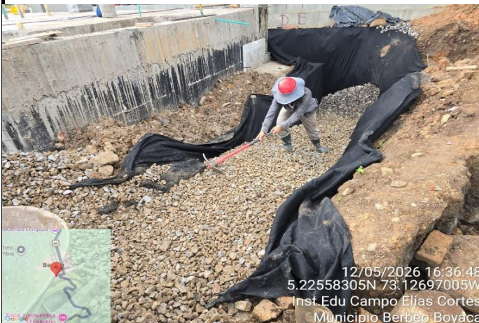
FOTO 23. CONSTRUCCION DE FILTRO
