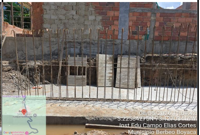
FOTO 18. INSTALACIÓN DE ACERO DE REFUERZO
