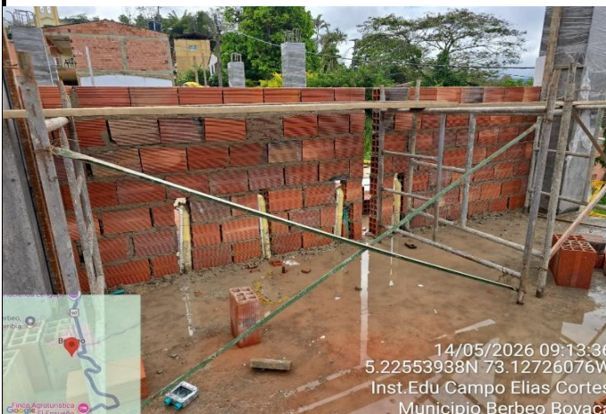
FOTO 29. CONSTRUCCIÓN DE MUROS DE MAMPOSTERÍA
