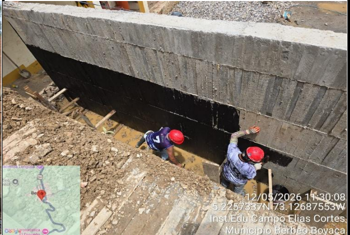
FOTO 22. CONSTRUCCIÓN DE MUROS DE MAMPOSTERÍA
