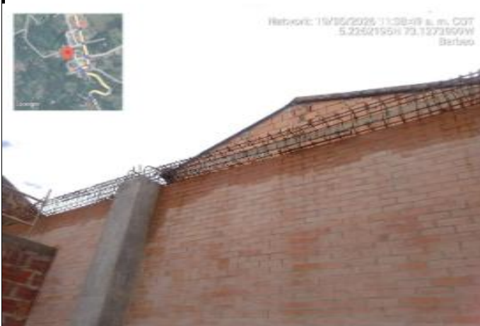
FOTO 11. INSTALACIÓN DE ACERO DE REFUERZO
