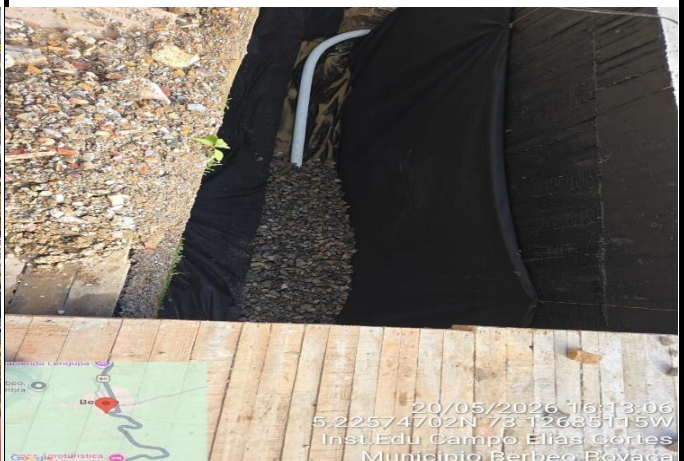
FOTO 24. CONSTRUCCION DE FILTRO
