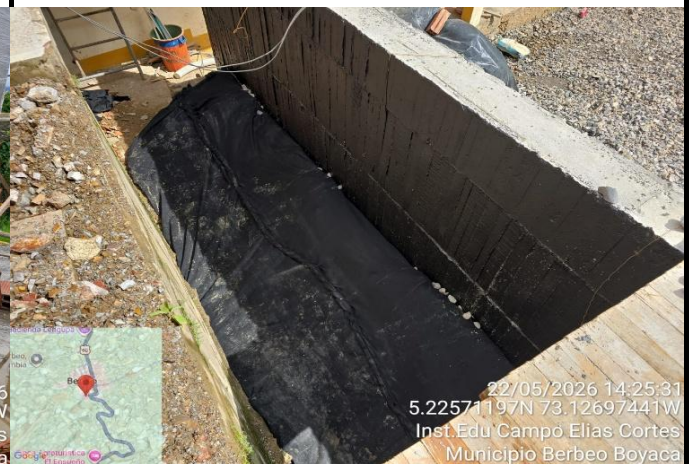
FOTO 30. CONSTRUCCION DE FILTRO
