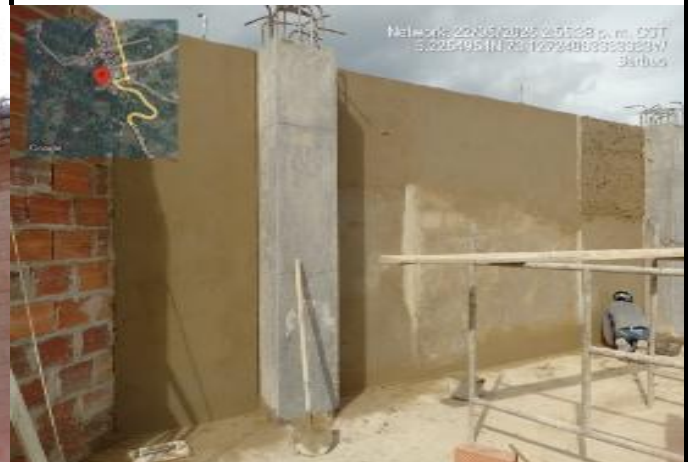
FOTO 12. INSTALACIÓN DE PAÑETE EN MUROS DE MAMPOSTERIA
