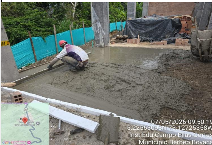
FOTO 17. INSTALACIÓN DE CONCRETO PARA PLACA
