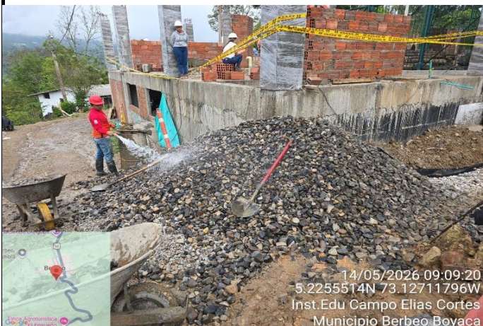
FOTO 23. CONSTRUCCION DE FILTRO
