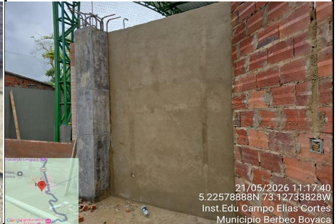
FOTO 28. CONSTRUCCIÓN DE MUROS DE MAMPOSTERÍA
