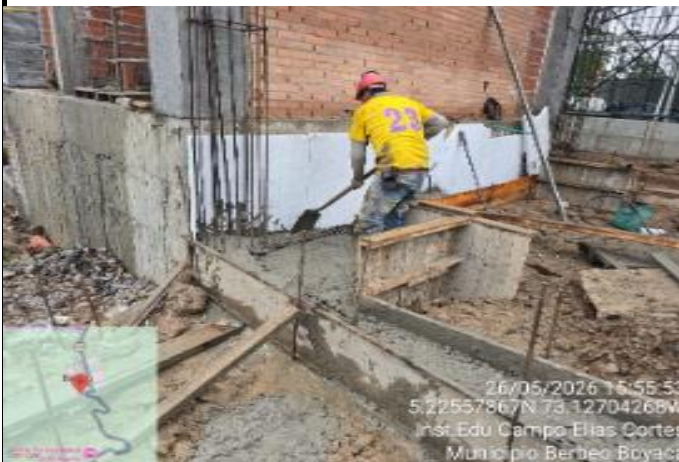
FOTO 17. INSTALACIÓN DE CONCRETO PARA PLACA
