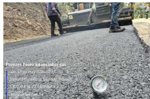
control y seguimiento temperatura de instalación mezcla asfáltica
