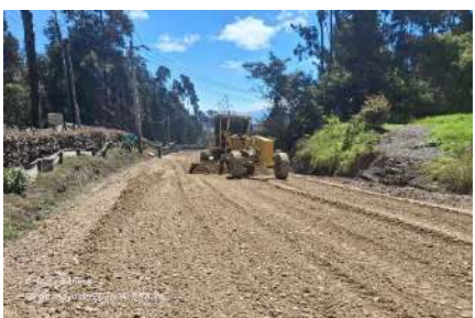
k5+350 a k6+400, conformación base granular primera capa
