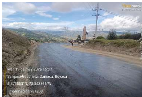
k8+800, imprimación para instalación mezcla asfáltica primera capa.
