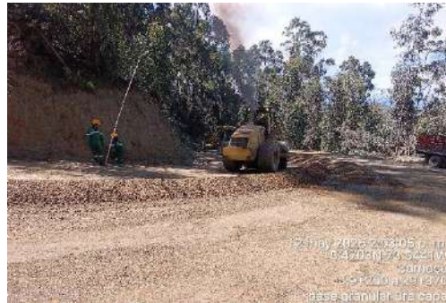
k9+000 a k9+370, conformación base granular 3ra capa
