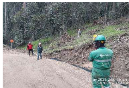
k9+000 a k+370, localización replanteo y niveles, bordes de vía
