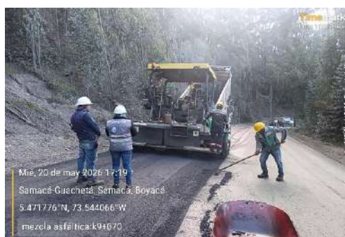
k9+000, riego de liga para instalación mezcla asfáltica segunda capa.
