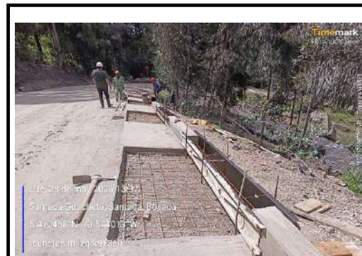
k9+270 a k9+370, instalación concreto 21mpa cunetas margen izquierda
