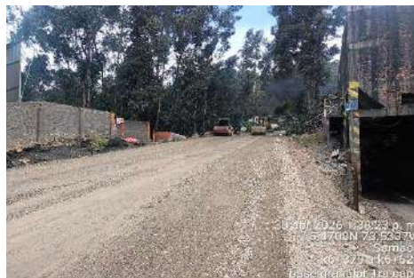
k6+570 a k6+890, instalación y conformación base granular primera capa.
