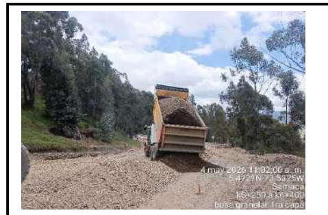
k6+250 a k6+400, suministro e instalación base granular primera capa
