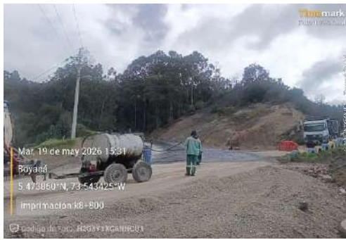
k8+800, imprimación para instalación mezcla asfáltica primera capa.
