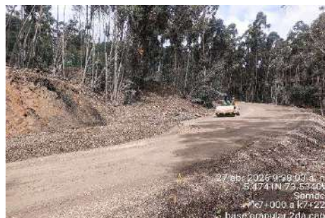
k6+890 a k7+220, instalación y conformación base granular segunda capa.
