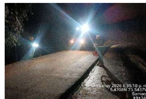
k9+040 a k7+370, riego de liga para mezcla asfáltica
