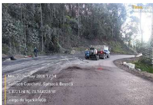
k9+000, riego de liga para instalación mezcla asfáltica segunda capa.
