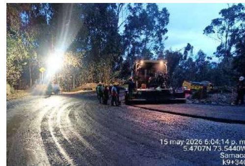
k9+040 a k7+370, instalación mezcla asfáltica (MDC 19), primera y segunda capa.
