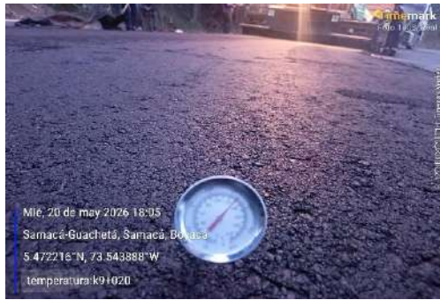
k9+070, seguimiento y control temperatura mezcla asfáltica segunda capa.
