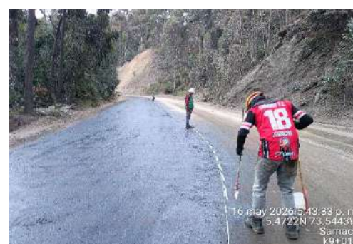
k9+000 a k9+370, punteo eje y bordes de vía para instalación de mezcla asfáltica
