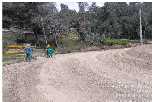
k8+500 a k8+700, localización replanteo y niveles, bordes de vía
