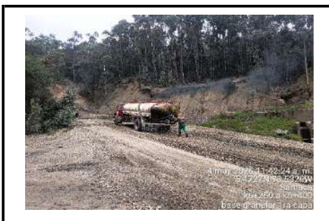
k5+350 a k6+370, humectación y compactación base granular primera capa
