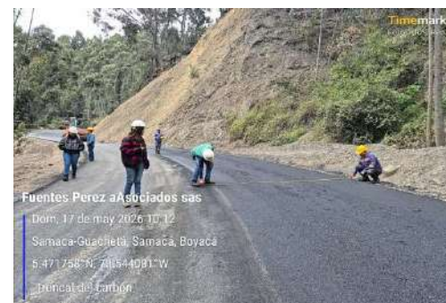
k9+040 a k7+370, riego de liga para mezcla asfáltica
