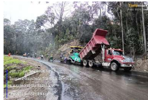
k8+880, instalación mezcla asfáltica segunda capa.
