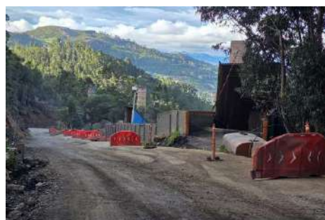
actividades área SST, señalización de obra
