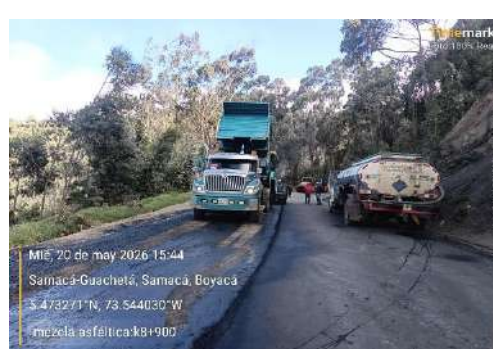
k8+900, instalación mezcla asfáltica primera capa.
