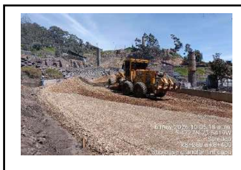
k8+240 a k8+400, conformación sub base granular primera y segunda capa
