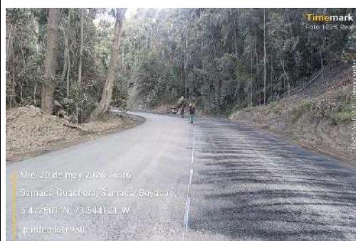
k8+890, riego de liga para instalación mezcla asfáltica segunda capa.
