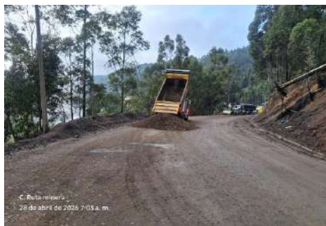
k6+570 a k6+890, suministro base granular primera capa.
