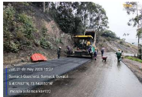
k9+010, instalación mezcla asfáltica segunda capa.
