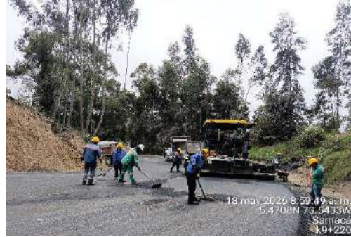
k9+220, instalación mezcla asfáltica segunda capa.
