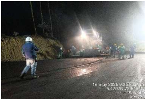
k9+040 a k7+370, instalación mezcla asfáltica (MDC 19), segunda capa.
