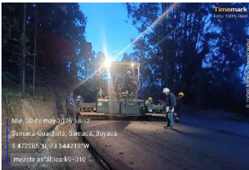
k9+070, seguimiento y control temperatura mezcla asfáltica segunda capa.
