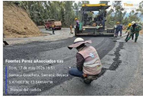
k9+040 a k7+370, instalación mezcla asfáltica (MDC 19), primera capa.
