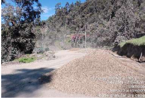
k9+500 a k9+700, suministro y descargue base granular 3ra capa
