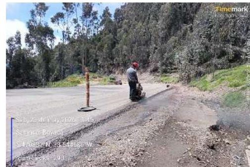
k9+250 a k9+370, corte asfalto para construcción cunetas, margen izquierda.
