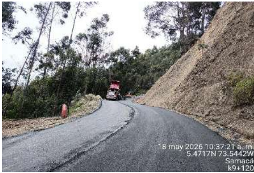
k9+120, instalación mezcla asfáltica segunda capa.
