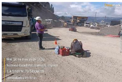
k8+770 a k8+400, toma densidades y contramuestra base granular tercera capa.
