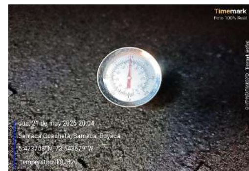
k8+830, seguimiento y control temperatura mezcla asfáltica segunda capa.
