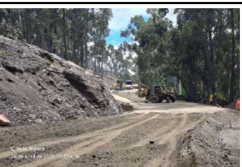
k6+890 a k7+220, instalación y conformación base granular segunda capa.
