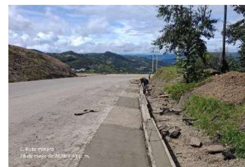
k8+700 a k8+880, concreto 21mpa cunetas margen izquierda
