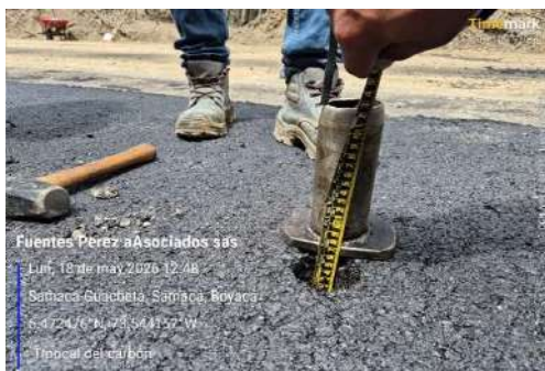
control y seguimiento espesores en instalación mezcla asfáltica
