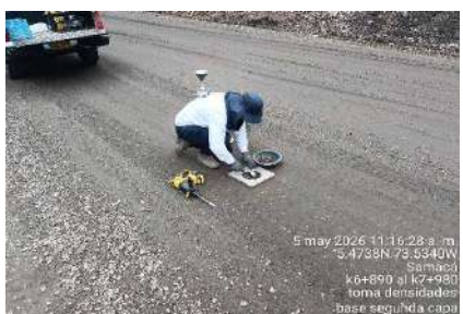
k6+890 a k8+000, toma densidades base granular
