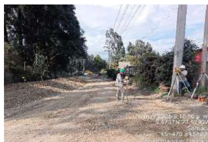
k5+350 a k6+370, localización replanteo y niveles base granular 1ra capa
