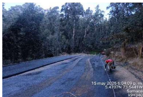
k9+000 a k9+370, punteo eje y bordes de vía para instalación de mezcla asfáltica
