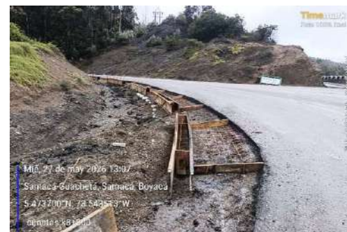
k8+700 a k8+880, encofrado cunetas margen izquierda
