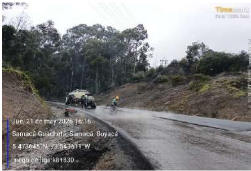
k8+870, riego de liga para instalación mezcla asfáltica segunda capa.
