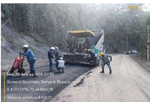
k8+890, riego de liga para instalación mezcla asfáltica segunda capa.
