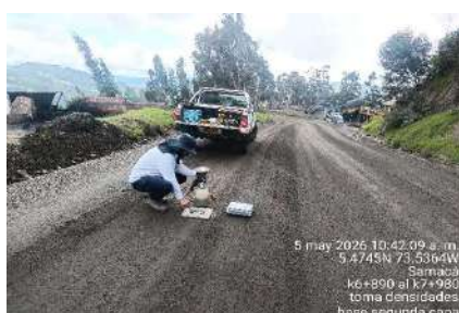
k6+890 a k8+000, toma densidades base granular
