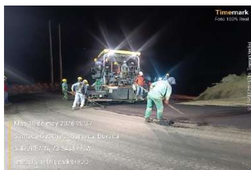
k8+820, instalación mezcla asfáltica primera capa.
