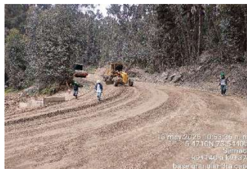
k9+000 a k9+370, céreo base granular tercera capa.
