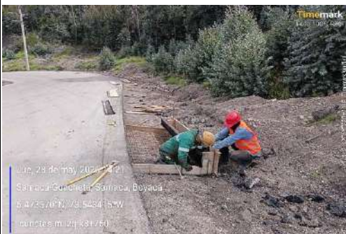
k8+700 a k8+880, encofrado cunetas margen izquierda
