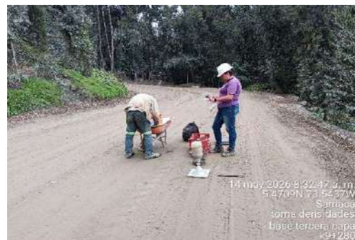
k9+880 a k9+370, toma densidades y contramuestra base granular 3ra capa.
