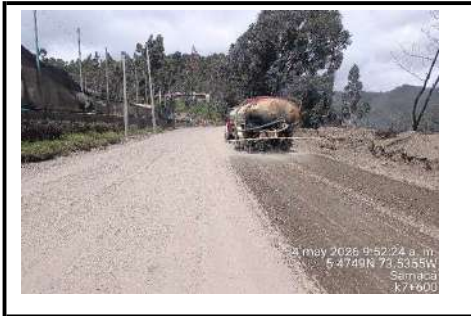
k7+520 a k8+000, humectación y compactación base granular tercera capa.
