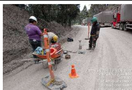
k6+890 a k8+000, toma contramuestra densidades base granular
