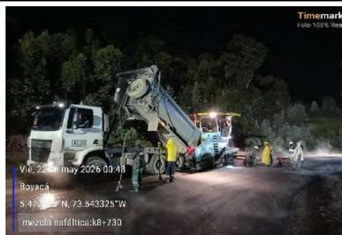
k8+830, instalación mezcla asfáltica segunda capa.
