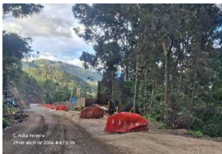
actividades área SST, señalización de obra
