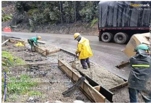
k8+700 a k8+880, instalación concreto 21mpa cunetas margen izquierda
