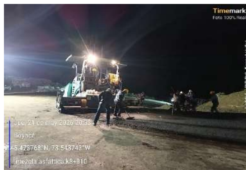
k8+830, instalación mezcla asfáltica segunda capa.
