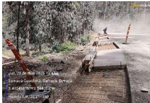
k9+270 a k9+370, instalación malla electrosoldada cunetas margen izquierda
