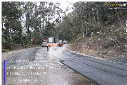
k8+920, instalación mezcla asfáltica segunda capa.
