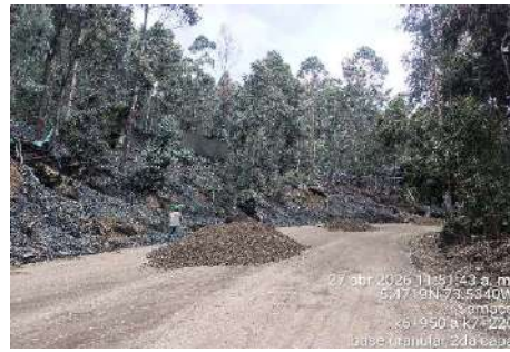
k6+370 a k6+890, localización, replanteo y niveles base granular.
