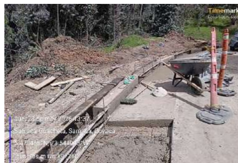
k9+270 a k9+370, concreto 21mpa cunetas margen izquierda
