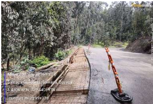
k9+270 a k9+370, encofrado cunetas margen izquierda
