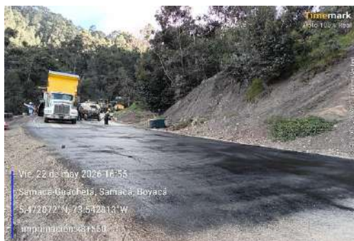
k8+560, imprimación para instalación mezcla asfáltica primera capa.
