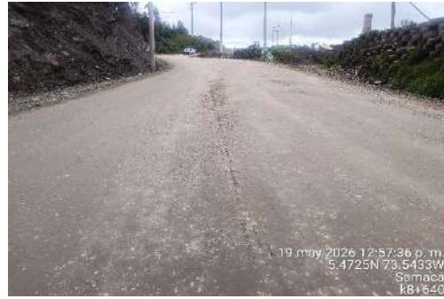
k8+640, base granular tercera capa.
