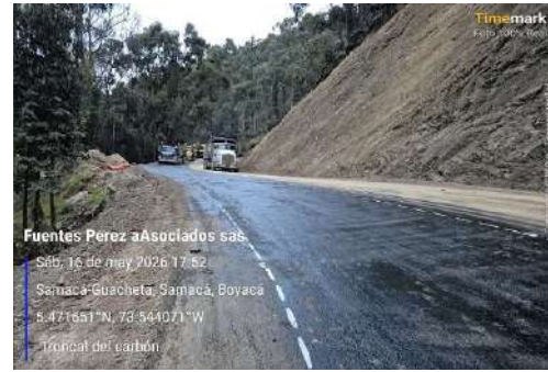
k9+040 a k7+370, imprimación para mezcla asfáltica
