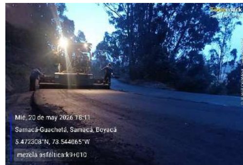
k9+070, seguimiento y control temperatura mezcla asfáltica segunda capa.
