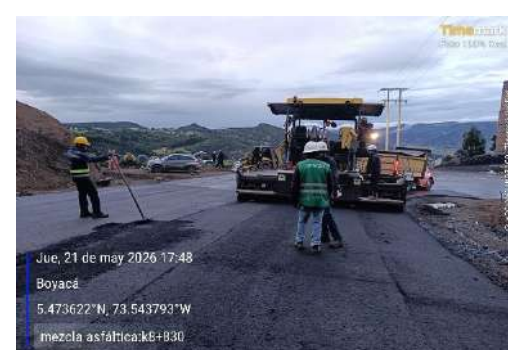
k8+830, instalación mezcla asfáltica segunda capa.
