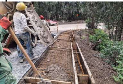
k9+270 a k9+370, instalación concreto 21mpa cunetas margen izquierda
