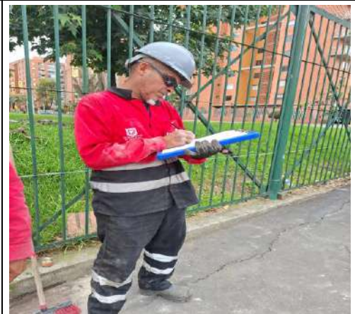
Foto 15. Charla de seguridad pausas activas al personal frente de obra Parque Salitre. FUENTE: Elaboración propia
