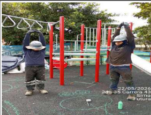
Foto 31. Charla de seguridad y pausas activas en el frente de obra Futura.
