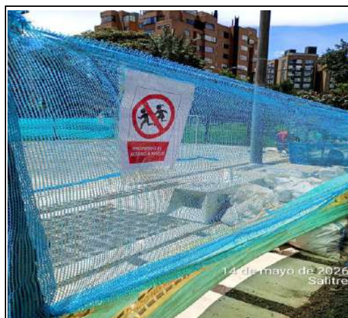
Foto 42. Inspección de señalización preventiva informativa y de obligatoriedad frente de obra Salitre.
