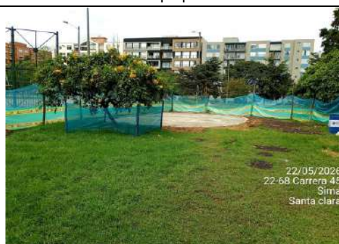
Foto 57. Jornada de orden aseo y limpieza en el frente de obra Santa clara.
