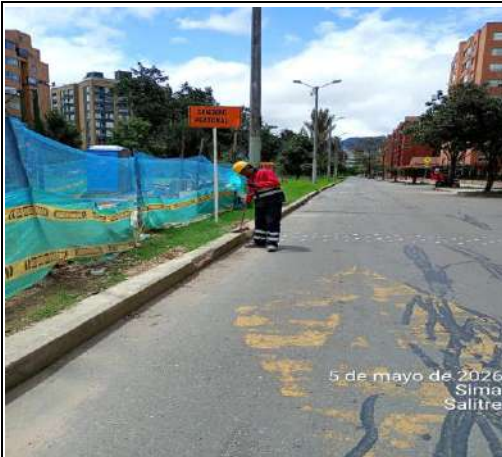
Foto 48. Jornada de orden aseo y limpieza en el frente de obra Salitre.
