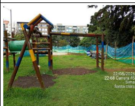
Foto 58. Jornada de orden aseo y limpieza en el frente de obra Santa clara.
