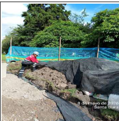
Foto 55. Jornada de orden aseo y limpieza en el frente de obra Santa clara.
