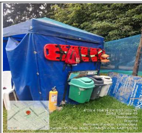
Foto 44. Inspección de kit de emergencias en el frente de obra Santa Clara.
