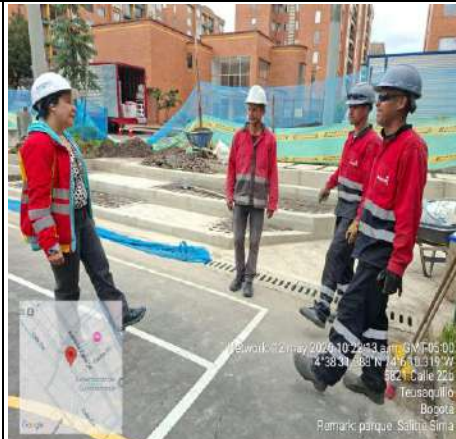
Foto 17. Charla de seguridad pausas activas al personal frente de obra Parque Salitre. FUENTE: Elaboración propia
