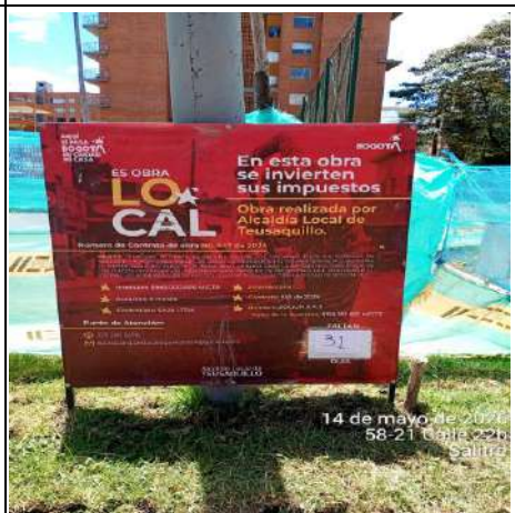
Foto 70. Instalación de valla en los frentes de obra Salitre. FUENTE: Elaboración propia
