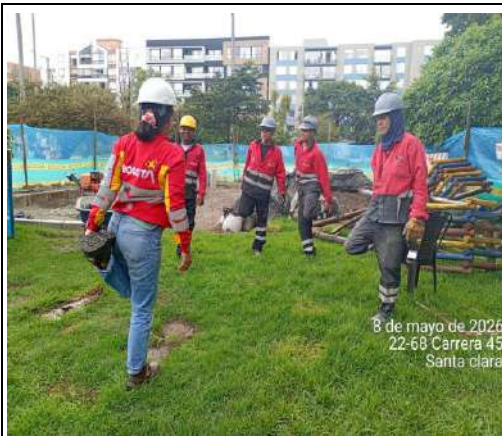
Foto 7. Capacitación y pausas activas al personal frente de obra Parque Santa Clara. FUENTE: Elaboración propia
