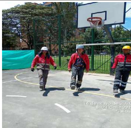
Foto 11. Charla de seguridad pausas activas al personal frente de obra Parque Salitre. FUENTE: Elaboración propia
