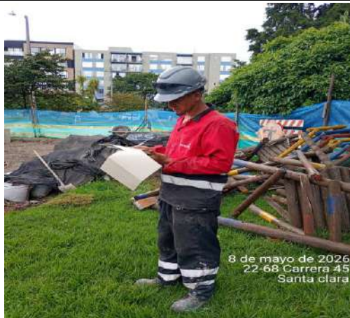
Foto 25. Inspeccion y entrega de EPP en el frente de obra Santa clara.
