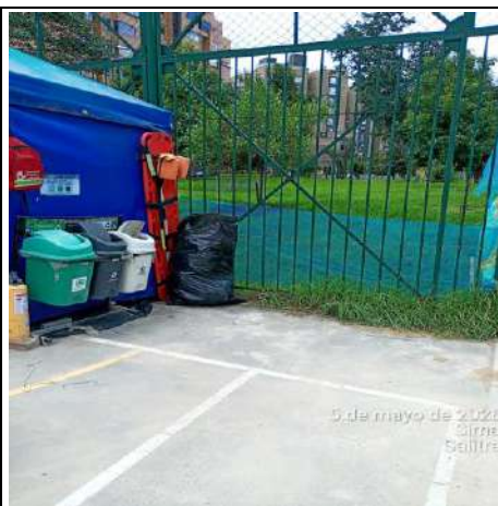
Foto 43. Inspección de kit de emergencias en el frente de obra Salitre.
