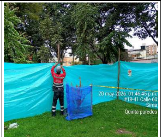
Foto 62. Mantenimiento de cerramiento perimetral en el frente de obra Quinta paredes.
