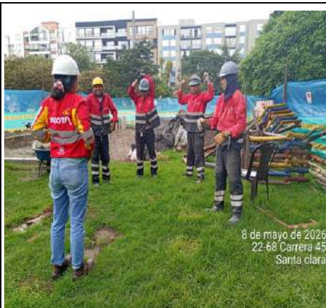
Foto 8. Capacitación y pausas activas al personal frente de obra Parque Santa Clara. FUENTE: Elaboración propia
