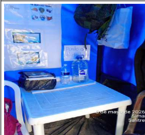
Foto 45. Instalación de cartelera SST y punto de hidratación en el frente de obra Salitre.
