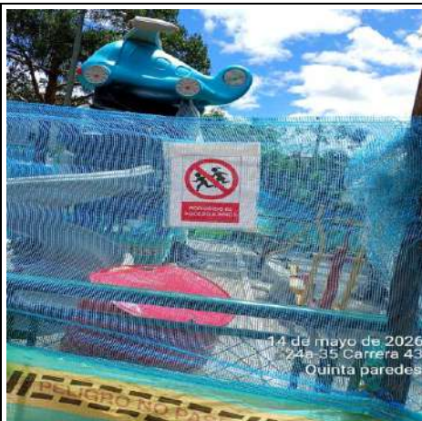
Foto 37. Inspeccion de señalización preventiva informativa y de obligatoriedad frente de obra Parque Quinta paredes.
