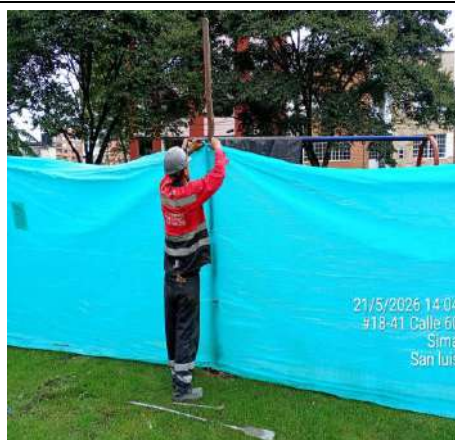
Foto 61 Mantenimiento de cerramiento perimetral instalacion señalizacion en el frente de obra San Luis.
