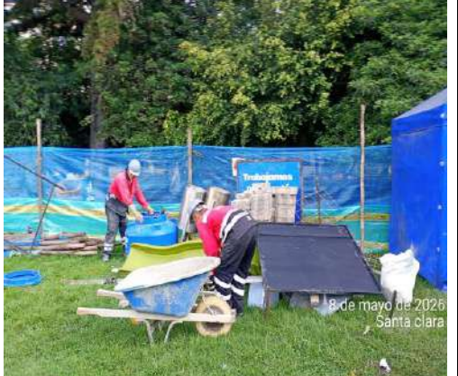
Foto 53. Jornada de orden aseo y limpieza en el frente de obra Santa clara.
