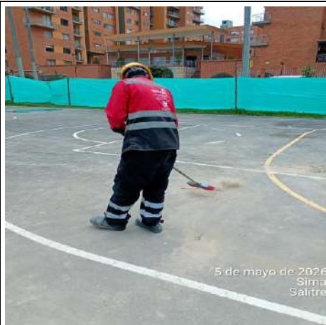
Foto 49. Jornada de orden aseo y limpieza en el frente de obra Salitre.
