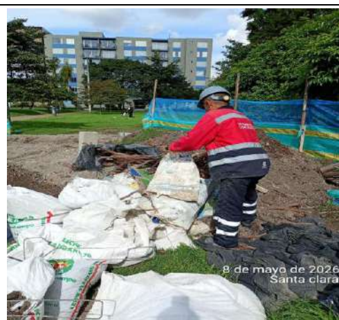
Foto 56. Jornada de orden aseo y limpieza en el frente de obra Santa clara.
