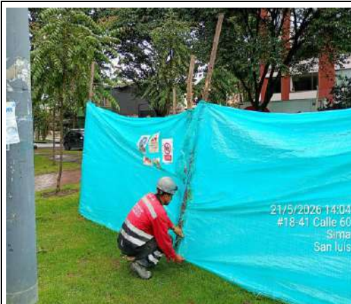
Foto 60. Mantenimiento de cerramiento perimetral en el frente de obra San Luis.
