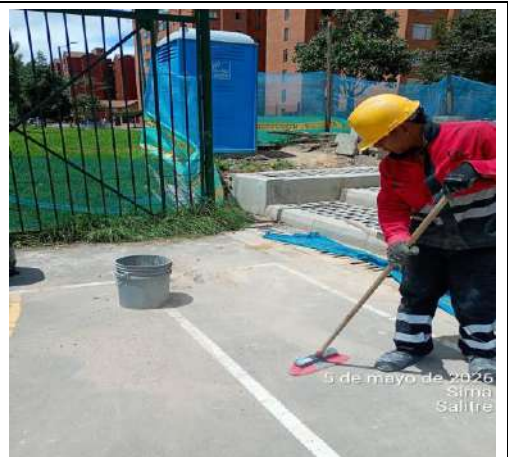
Foto 50. Jornada de orden aseo y limpieza en el frente de obra Salitre.
