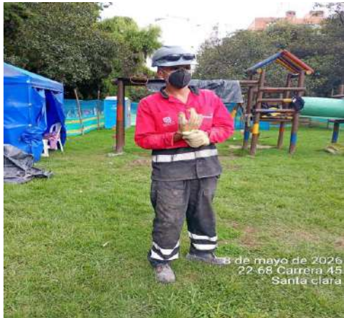
Foto 22. Inspeccion y entrega de EPP en el frente de obra Santa clara.
