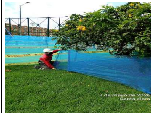
Foto 65. Cubrimiento de especies arboreas en el frente de obra Santa clara.
