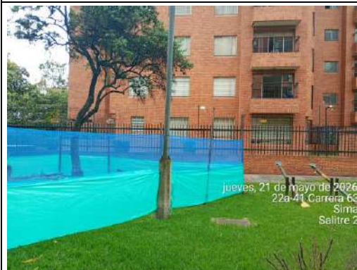
Foto 63. Instalacion de cerramiento perimetral el frente de obra Salitre 4.
