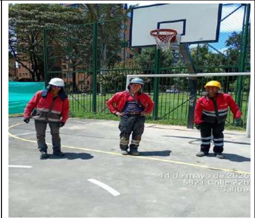
Foto 12. Charla de seguridad pausas activas al personal frente de obra Parque Salitre. FUENTE: Elaboración propia
