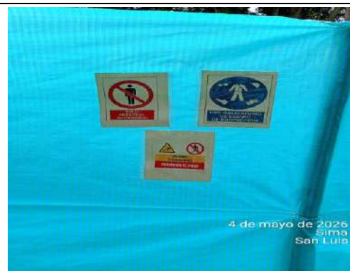
Foto 39. Inspeccion de señalización preventiva informativa y de obligatoriedad frente de obra San Luis.
