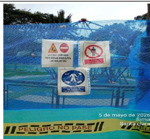
Foto 36. Inspeccion de señalización preventiva informativa y de obligatoriedad frente de obra Santa clara.
