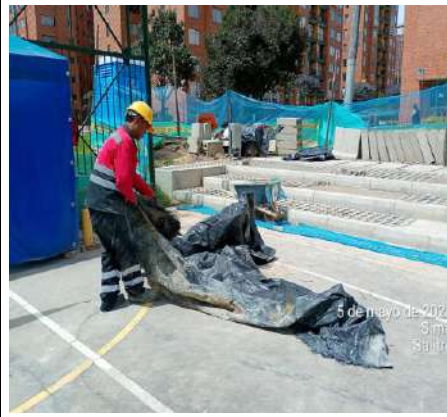
Foto 52. Jornada de orden aseo y limpieza en el frente de obra Salitre.
