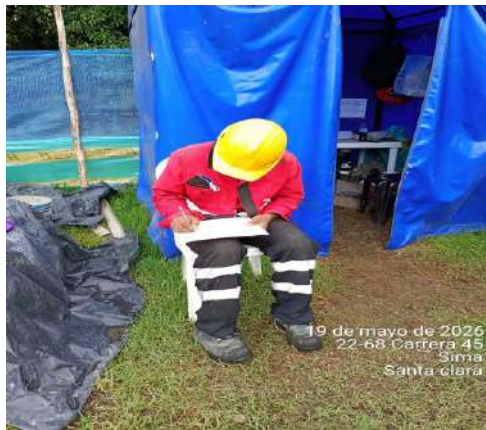
Foto 1. Inducción al personal obra en el frente de obra Santa Clara.
