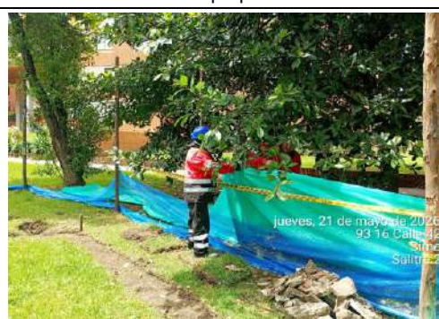
Foto 59. Instalacion de cerramiento perimetral el frente de obra Salitre 4.
