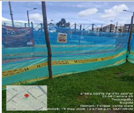
Foto 34. Inspeccion de señalización preventiva informativa y de obligatoriedad frente de obra Santa clara.
