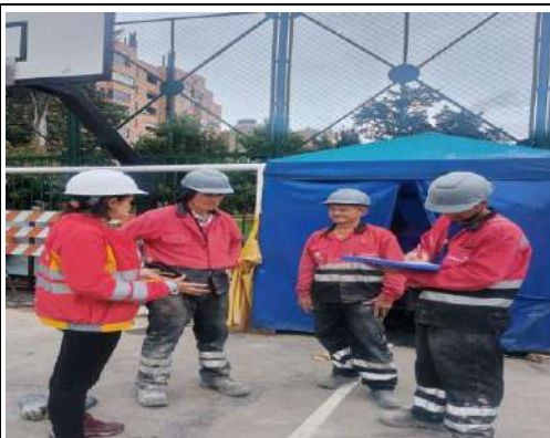
Foto 4. Charla de seguridad frente de obra Parque salitre.
