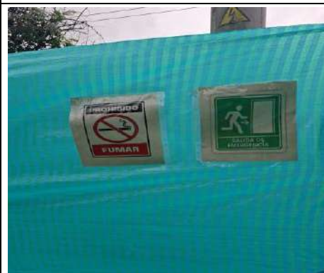
Foto 40. Inspeccion de señalización preventiva informativa y de obligatoriedad frente de obra San Luis.
