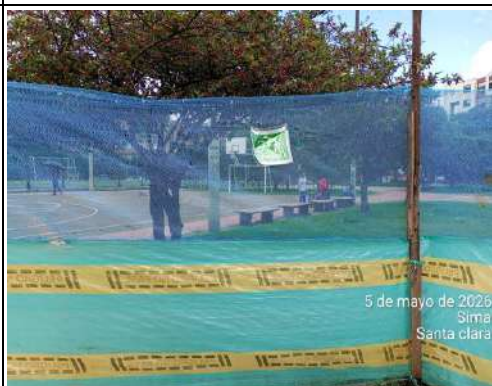
Foto 41. Inspeccion de señalización preventiva informativa y de obligatoriedad frente de obra Santa clara.
