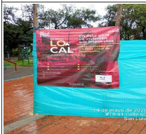
Foto 69. Instalación de valla en los frentes de obra San Luis. FUENTE: Elaboración propia
