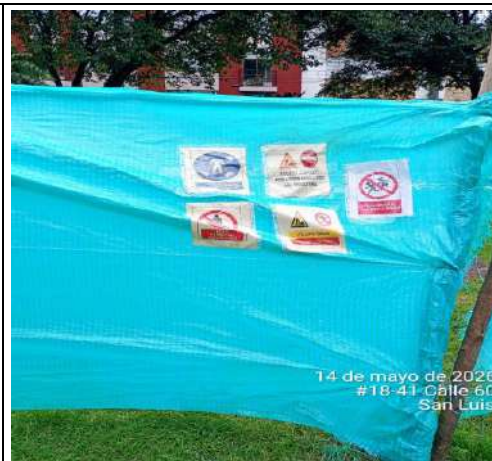
Foto 38. Instalacion señalización preventiva informativa y de obligatoriedad en el frente de obra Parque San Luis.
