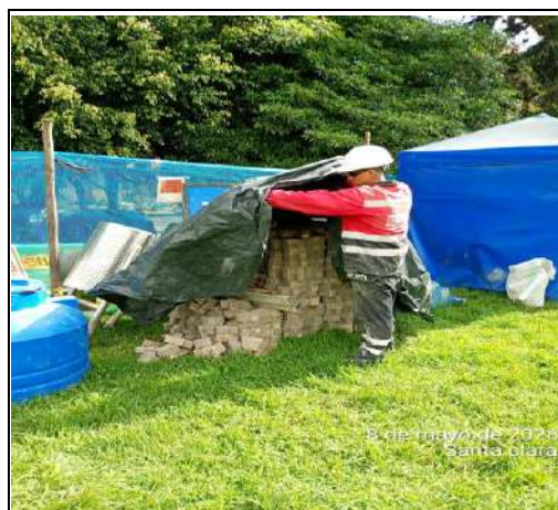
Foto 54. Jornada de orden aseo y limpieza en el frente de obra Santa clara.
