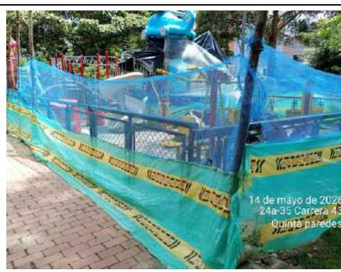
Foto 68. Mantenimiento de cerramiento perimetral en el frente de obra Quinta paredes. FUENTE: Elaboración propia
