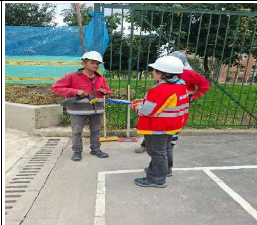
Foto 18 Charla de seguridad pausas activas al personal frente de obra Parque Salitre. FUENTE: Elaboración propia
