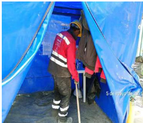
Foto 51. Jornada de orden aseo y limpieza en el frente de obra Salitre.
