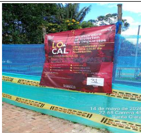
Foto 71. Instalación de valla en los frentes de obra Santa Clara. FUENTE: Elaboración propia
