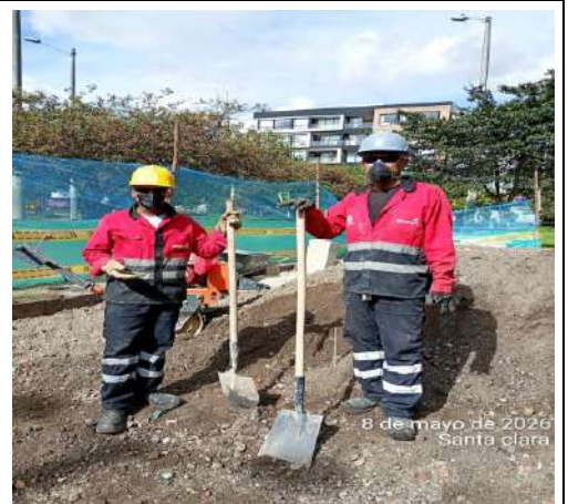
Foto 27. Inspeccion y entrega de EPP en el frente de obra Santa clara.
