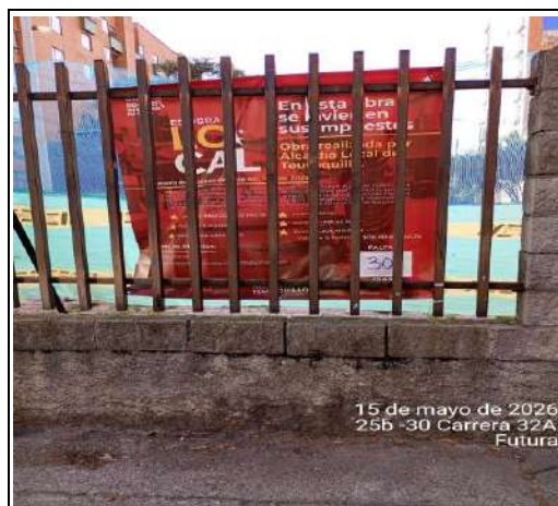
Foto 72. Instalación de valla en los frentes de obra Futura.
